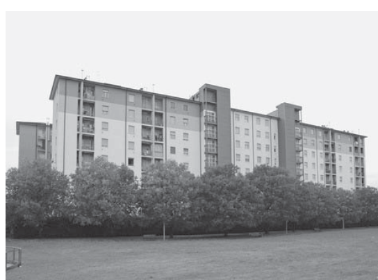
Figura 4.38- 4.39 L'edificio prima e dopo l'intervento.
