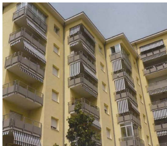
Figura 4.51- 4.52- 4.53 L'edificio prima e dopo l'intervento.
