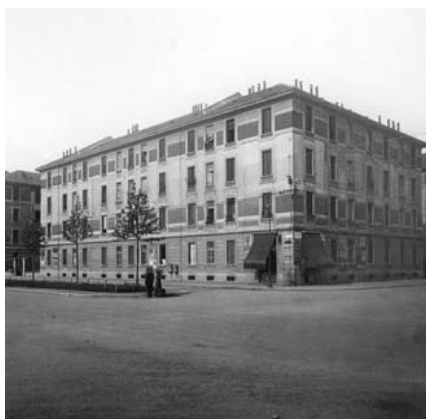
Figura 3.4 Milano. Il quartiere Niguarda (1913)
