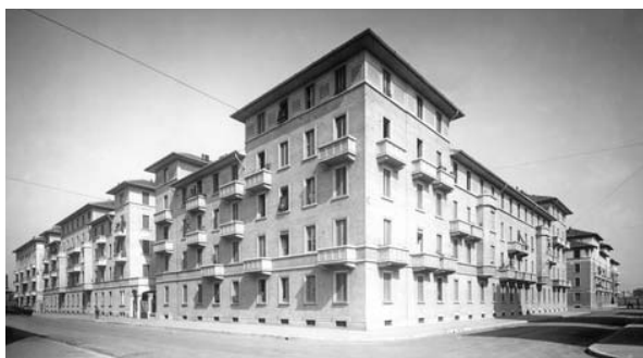
Figura 3.10 Milano. Quartiere Botticelli (1923-1930)
