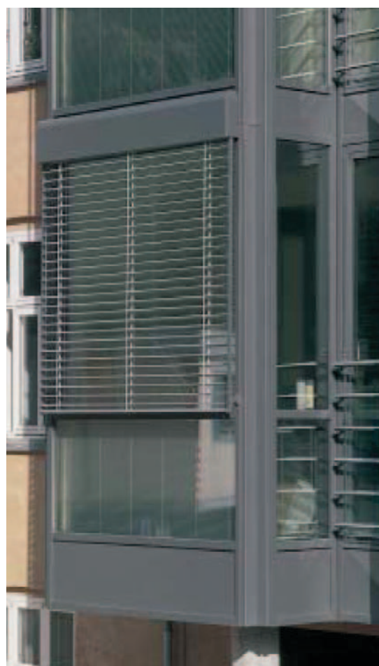
Figura 4.29- 4.30- 4.31 Viste del blocco. L'aggiunta dei nuovi volumi, il cui filo sporge rispetto a quello dei preesistenti vani scala, crea nuovi collegamenti vetrate a tutti i piani.
