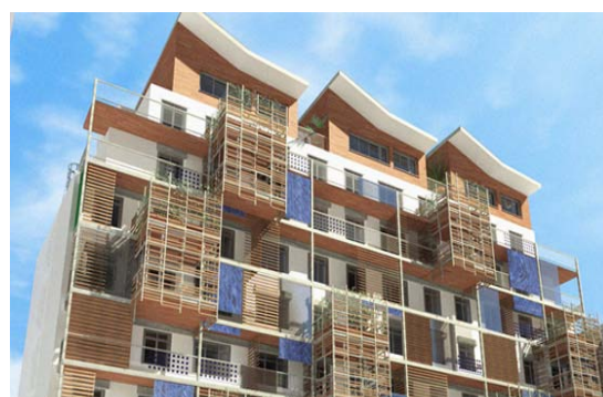
Figura 4.1- 4.2 L'edificio originale e il render dell'intervento.
