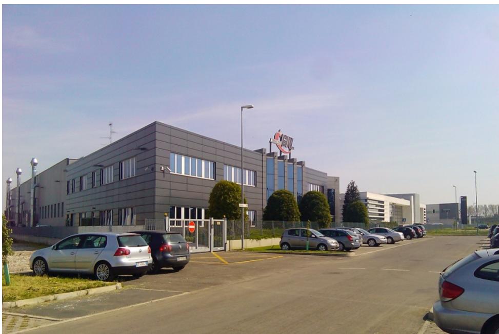
L'azienda confinante a sud ovest.
