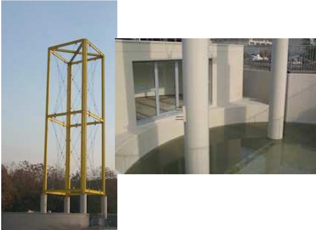
Figura 3.7: Torre di caduta e sala di controllo per le prove sperimentali
