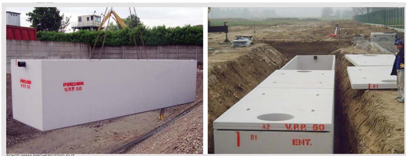
Fig. XIII-6 esempio di messa in opera di vasche di accumulo in cls
