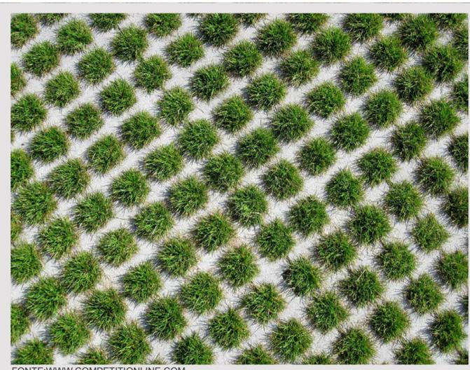
Fig. XIII-7 Esempio di pavimentazione permeabile (zona Nord)
