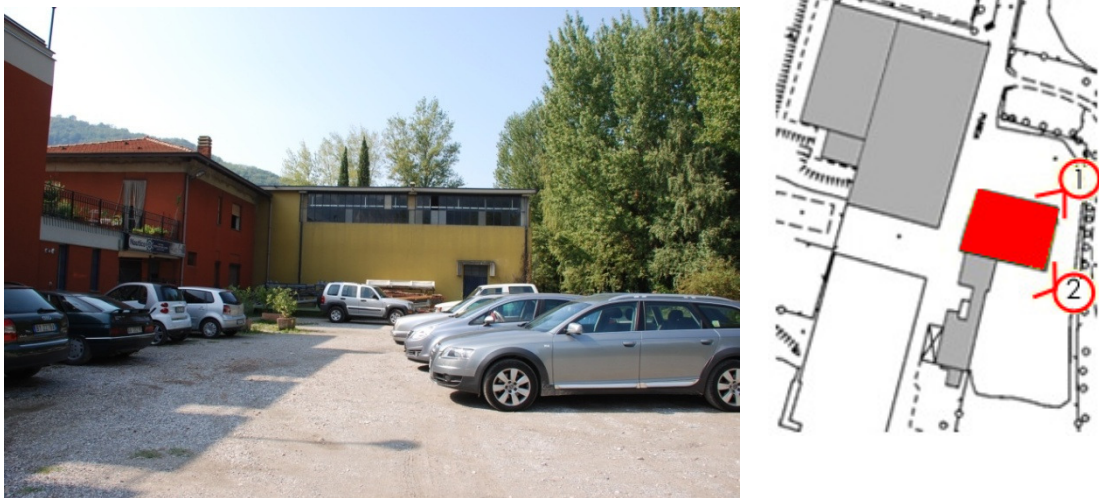
Figura 3.3-1 Vista della parte retrostante dell'edificio (2).
