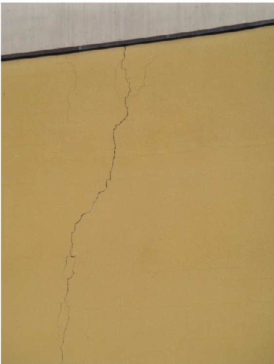
Figura 3.3-7 Figura 3.3-8 Degrado interno (1) ed esterno (2), prospetto Sud Degrado presente: fessurazione.
