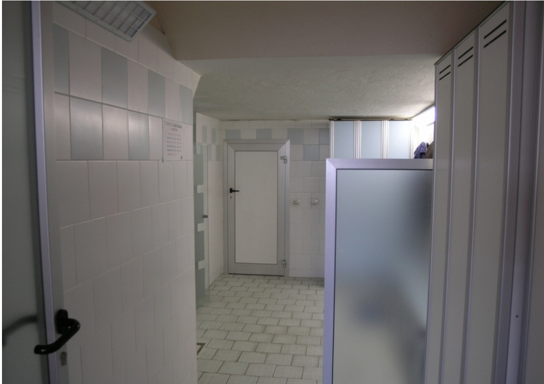
Figura 3.2-5 Vista interna di uno spogliatoio.
