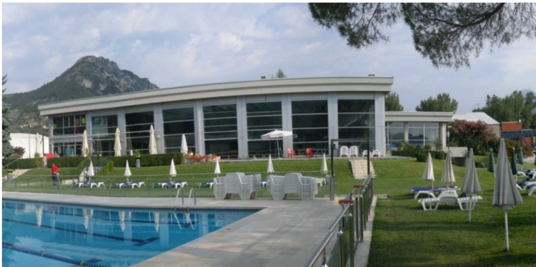
Figura 3.4-4 Vista del Prospetto Sud (3). La parte sinistra è occupata dalla zona ristoro, che si sviluppa anche all'esterno; al piano superiore c'è l'area amministrativa; il corpo centrale ospita la piscina; la porzione più piccola dell'edificio sulla destra è destinata alla piscina dei bambini. Si intravede in primo piano la piscina esterna circondata dalle sdraio.
