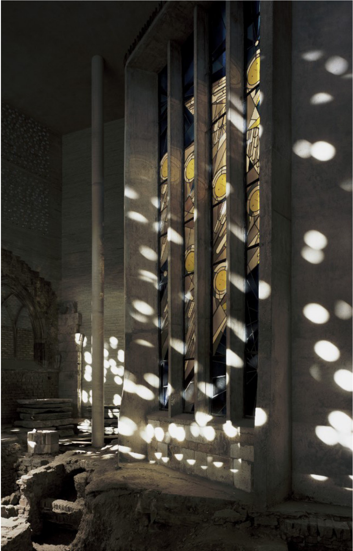
pt 1_cit 4_img 11 Punti di luce sulla parete interna della costruzione: è un effetto del filtermauerwerk, il risultato della luce che filtra attraverso le piccole e irregolari aperture
