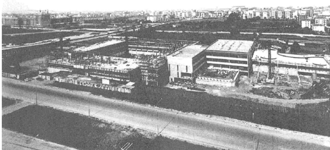
46. Il complesso di Via Malta di fronte al gasometro in costruzione
