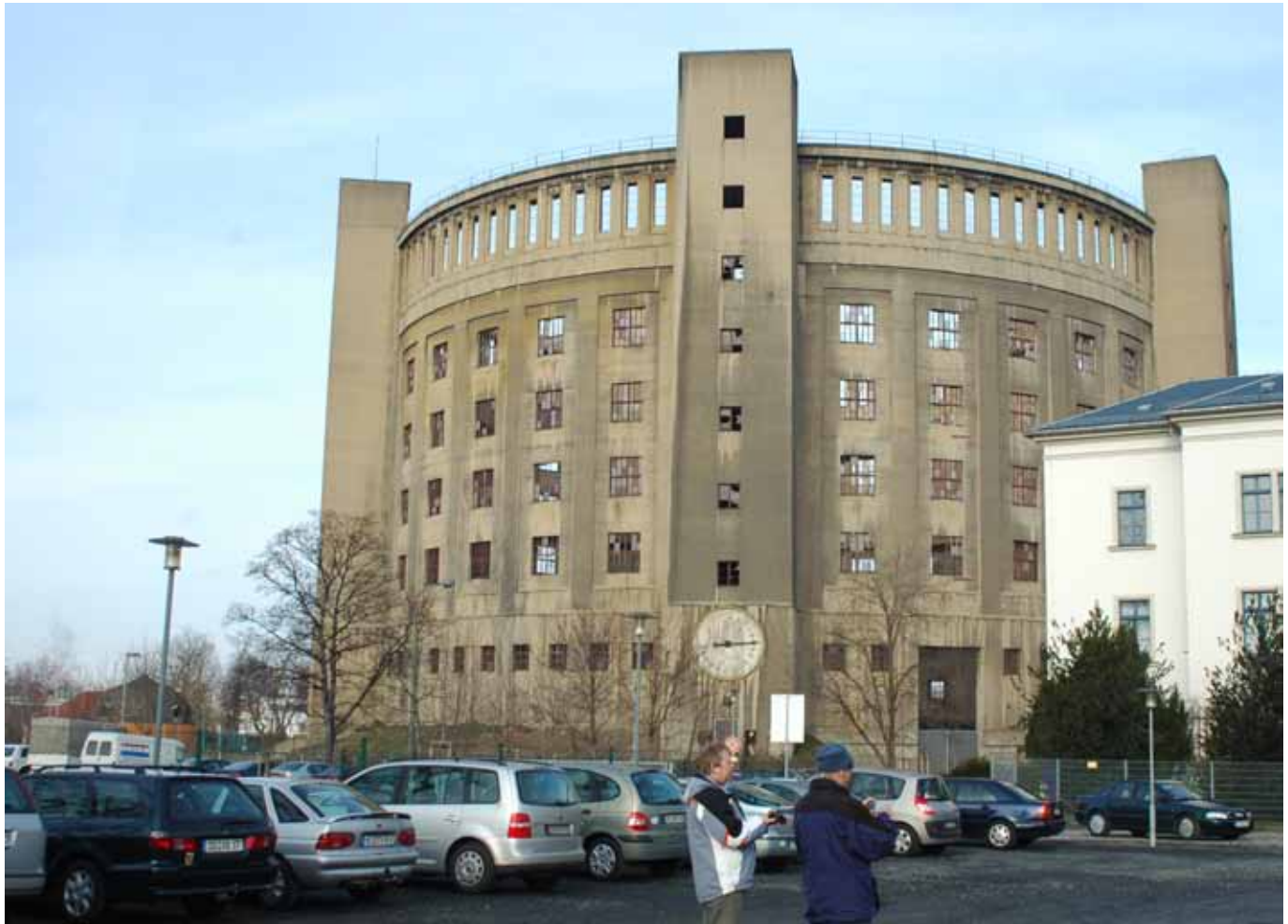
100. Il volume del gasometro di Dresda
