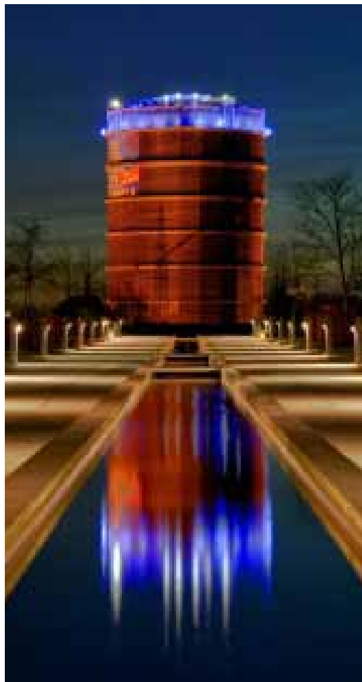
95. Vista notturna del gasometro di Oberhausen dal camminamento esterno
