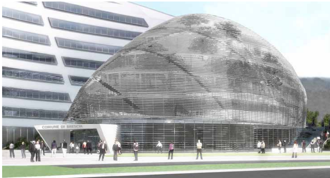
13. Veduta della piazza che porta all' hall d'ingresso
