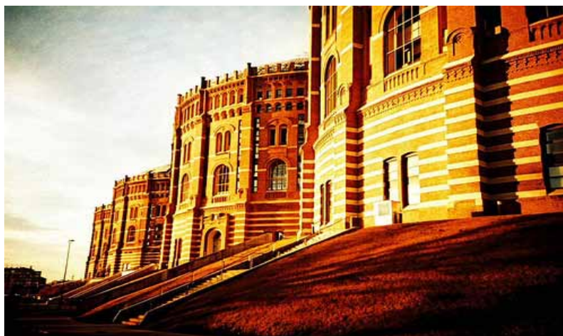
93. Vista degli ingressi ai 4 gasometri di Vienna
