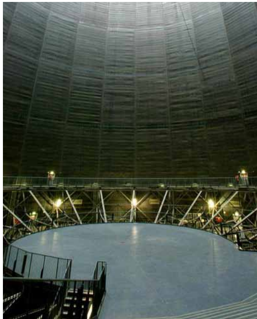
96. Viste interne del gasometro di Oberhausen
