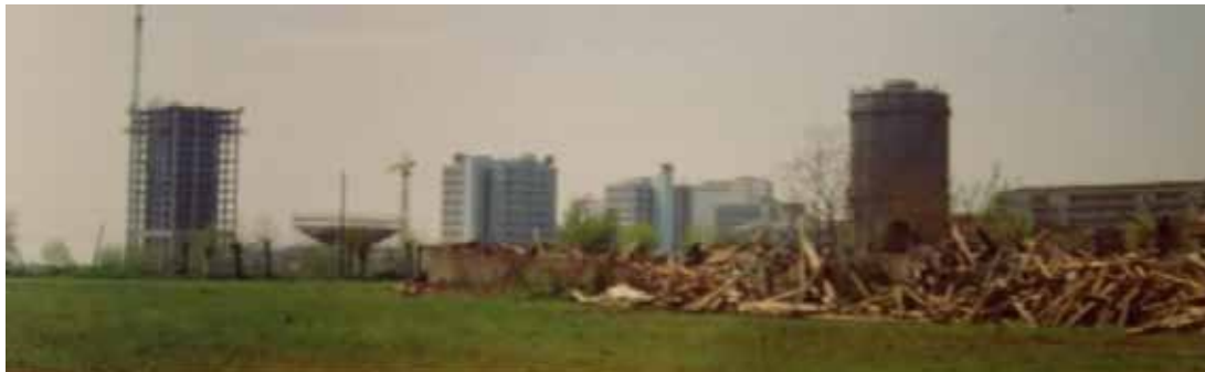
61. Il Crystal Palace e "il Matitone" in costruzione, a destra il gasometro e l'area adiacente dismessa
