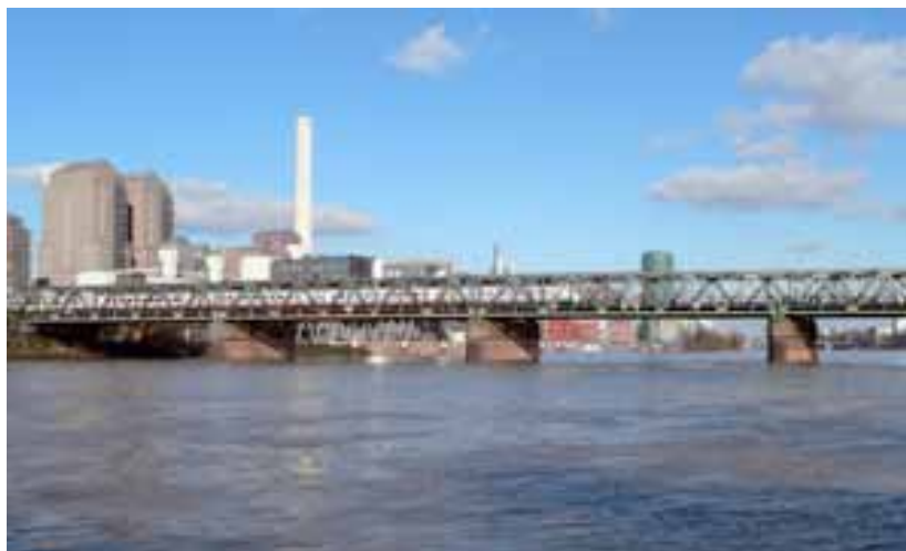
27_ Il Main Neckar Brücke e sullo sfondo gli edifici industriali in Westhafen
