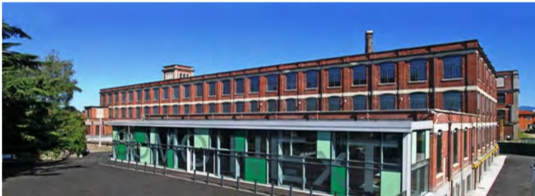
Figura 4.3 – Vista esterna struttura ComoNext
