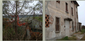
Il canale Piavolo nel punto in cui sottopassa la tangenziale
