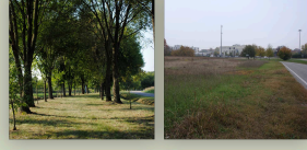
La Strada Trincerone
