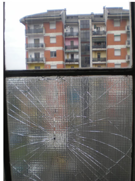
Fig. 202 Immagine di una delle torri dal vano scale del condominio A.
