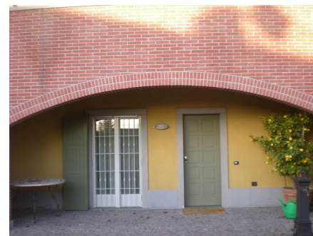
Fig. 108 Ingresso di una delle villette con ulteriori protezioni a guardia degli infissi.
