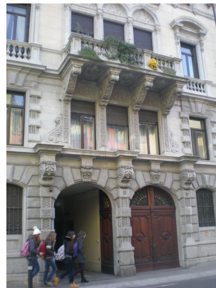
Fig. 52 Palazzo storico nella parte "alta" della Via.
