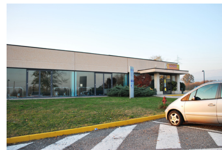
Fig. 115 La piscina, struttura privata ad uso pubblico, è stata costruita alla fine degli anni '90. Si trova all'ingresso a Sud-Est del Villaggio.
