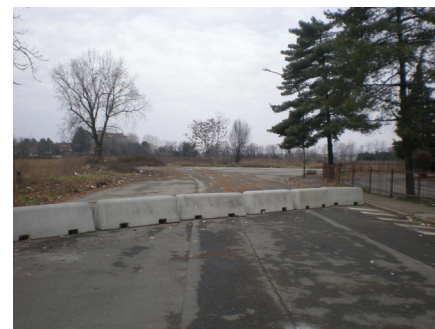
Fig. 9 Esempio di strada a fondo chiuso, di fronte alle Quattro Torri di Zingonia. In questo caso l’infrastruttura non ha proprio la funzione di connettere.
