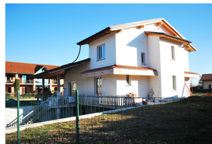
Fig. 145 Viste di una delle ville di nuova costruzione nella parte alta del Villaggio.
