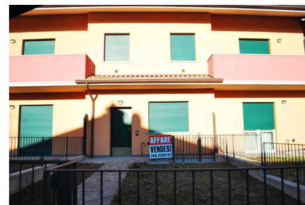
Fig. 133 Case a schiera di nuova edificazione in vendita nella parte Sud del Villaggio.
