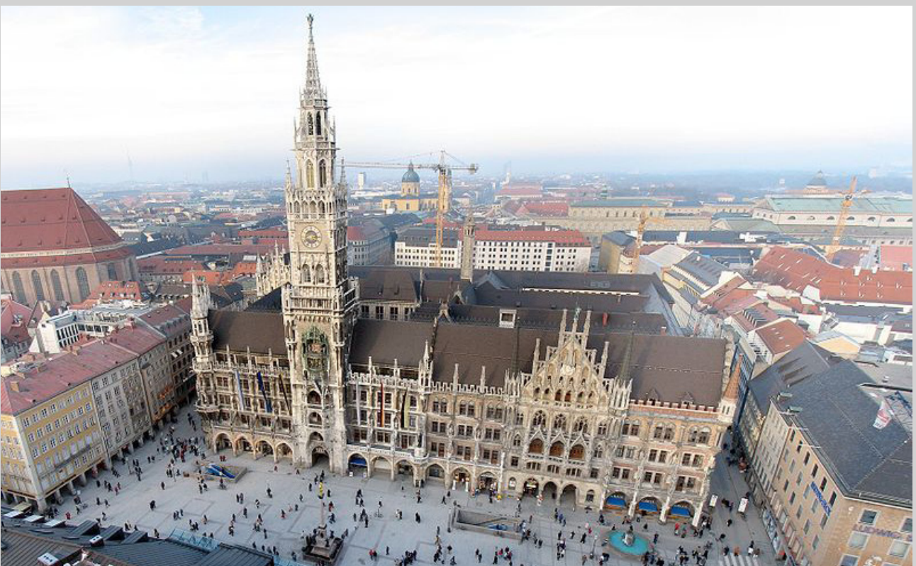
fig 17 Il Neues Rathaus su Marienplatz, su progetto di Georg Hauberisser eretto tra il 1867 ed il 1909
