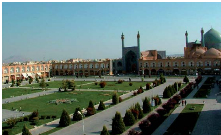
46. Vista del complesso.
