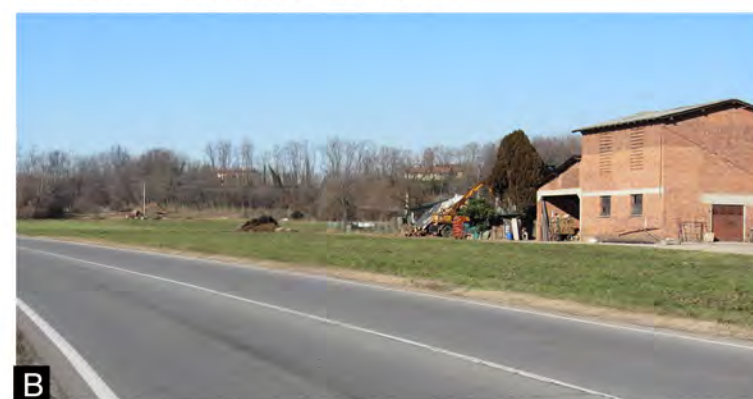
STRADA PROVINCIALE VIA MENTANA
