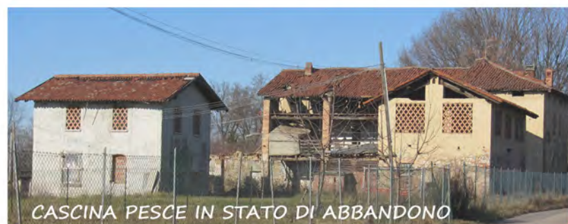
FERROVIA COMO-LECCO INTERRUZIONE CONTINUITA' PAESAGGISTICA
