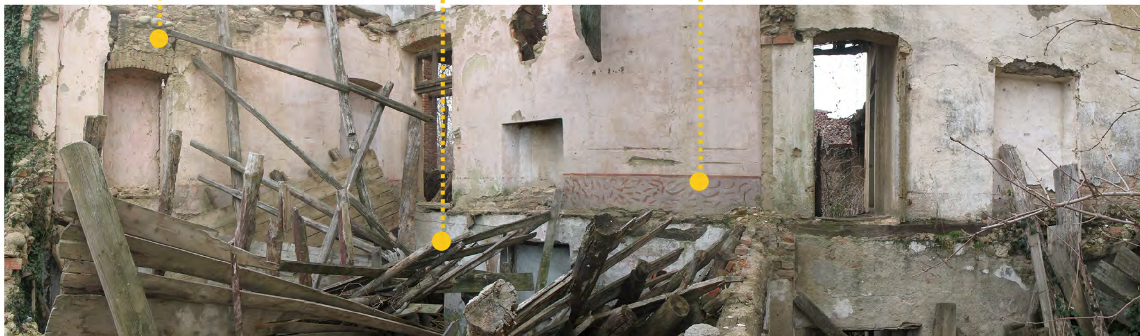
► Primo piano terzo corpo edilizio adibito a residenze.
