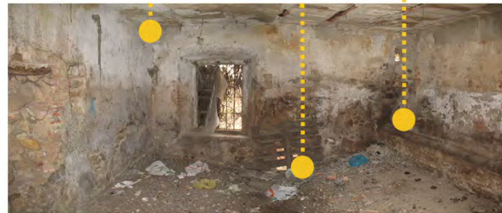
► Interno delle stalle.
