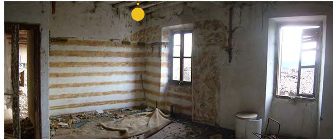
► Locale tipo localizzato al primo piano.
