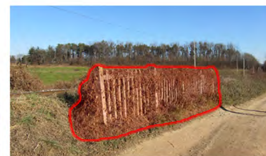
Rimozione vecchie barriere di protezione, ormai diventate inefficienti
