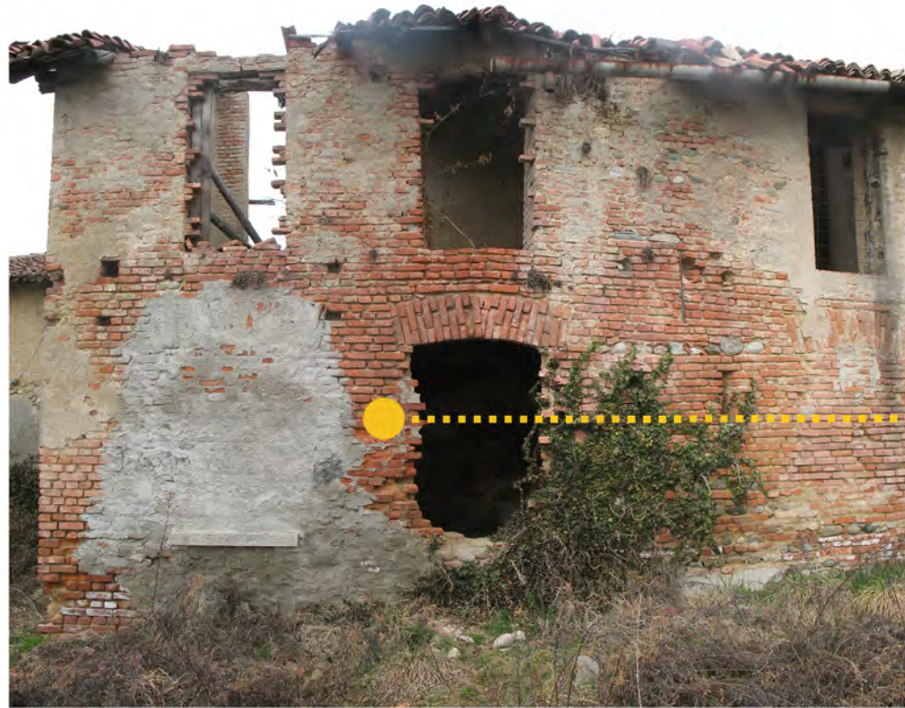
► Fronte sud di S.Naga. Zoom sulla facciata principale delle stalle
