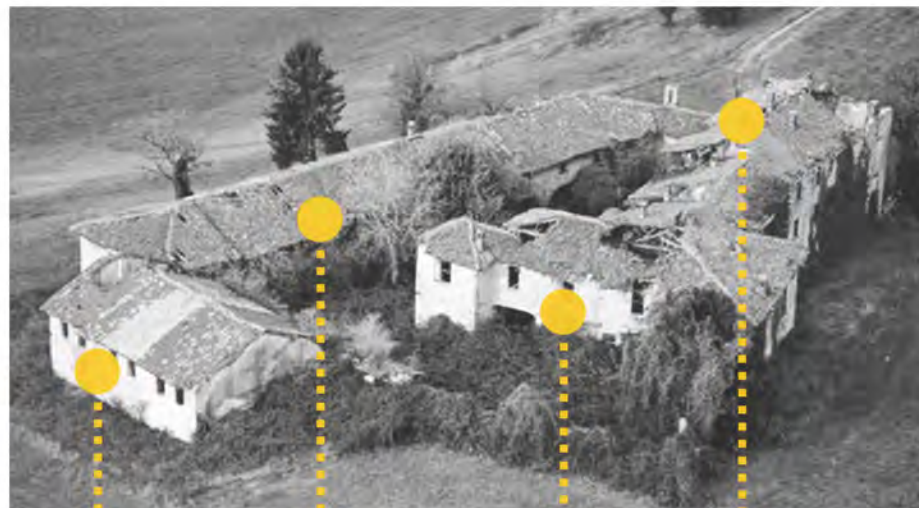
CORPO 1 STALLE E FIENILE CORPO 2 STALLE E FIENILE CORPO 3 RESIDENZE RETRO CASCINA CAPPELLA-INGRESSO
