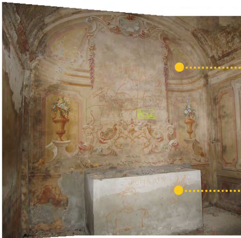
► Interno della cappella.
