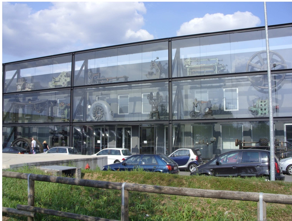
Vista dell'esterno del Musil di Rodengo Saiano
