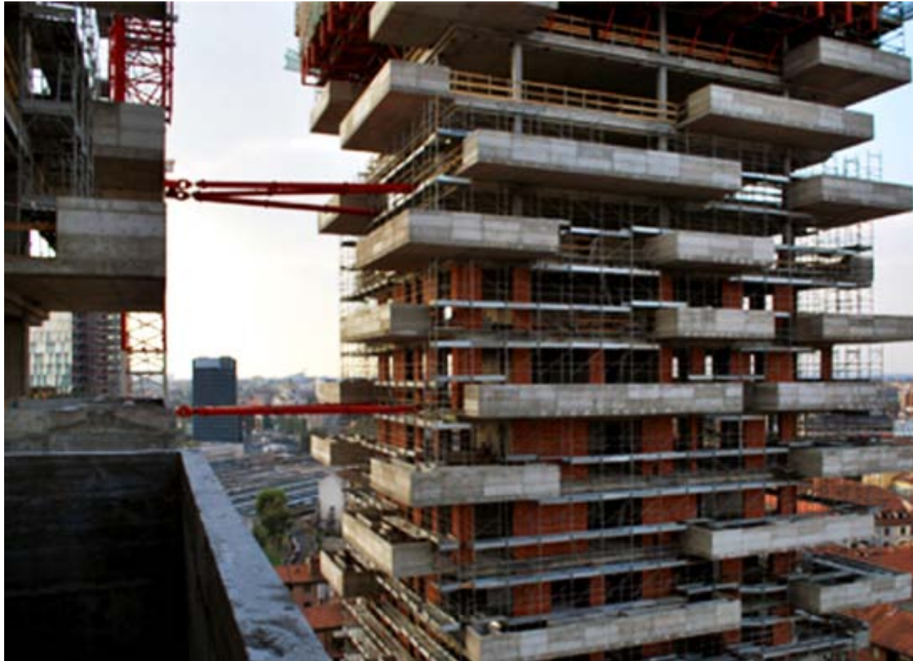
Cantiere Bosco Verticale
