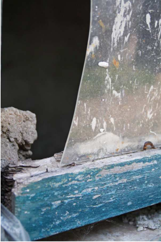
Fig. 2.2.8.8 – particolare dei serramenti dell'edificio numero 115
