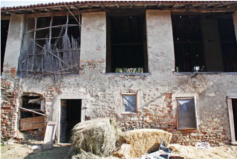
Fig. 2.2.8.3 – facciata Sud dell’edificio numero 96
