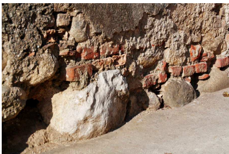
Fig. 2.2.8.5 – particolare della parete perimetrale dell'edificio numero 44
