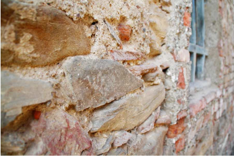
Fig. 2.2.8.6 – particolare della parete perimetrale dell'edificio numero 96
