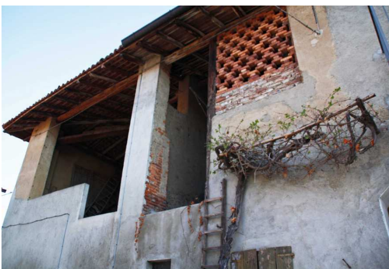
Fig. 2.2.8.1 – particolare della facciata esposta a Sud dell'edificio numero 44
