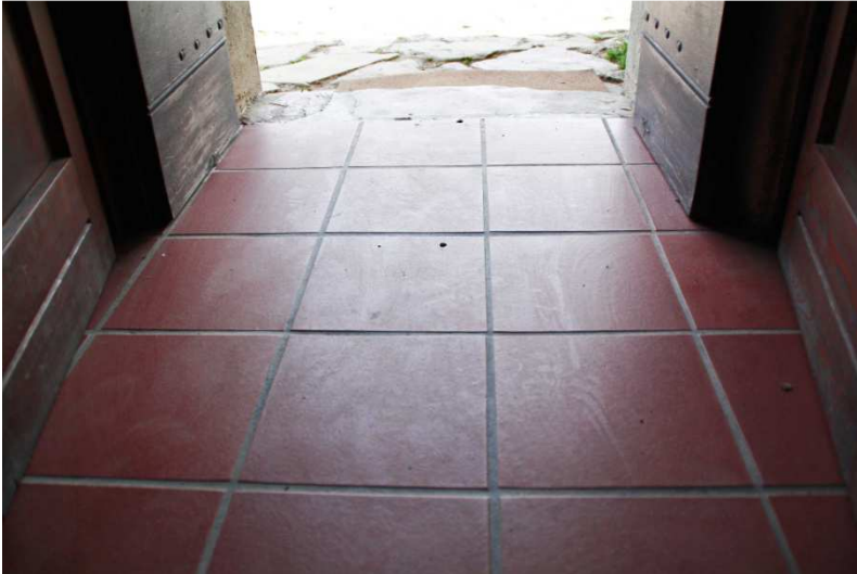
Fig. 3.3.2.1.6 – piastrelle del solaio a terra di Ca' Soldato
