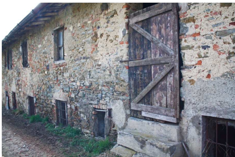
Fig. 2.2.8.4 – facciata Nord dell'edificio numero 114
