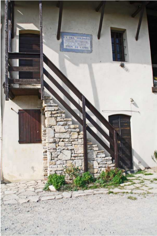
Fig.3.1.2 – particolare della facciata Nord di Ca' Soldato
