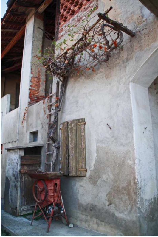
Fig. 2.2.8.2 – particolare della facciata esposta a Sud dell’edificio numero 44
