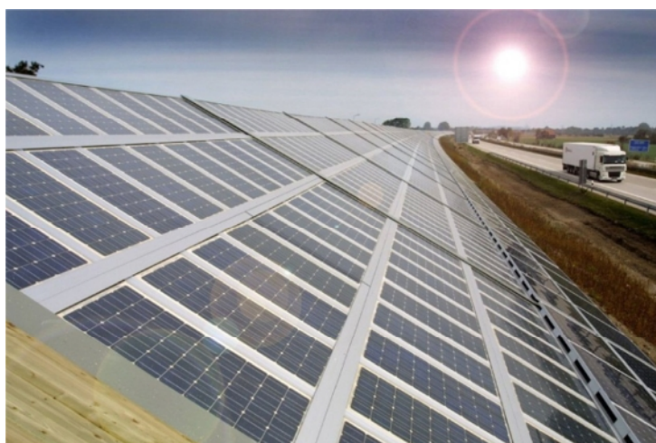
Figura 4 – Barriera antirumore fotovoltaica Monaco fonte: Photovoltaic barriers
