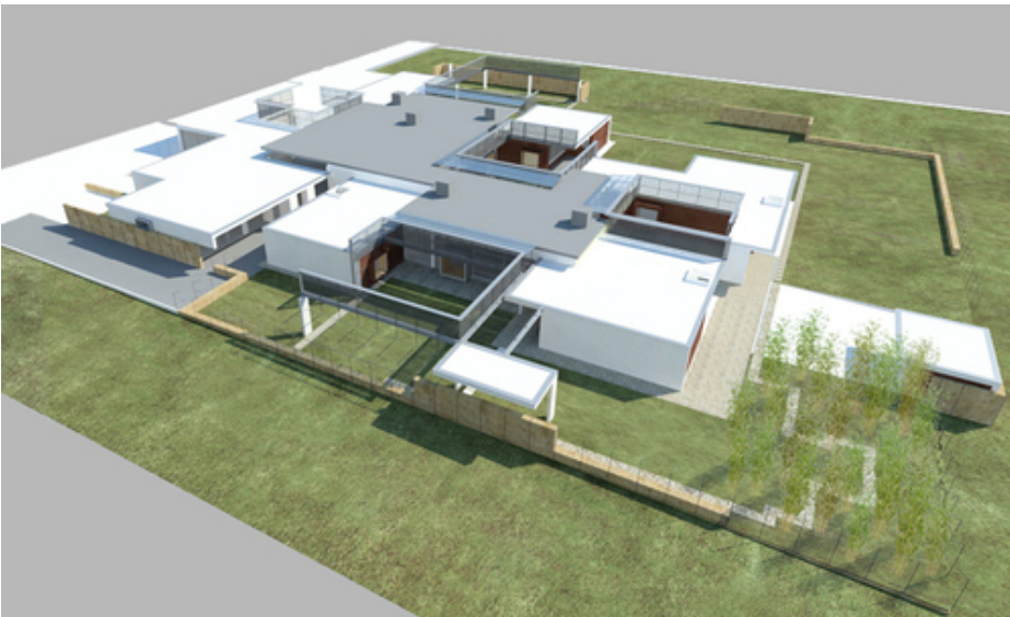
Vista esterna dall'alto
