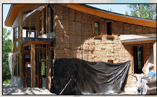
Esempio di costruzione con balle di paglia
