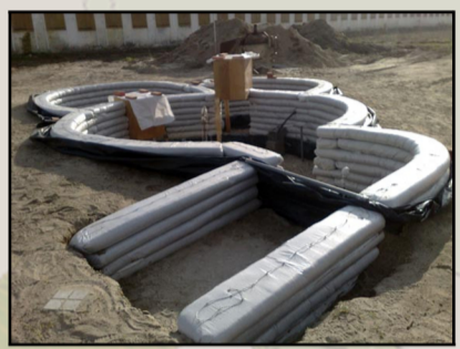
Esempio di costruzione con la tecnica super-adobe: muri e fondamenta
