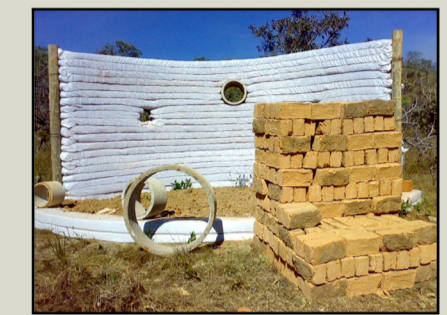
Esempio di costruzione con la tecnica super-adobe: muri e fondamenta
