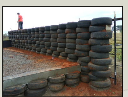
Esempio di costruzione con pneumatici: muri e fondamenta
