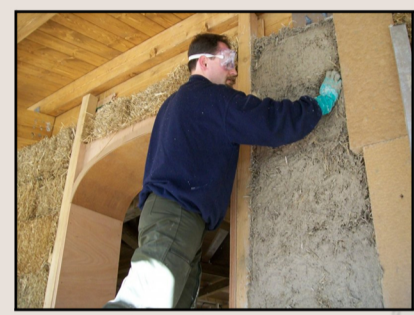
Esempio di costruzione con balle di paglia
