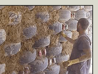
Esempio di costruzione con pneumatici: muri e fondamenta
