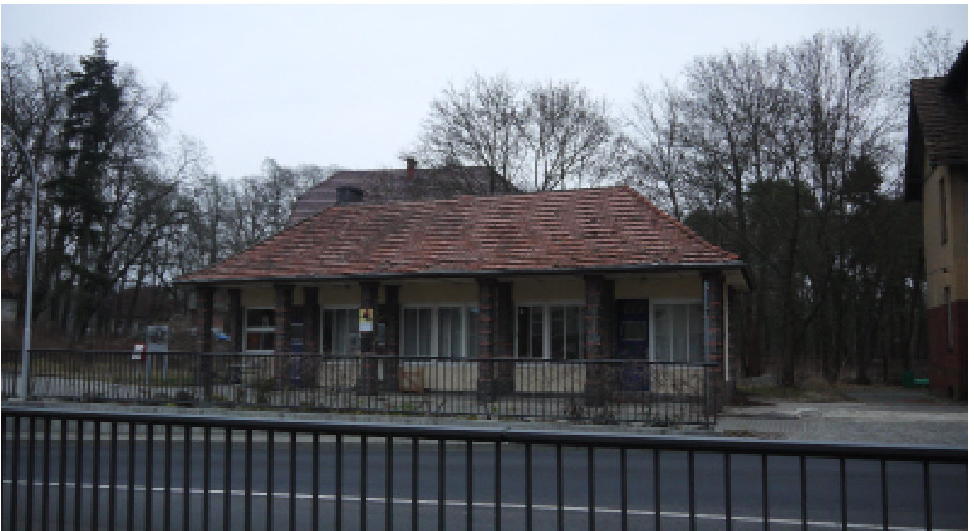
Area C - Edificio 18 _ Verkaufshäuschen
