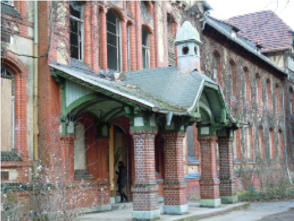
Area C - Edificio 3_ Pavillon für Männer
