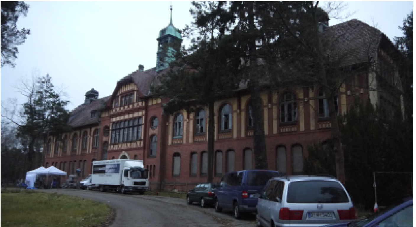
Area C - Edificio 2_ Zentral-Badehaus
