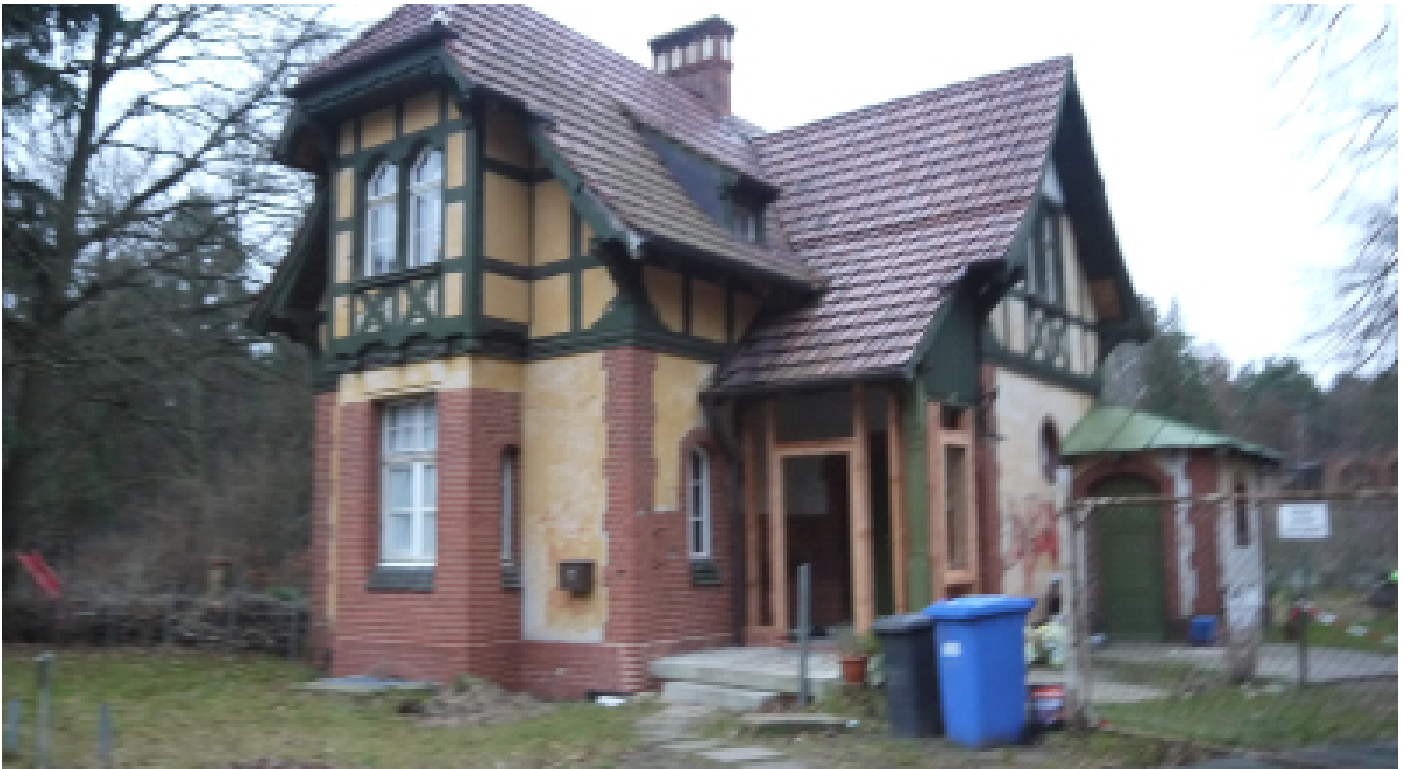
Area D - Edificio 1
