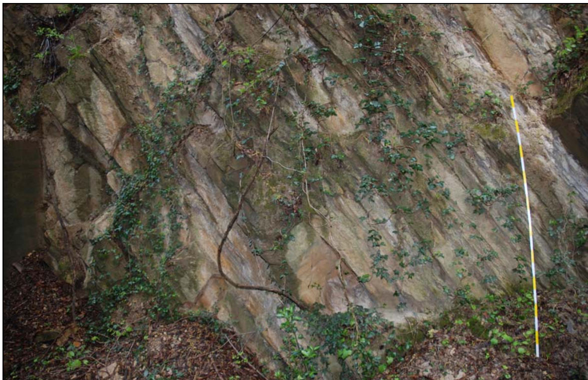
Figura 1.3: Stazione di rilievo nel corridoio di accesso alla miniera.
