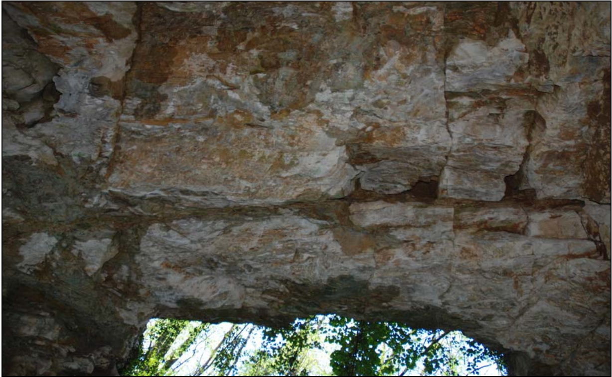
Figura 1.4: Stazione di rilievo in galleria.
