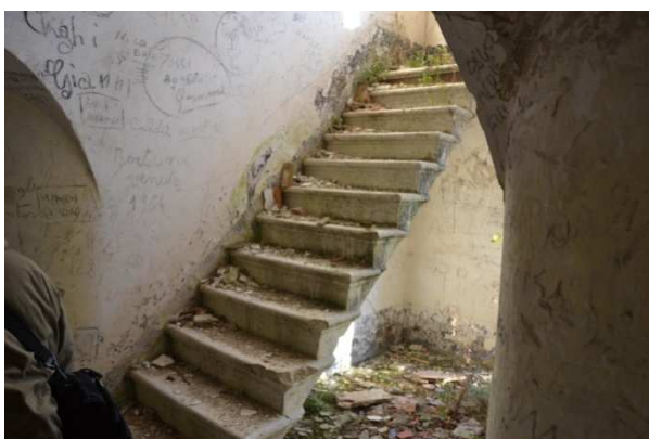
Figura 95 – scala di collegamento tra I due piani della caserma
