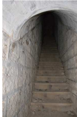
Figura 82- scala di accesso alla cannoniera dalla trincea del canale
