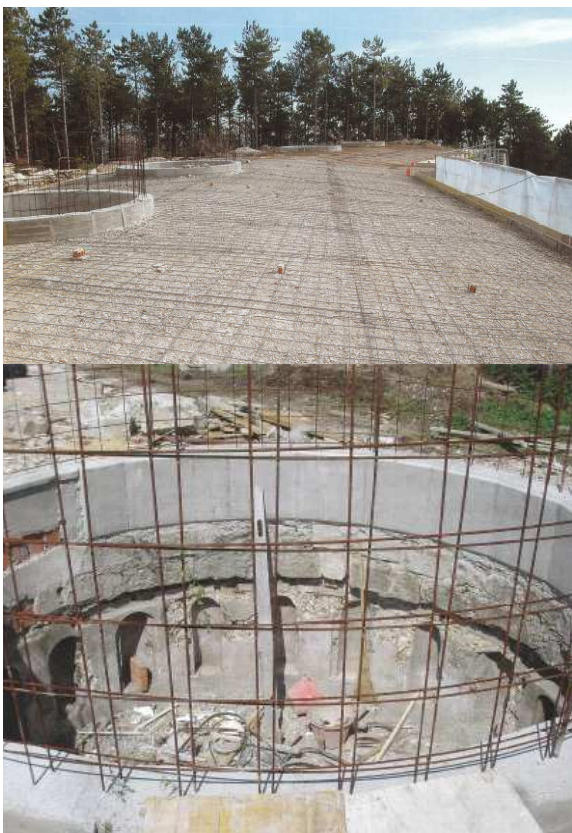
Figura 58-58-Ripristino della copertura e dei pozzi per cannoni(foto F.Meneghelli)
