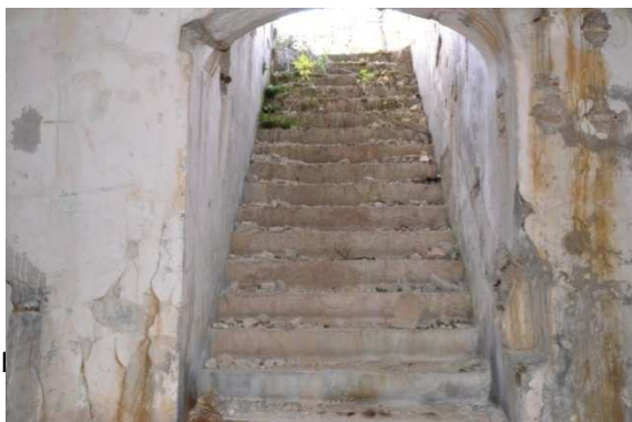
Figura 84 – scala di accesso ai pozzi dei cannoni
