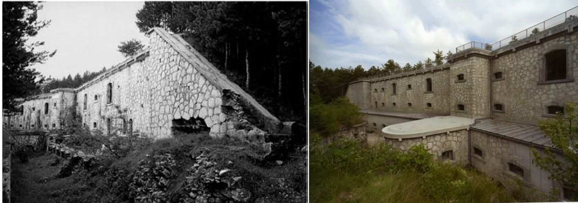
Figura 54-55 Forte Santa Viola prima e dopo l'intervento (foto di F.Meneghelli)
