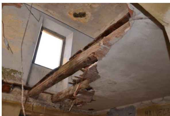
Figura 96 – solai della caserma
