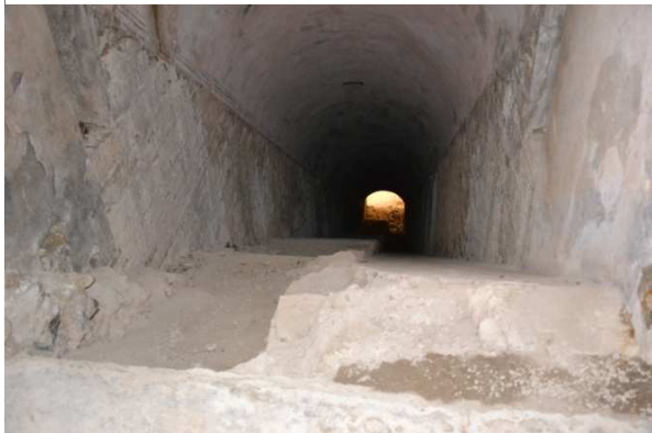
Figura 83- scala di accesso alla cannoniera dal piazzale del forte
