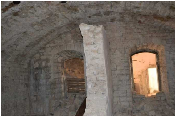
Figura 93 – vista dalla sala munizioni
