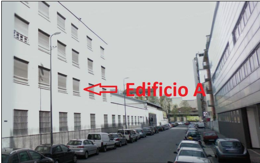
Figura 3.4: Vista dall'incrocio tra via Piazza e via Bernina
