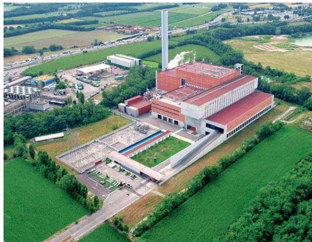
Figura 4 - Il termovalorizzatore Silla 2 di Milano (Fonte: amsa.it )
