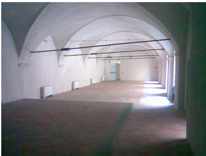
Figura 153-2° cortile-corpo nord-1° piano
