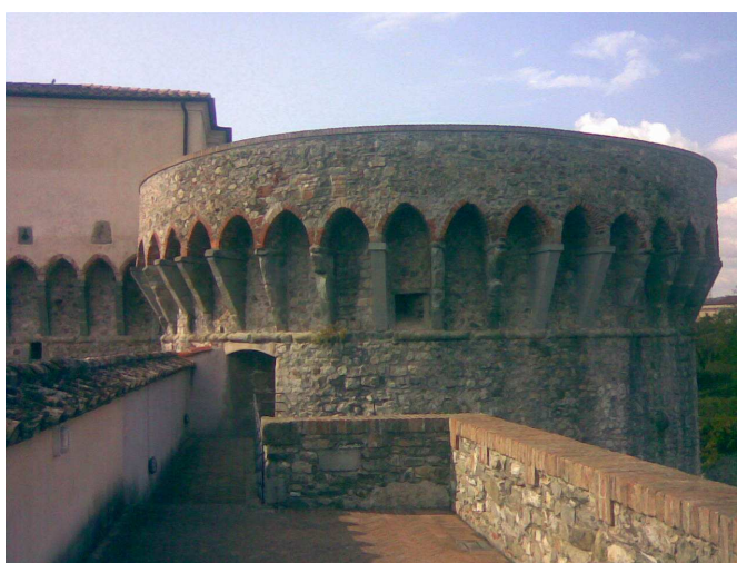
Figura 190-torre nord centrale dal camminamento nord 1° cortile-particolare. ingresso torrione
