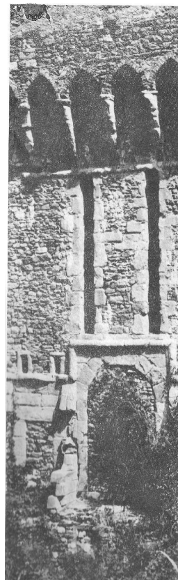
Figura 92 ingresso da ovest (murato)- al 2° cortile foto Buselli
