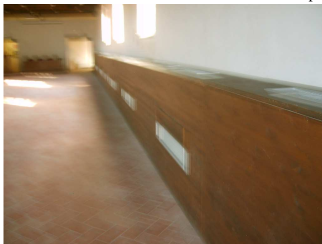
Figura 189-piano 2° del fabbricato nord del 2° cortile (particolare)
