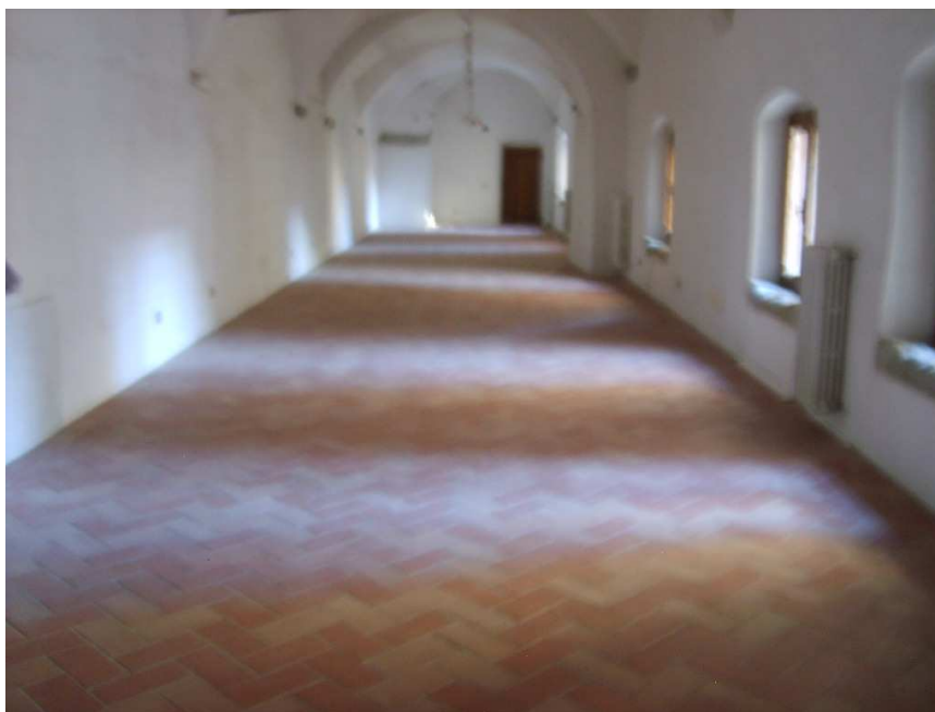
Figura 170-manica nord- salone al piano primo
