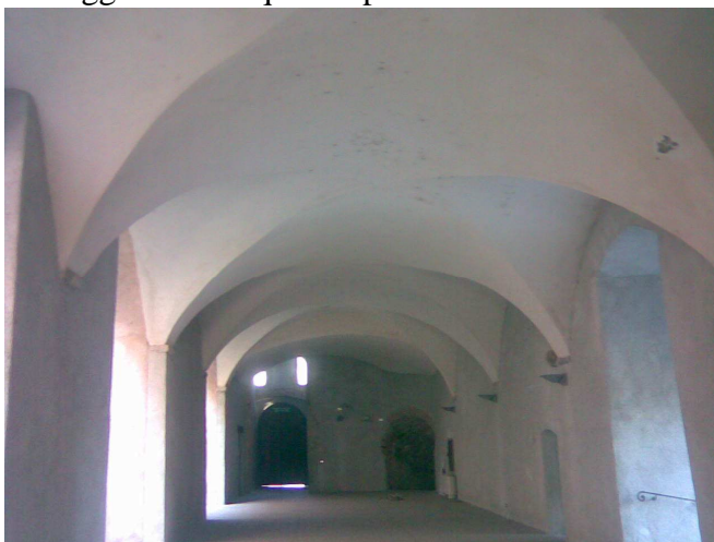
Figura 151-2° cortile-corpo nord-piano terra
