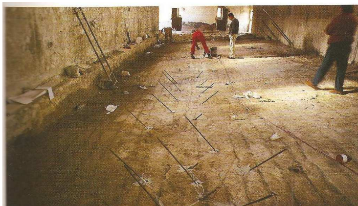
Figura 155-2° cortile-corpo nord-2° piano-consolidamento volte (foto Rossini)
