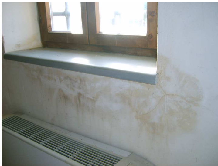
Figura 202-piano secondo del lato ovest del fabbricato ovest del 2° cortile (partic. davanzale)
