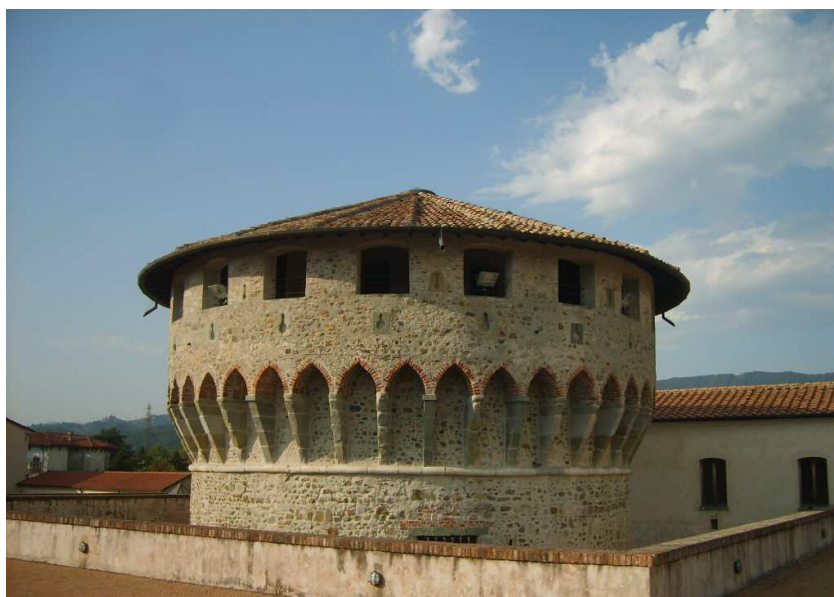
Figura 182-il coronamento e copertura del maschio dopo il restauro
