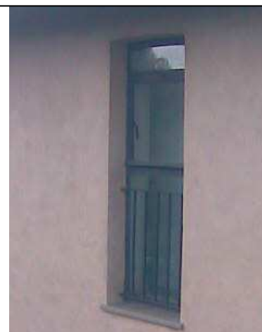
Figura 130-1° cortile-corpo est -serramento esterno
