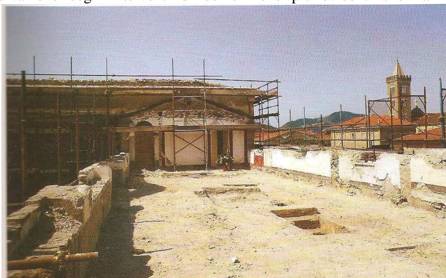
Figura 164-terzo cortile manica ovest dopo la demolizione (foto Rossini)
