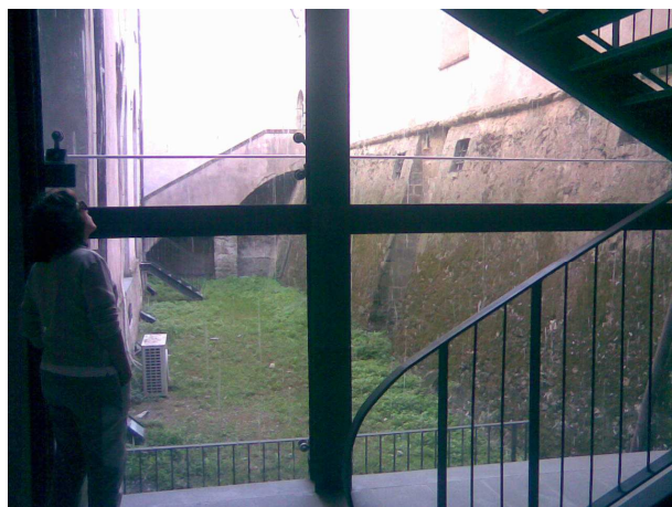
Figura 162- area 3° fossato dal vano scala
