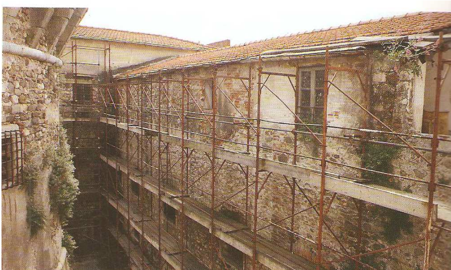
Figura 163-terzo cortile manica ovest prima della demolizione (foto Rossini)
