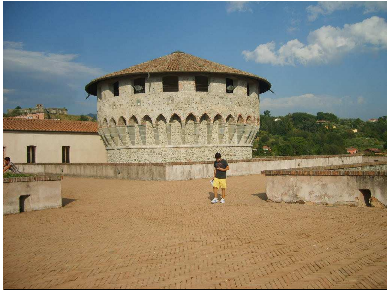
Figura 173- spalto torrione sud-ovest
