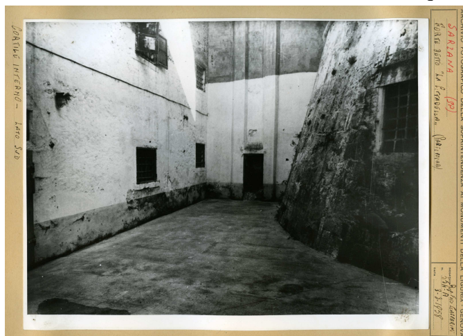
Figura 107-angolo sud/est del cortile del maschio -foto ASSBAPL
