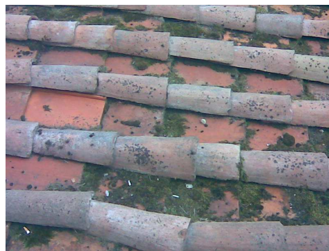
Figura 137-1° cortile-corpo nord- Particolare manto di copertura
