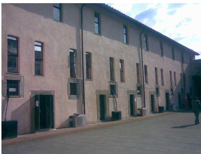
Figura 187-1° cortile corpo est lato cortile -tubi esterni di impianto di condizionamento
