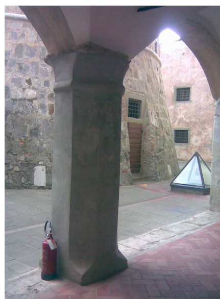
Figura 33-situazione attuale dell'ingresso al maschio
