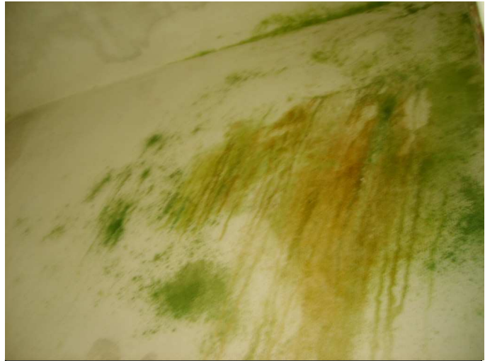
Figura 199-Piano terra corpo nord del 1° cortile-servizi igienici (particolare)
