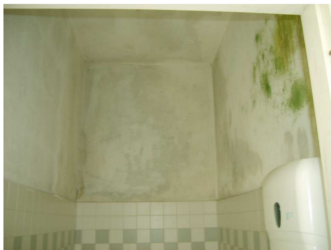
Figura 198- piano terra corpo nord del 1° cortile-servizio igienico
