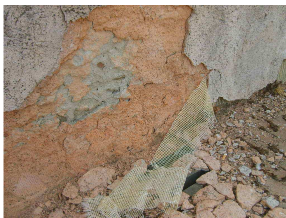
Figura 204-lato interno parapetto spalto del dado
