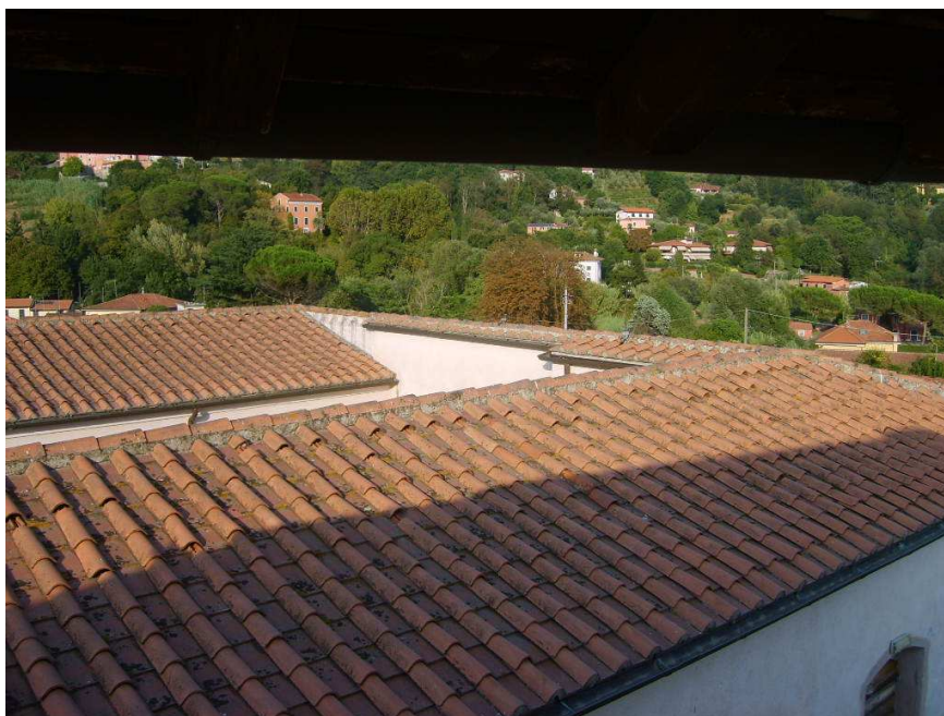
Figura 205-copertura della manica nord del dado
