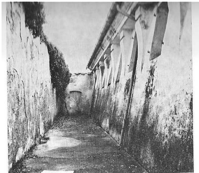
Figura 94 camminamento a nord del 2° piano del corpo nord del 2° cortile-foto Buselli
