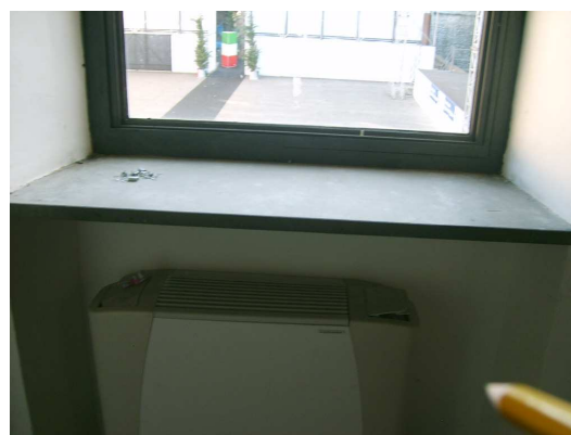
Figura 129-1° cortile-corpo nord 1° piano particolare davanzale
