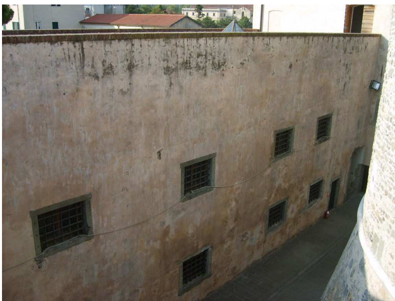
Figura 192-facciata manica ovest del dado su cortile maschio
