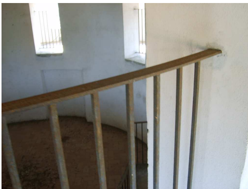
Figura 206-piano sottocopertura del maschio
