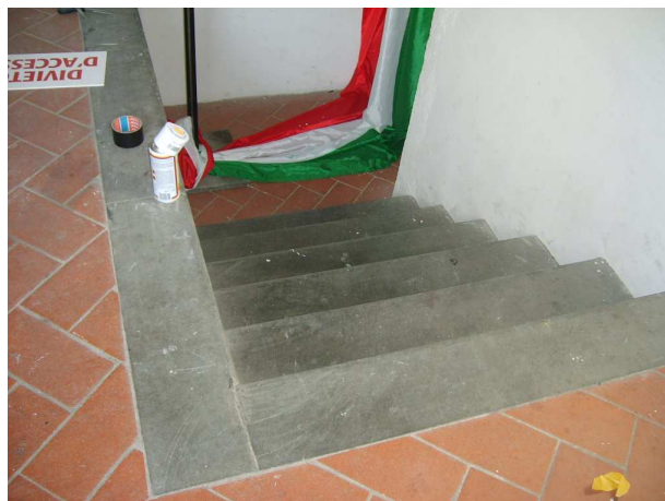
Figura 133-1° cortile-corpo nord –scala interna
