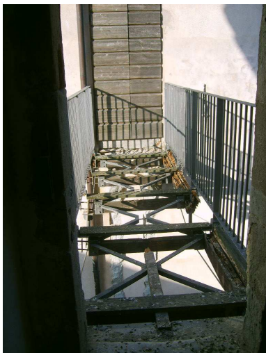
Figura 177-ponticello di collegamento maschio col dado- situazione 2011
