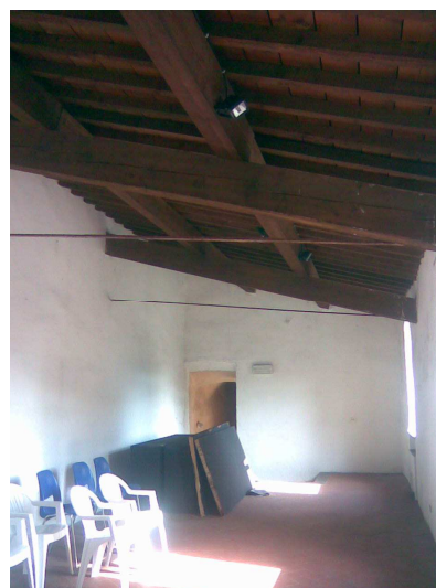
Figura 127-1° cortile-corpo nord 1° piano
