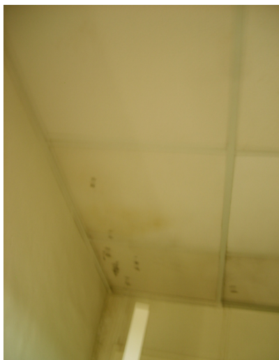
Figura 200-piano secondo della manica nord del dado-servizi igienici-(partic. controsoffitto)
