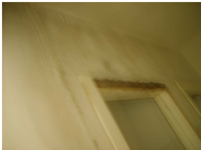
Figura 201-piano secondo della manica nord del dado-servizi igienici (partic. soprapporta)
