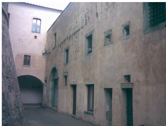
Figura 167-terzo cortile manica est
