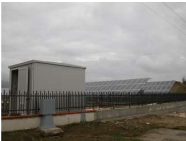
Figura 8. Gruppo di conversione (a sx) e punto di connessione BT (a dx)
