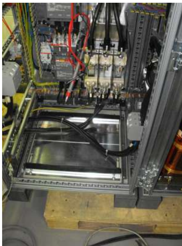
Figura 6. Particolare del punto connessione BT all'interno dell'inverter in fase di collaudo
