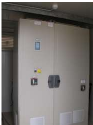
Figura 8. Gruppo di conversione (a sx) e punto di connessione BT (a dx)
