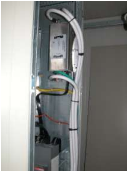
Figura 17. Una delle fasi di installazione del filtro
