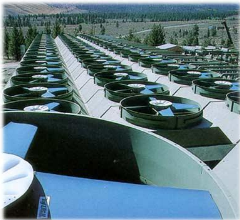
Figura 4.3: ventilatori a flusso assiale. Fonte: HUDSON products.
