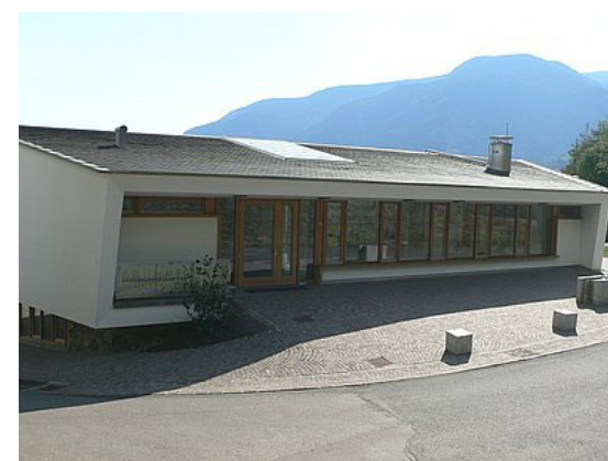
Figura 4.57: Vista prospetto est; Fonte: www.architetti.cc ;
