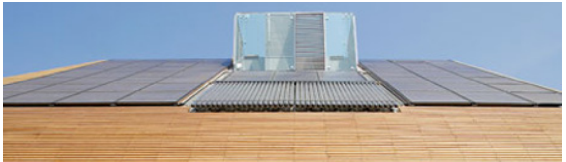
Figura 4.188: dettaglio dei sistemi solari attivi e passivi del tetto esposto a sud: il generatore fotovoltaico, il collettore solare a tubi sottovuoto e il sistema passivo a torre del vento; Fonte: M. Guzowsky, 2010;
