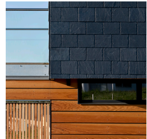
Figura 4.158: Particolare della facciata orientata a nord est; Fonte: Aart Architects, 2009;
