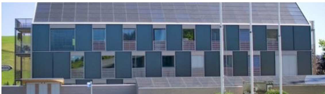
Figura 4.76: Vista del prospetto sud-ovest della residenza Kraftwerk B; Fonte: DetailGreen, 2010;
