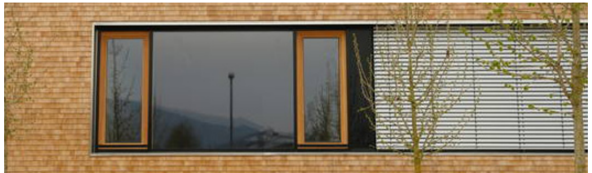
Figura 4.18: Particolare delle finestre delle aule esposte verso sud; Fonte: www.architektur-online.com ;
