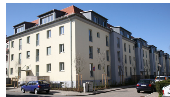
Figura 4.242: Vista esterna dell'edificio ristrutturato Blaue Heimat; Fonte: www.gerstner-architekten.de;
