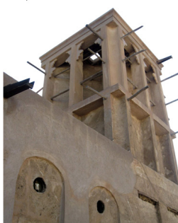
Figura 2.4: Ventilazione tramite effetto camino; Fonte: S. Capolongo, L. Daglio, I. Oberti, 2002;
