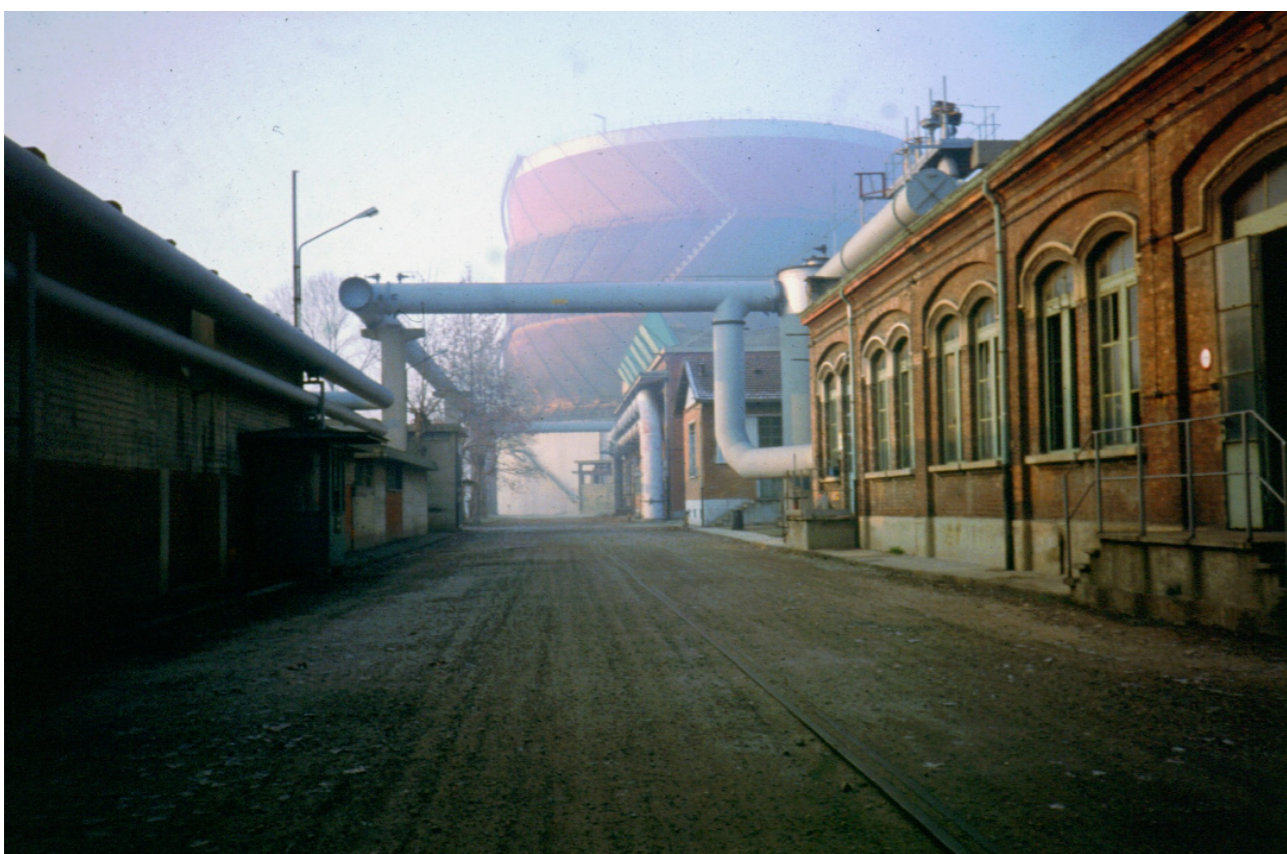
fig. 24: le Officine del Gas con il terzo gasometro e la nuova sala pressione realizzati negli anni Cinquanta
