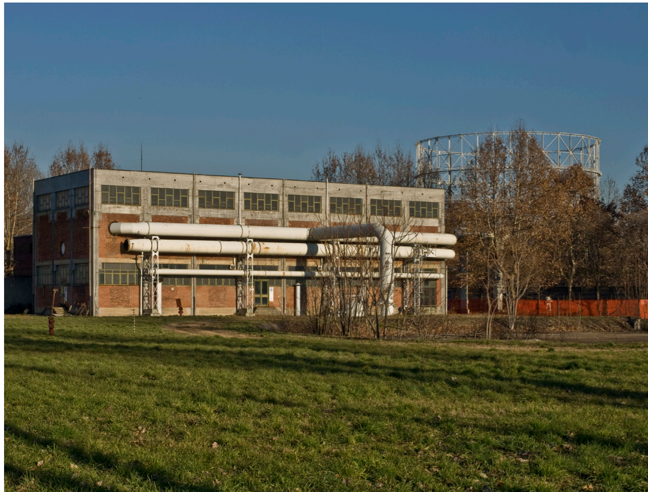
fig. 48: stato attuale della nuova sala pressione
