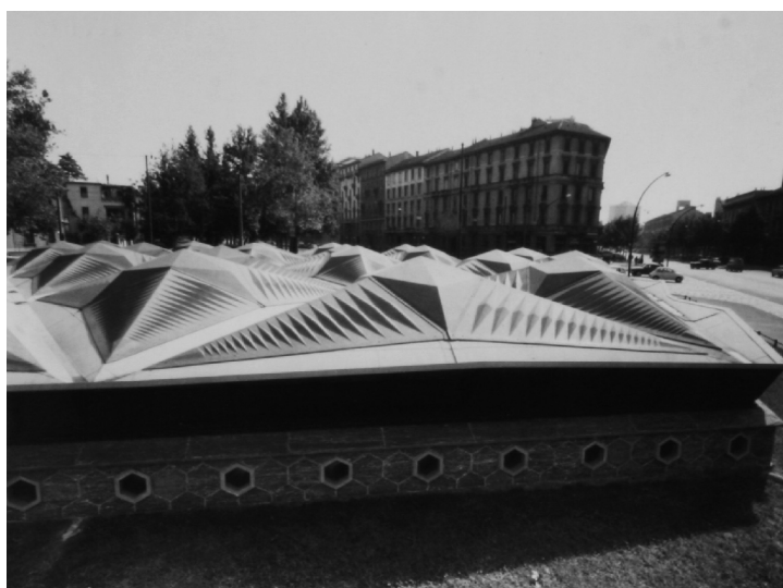
Copertura Stazione Metropolitana Amendola-Fiera (1957)
