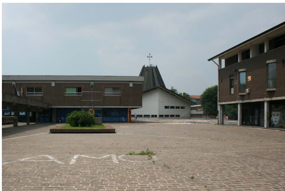
Centro Civico Chiesa Rossa, vedute del porticato di collegamento tra il Centro Civico e quello Commerciale e della piazza sopraelevata (centro religioso)
