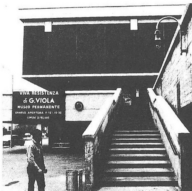
Centro Civico Chiesa Rossa, Veduta della scala di risalita alla piazza sopraelevata (1982)
