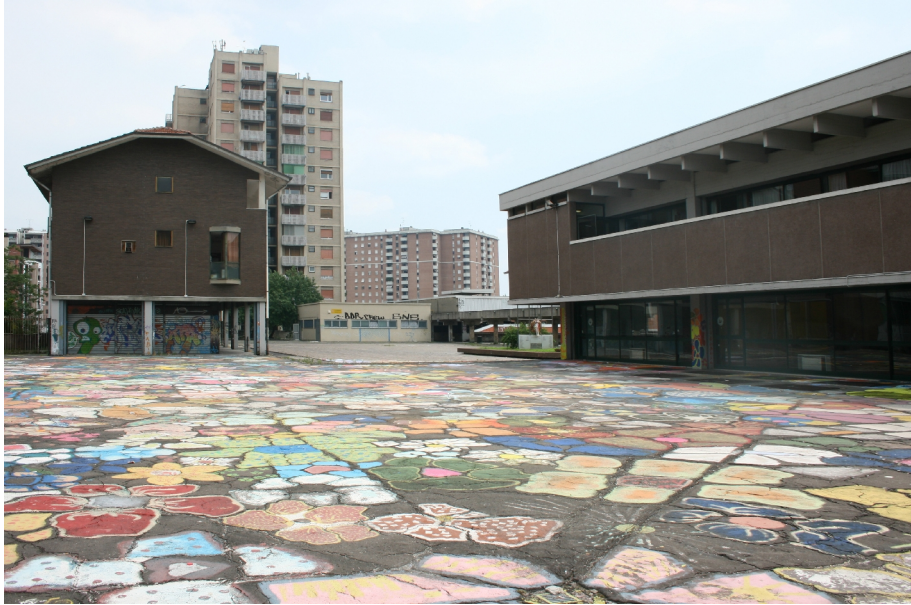
Centro Civico Chiesa Rossa, la piazza sopraelevata (Centro Civico)
