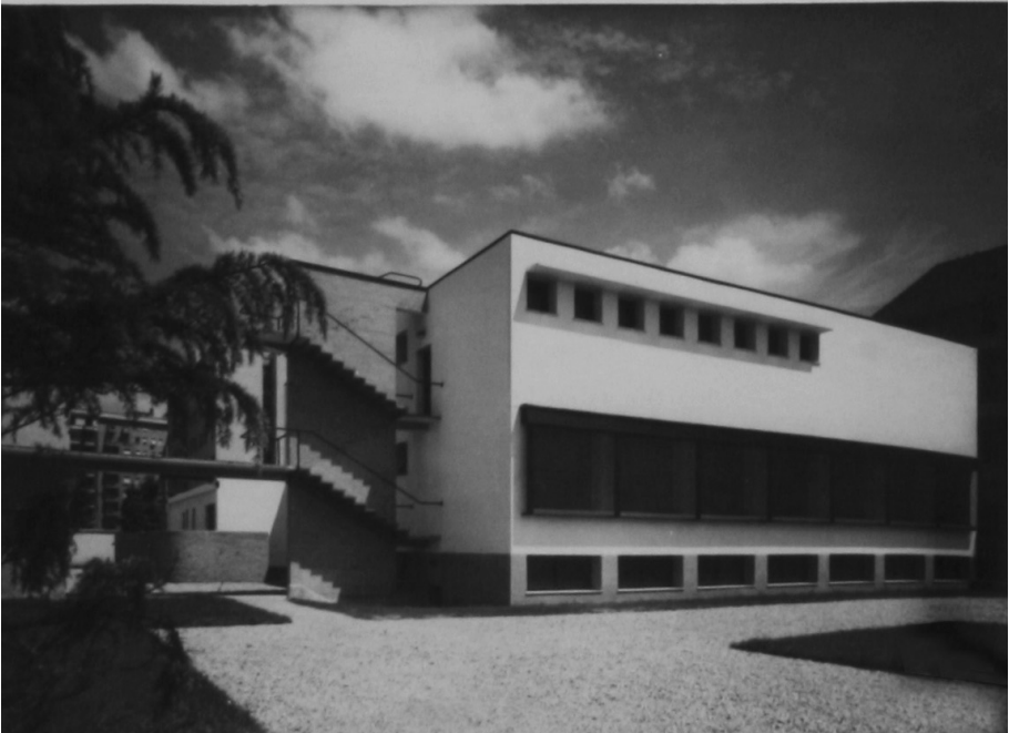
Istituto Vaccinogeno Antitubercolare, veduta del prospetto su strada e del retro, Arrigo Arrighetti (1952)
