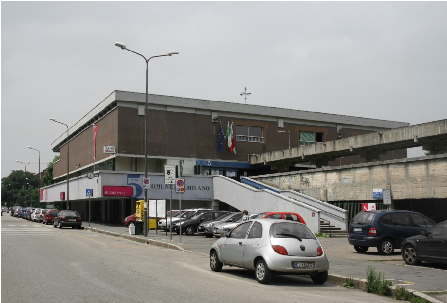
Centro Civico Chiesa Rossa, Vedute del Centro Commerciale e dell'accesso alla piazza sopraelevata
