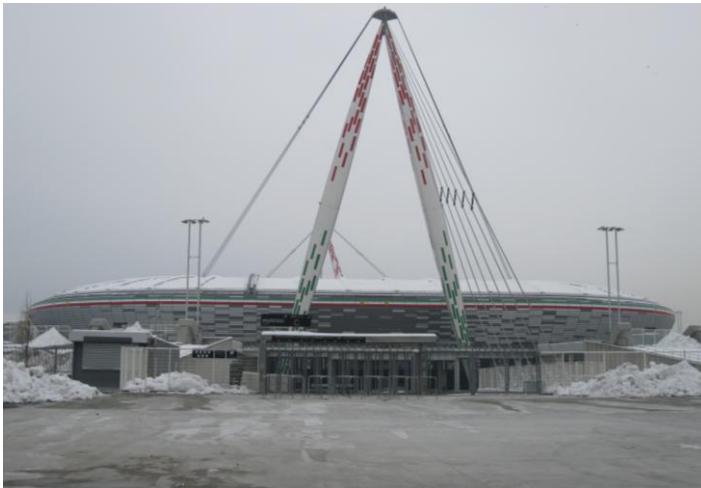
Figura 66 – Vista esterna dell'impianto
