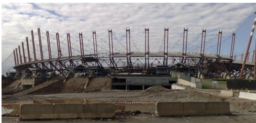
Figura 8 – Demolizione del Delle Alpi .
