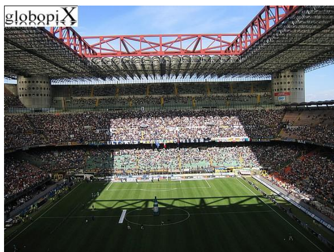
Figura 12 – Copertura e terzo anello dello Stadio San Siro a Milano
