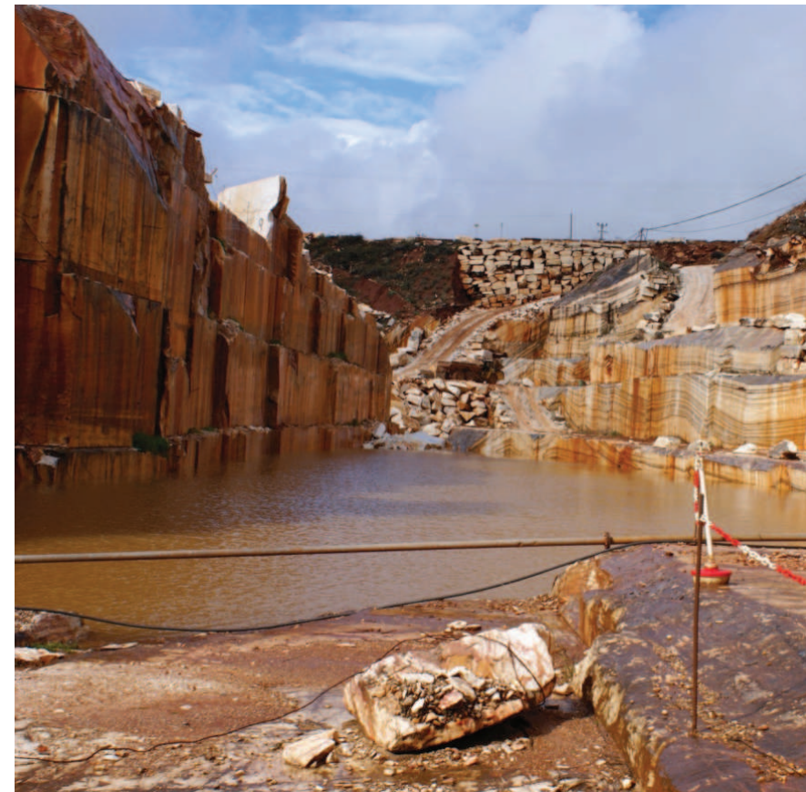
Fig. 3.13_Cava con l'interessamento della falda
