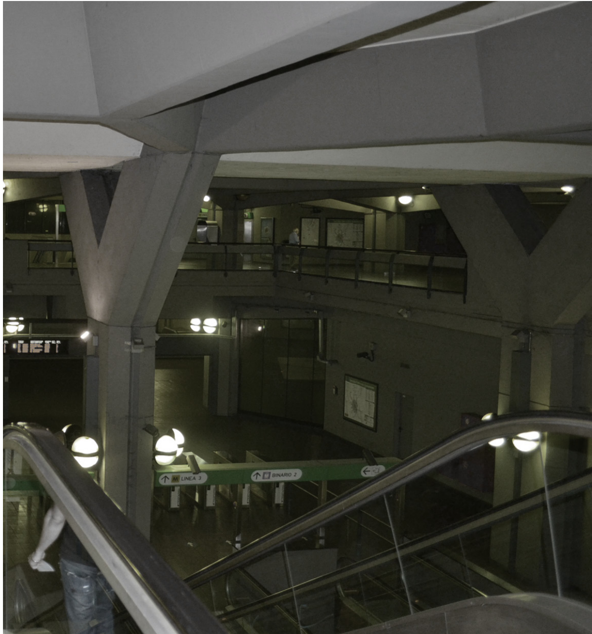
> VEDUTA INTERNA DELLA STAZIONE DI REPUBBLICA, LIVELLO -1.
