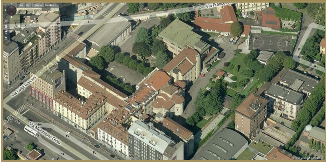
Figura 6.3 - Vista Ovest del Complesso
