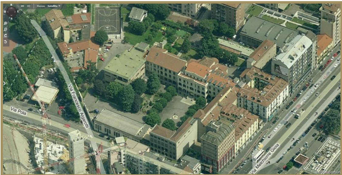
Figura 6.4 - Vista Sud del Complesso
