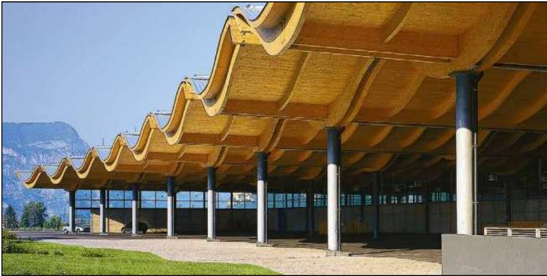
Figura 7.1 Esempio realizzazione copertura in legno lamellare
