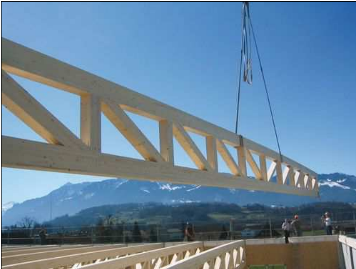
Figura 7.3 Esempio applicativo trave reticolare in legno lamellare
