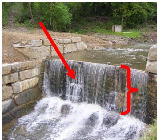
Fig. 3.24 – Parametri caratteristici di una briglia: dislivello ed inerodibilità
