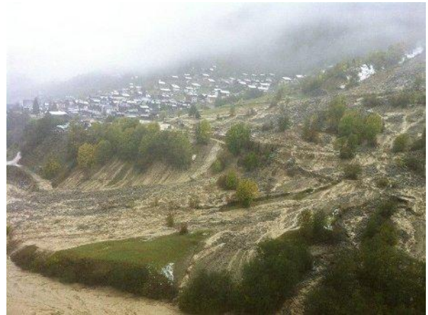
Fig. 1.5 – Esondazione del fiume Lütschine
