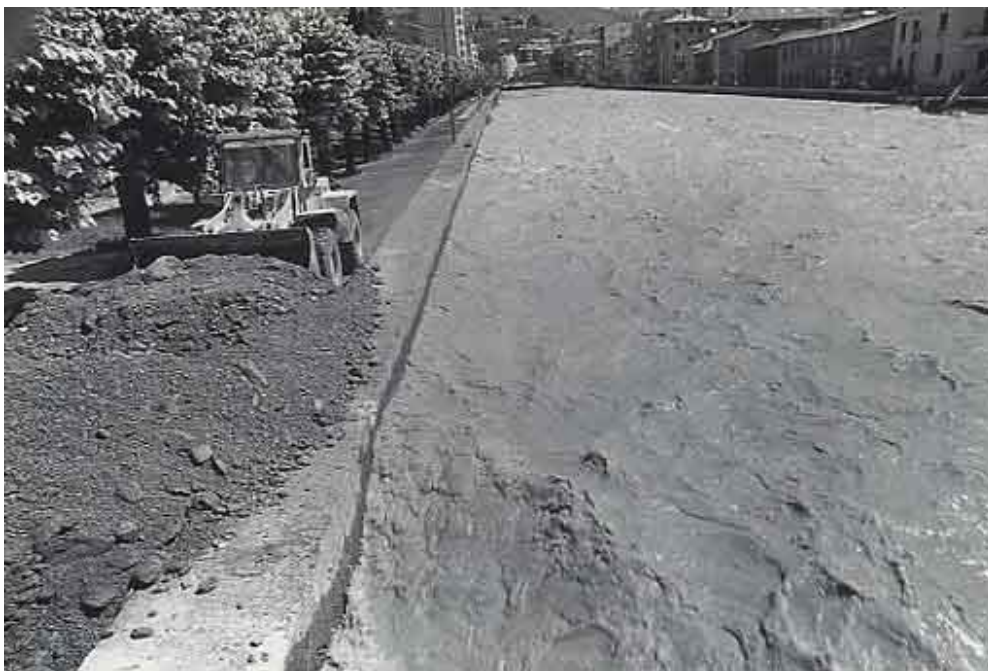
Fig. 4.9 – Livello raggiunto dalle acque del Mallero in occasione dell'alluvione dell'87
