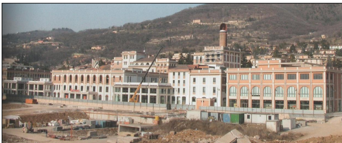
Figura 31 - Vista parziale del cantiere.
