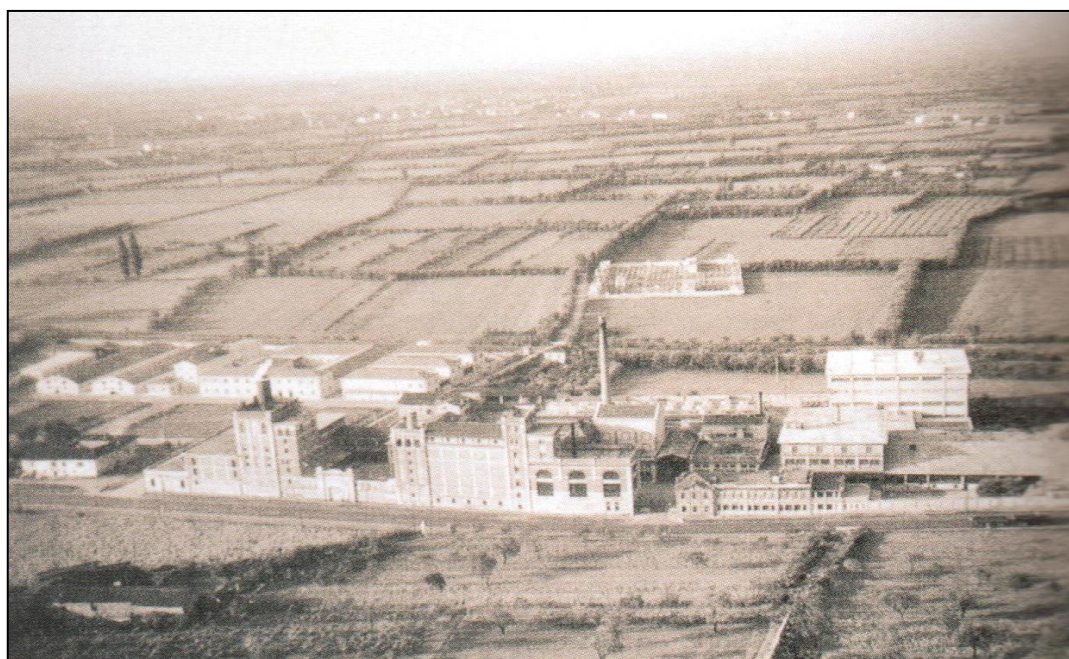
Figura 25 - Veduta dell'area dello stabilimento nel 1953.
