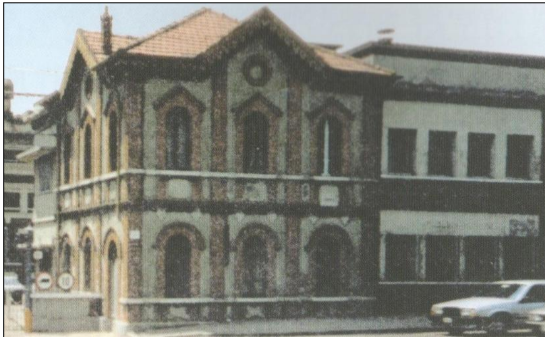
Figura 30 - Edificio 1, veduta prima dei lavori.
