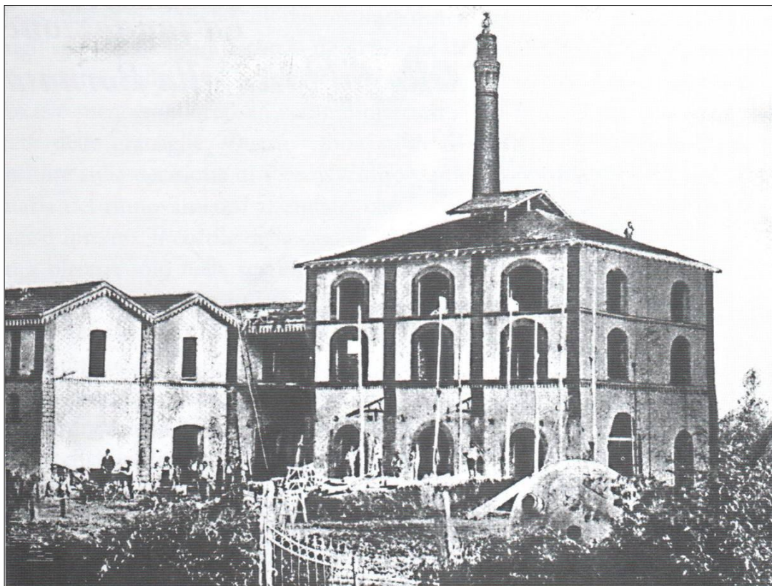
Figura 21 - Una delle più vecchie vedute fotografiche della fabbrica alla Bornatata. La sala cottura con la ciminiera sarebbe rimasta identificabile di fronte all'ingresso del futuro stabilimento, così come i piccoli edifici sulla sinistra.
