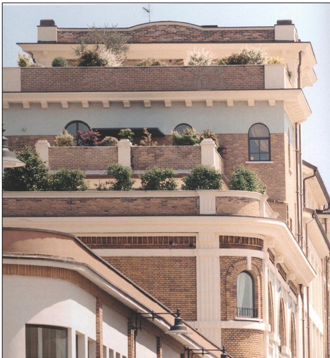
Figura 33 - Vista degli edifici recuperati.
