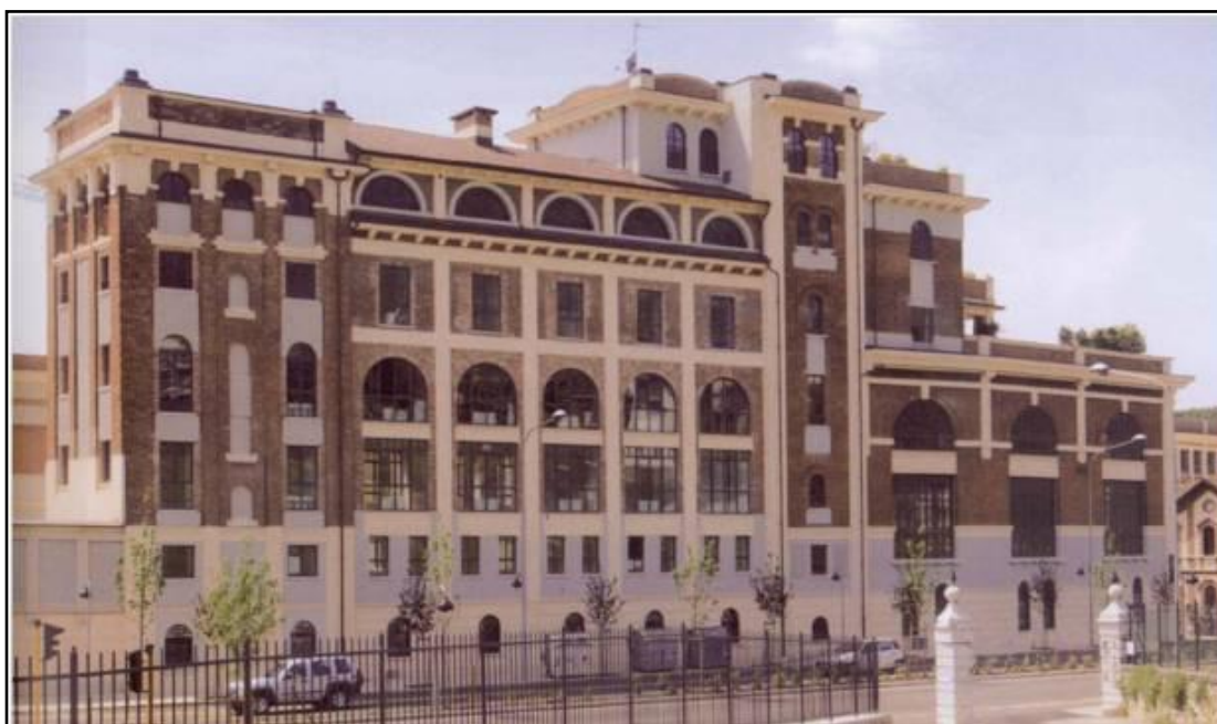
Figura 32 - Veduta dell'edificio 2-3 dopo la ristrutturazione del lato della Bornata
