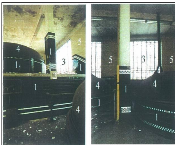
Figura 38 - Interno della sala cotte.
