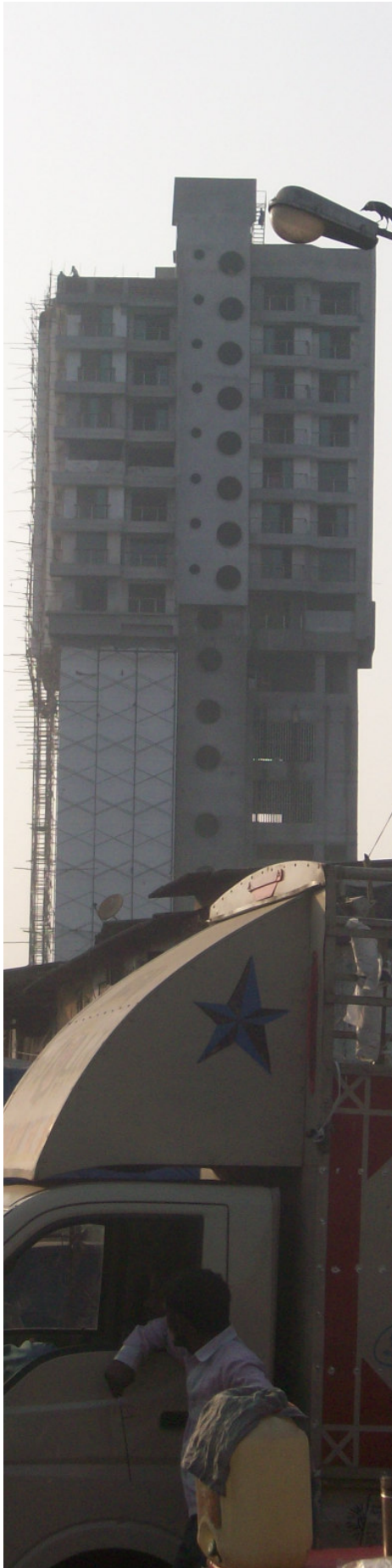
figura 93. Edificio multipiano presso Mahim. Foto: Francesco Galli.
