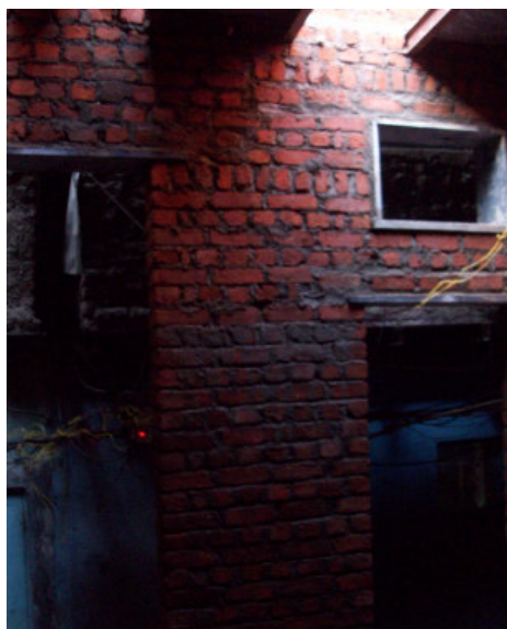
figura 156. Interno nuova costruzione durante i lavori. Fonte: Francesco Galli
