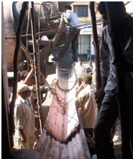
figura 36. Soluzioni alternative per il trasporto del cemento. Foto: Francesco Galli
