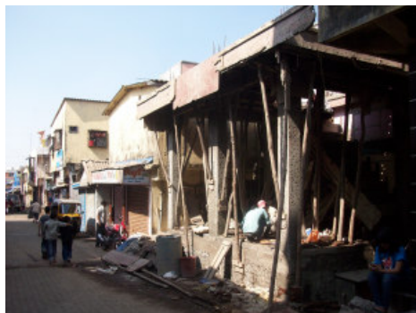
figura 149. (sotto) Edificio durante la costruzione. Foto: Francesco Galli
