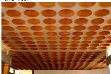
figura 181. Esempio di solaio filler-slab . Fonte: web.
