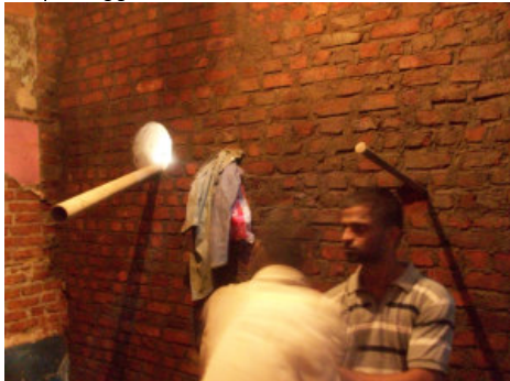
figura 171. Fori interni per il sostegno del ponteggio. Fonte: Francesco Galli
