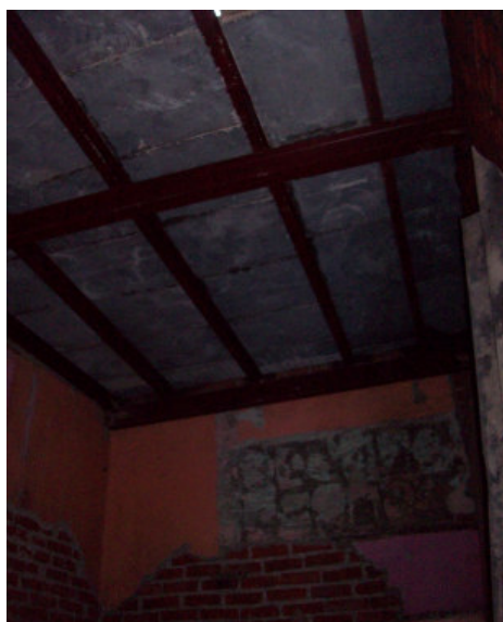
figura 157. Vista solaio interpiano nuova costruzione. Fonte: Francesco Galli
