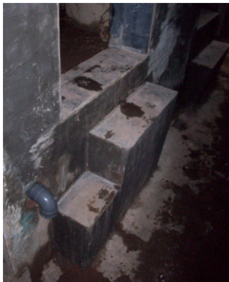
figura 155. Fondazione esterna di 60cm (zoccolo). Fonte: Francesco Galli
