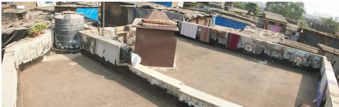
figura 173. (sopra) Panoramica della copertura piana. Fonte: Francesco Galli
