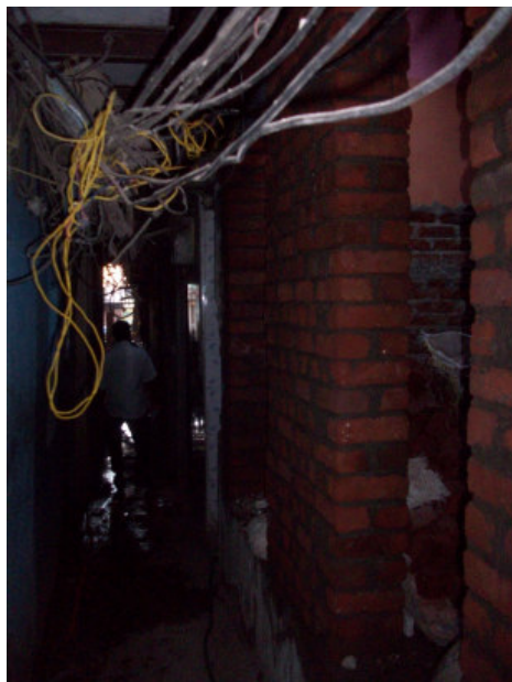
figura 153. Esterno nuova costruzione durante i lavori. Fonte: Francesco Galli
