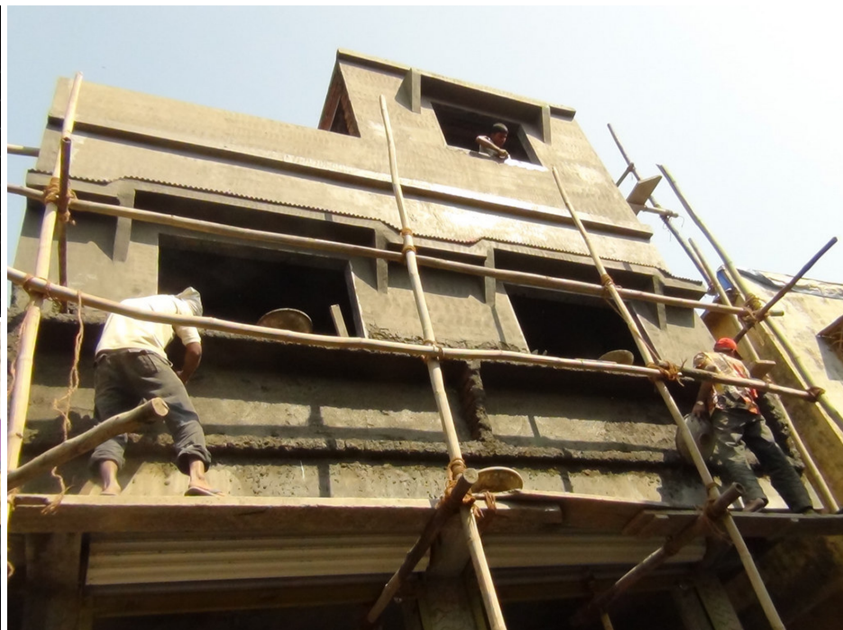
figura 148. Facciata durante la costruzione. Fonte: www.flickr.com/urbzoo
