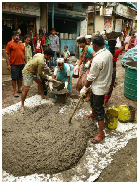
figura 31. Consegna cemento per la costruzione del tempio. Fonte: www.flickr.com/urbzoo .
