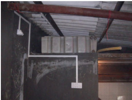
figura 166. (alto) Spazio destinato al serbatoio al piano primo. Fonte: Francesco Galli
