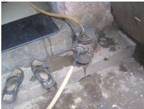
figura 81. Foto rubinetto collegato con il serbatoio soprastante. Foto: Francesco Galli
