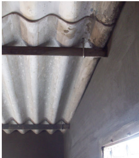
figura 158. Fissaggio della copertura in eternit. Fonte: Francesco Galli
