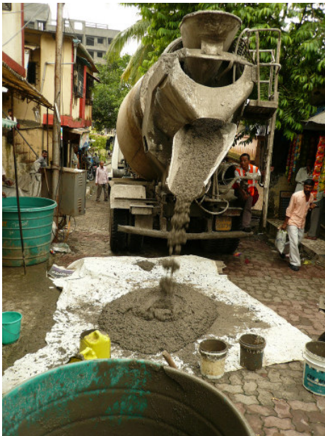
figura 30. Consegna cemento per la costruzione del tempio. Fonte: www.flickr.com/urbzoo .
