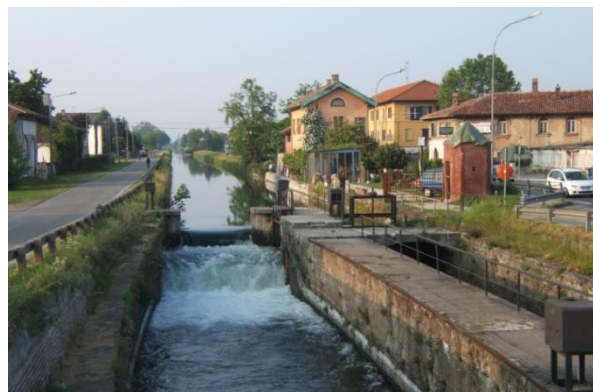
Figura 27_ Conca sul Naviglio Pavese - Rozzano
