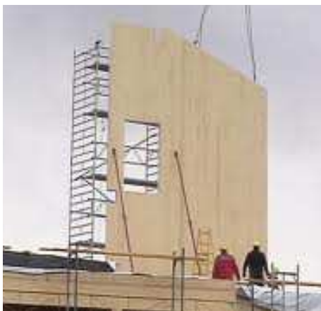
Figura 1.57 Montaggio pannelli X-Lam
