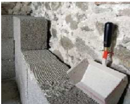
Figura 1.27 Controparete in blocchi prefabbricati
