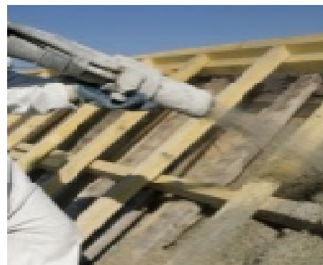
:9 Isolamento tetto a spruzzo
