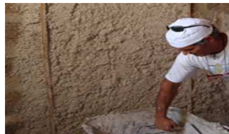
Figura 1.21 Intonaci di corpo
