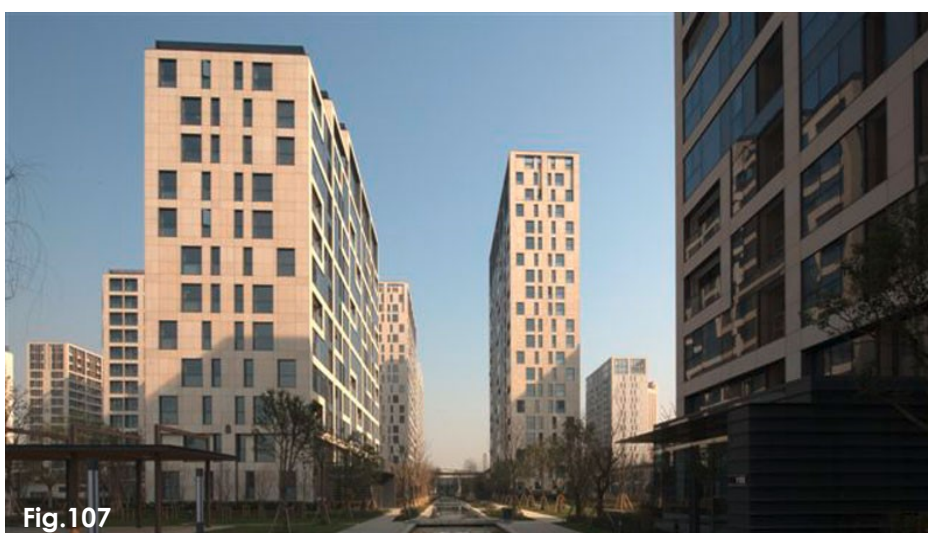
Fig.107 Viste interne del villaggio Expo
