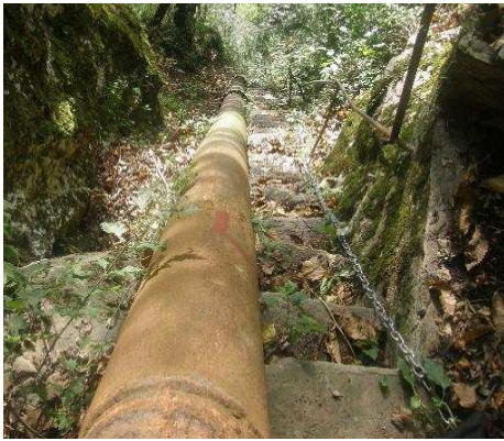
Figura 4.5 La condotta forzata
