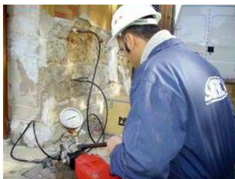
Figura 7.1 Prove di compressione semidistruttive con martinetti piatti
