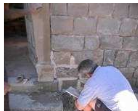
Figura 6.4 Stilatura dei giunti di malta e stuccatura
