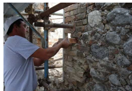
Figura 6.3 tecnica cucì e scuci
