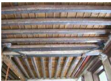
Figura 6.13 Placcaggio con piatti metallici
