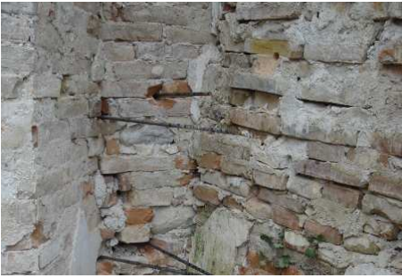
Figura 6.5 Iniezioni armate
