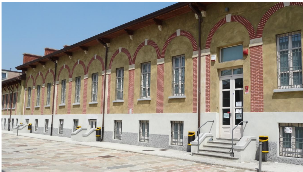
Fig. 18: Edificio B – Vista sud
