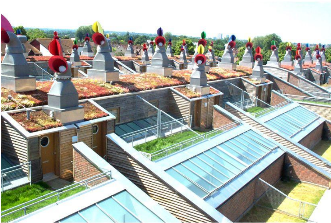
Fig. 103: Vista dei tetti del complesso con le caratteristiche torri del vento
