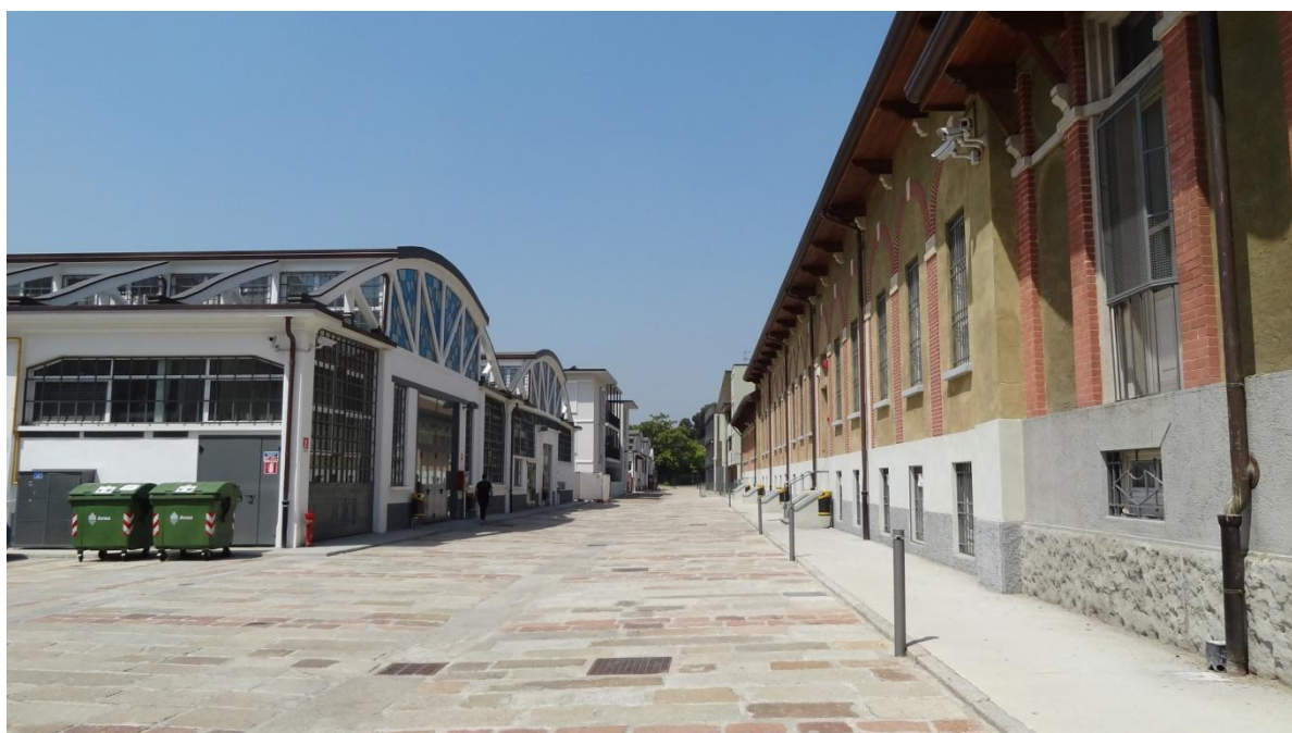
Fig. 19: Ingresso al complesso
