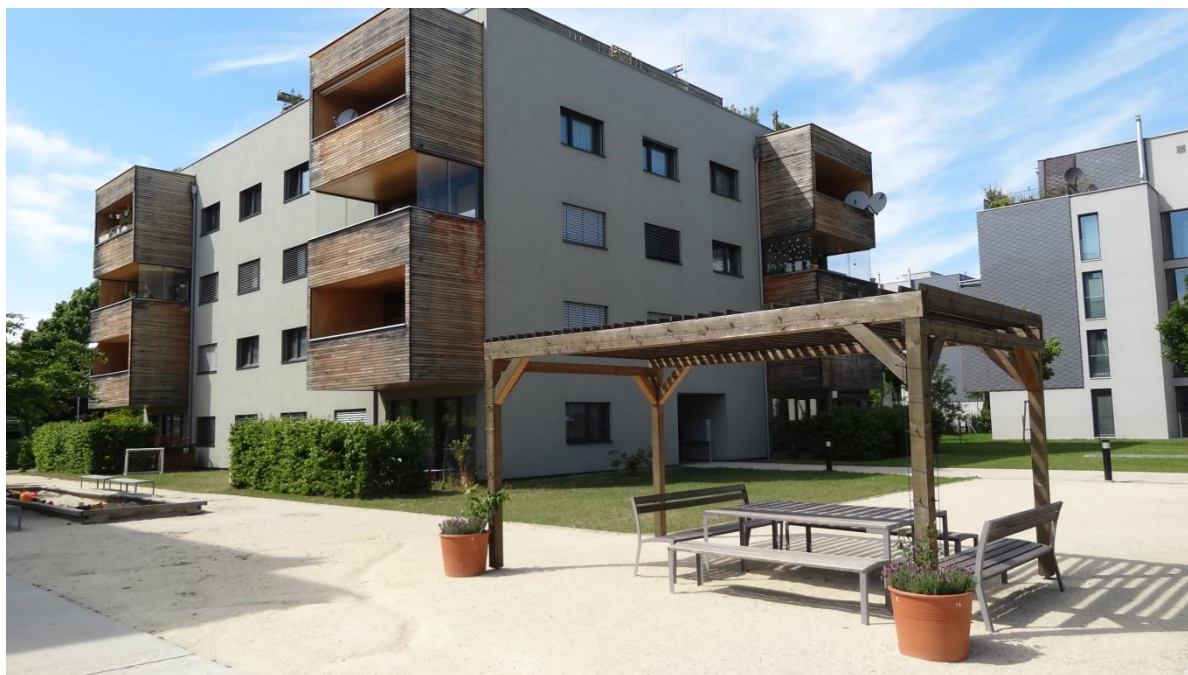
Fig. 80: Spazio esterno comune con pergolato
