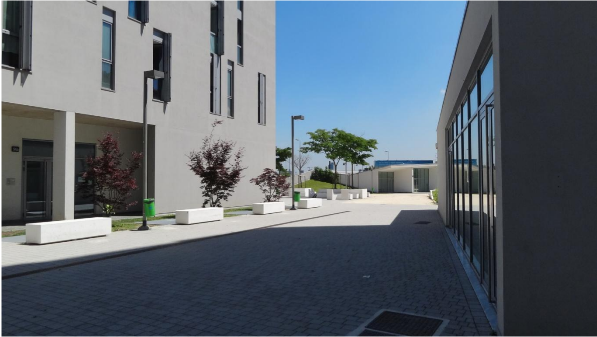
Fig. 6: Vista ovest su piazzetta interna
