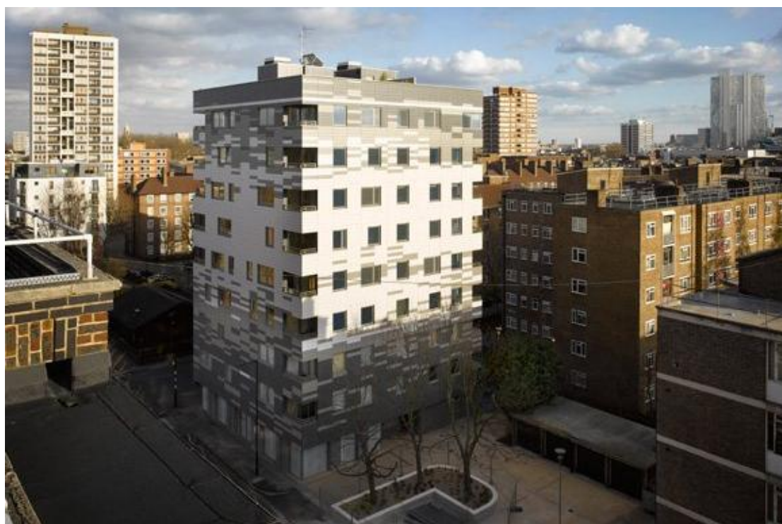
Fig. 106: Vista nord-ovest dell'edificio
