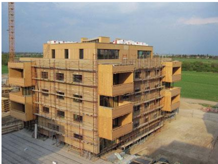
Fig. 83: Cantiere – Strutture in elevazione
