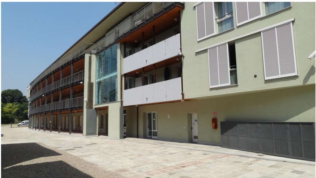
Fig. 21: Edificio A – Vista sud Fotografia di Chiara Tagliaro
