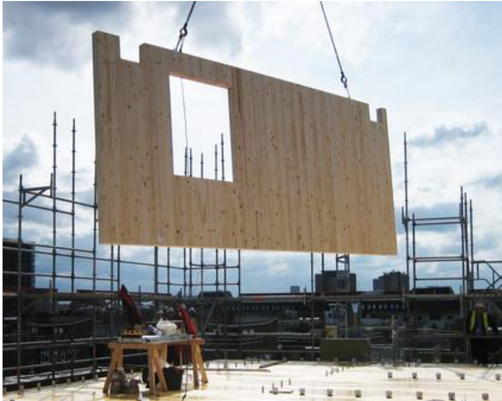
Fig. 114: Cantiere – Posa di un pannello X-lam
