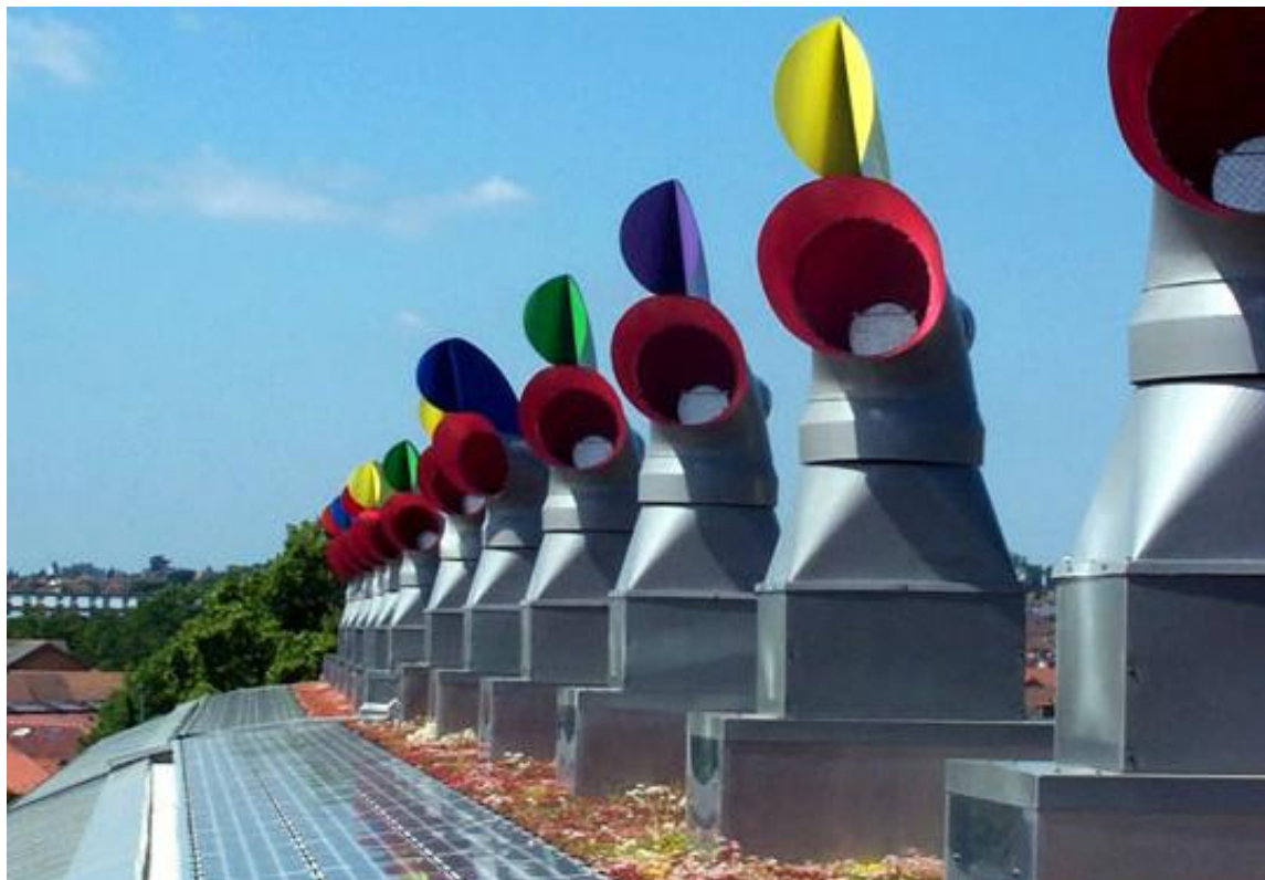
Fig. 101: Particolare della copertura
