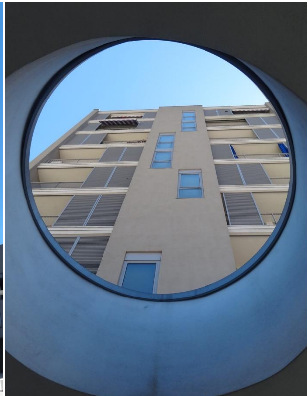
Fig. 10: Vista da passaggio coperto Fotografie di Chiara Tagliaro
