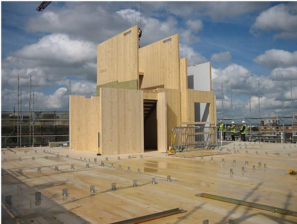
Fig. 115: Cantiere – Fase di assemblaggio della struttura
