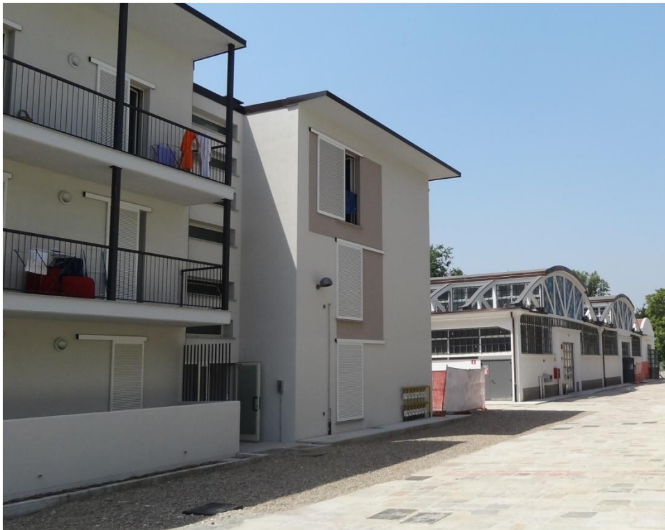
Fig. 20: Edifici C e D – Vista nord Fotografia di Chiara Tagliaro
