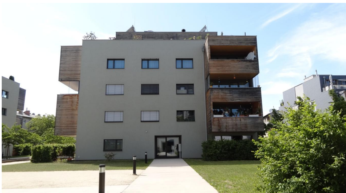
Fig. 81: Edificio D – Vista est
