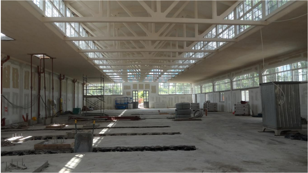
Fig. 16: Edificio C – Lavori di ristrutturazione Fotografia di Chiara Tagliaro
