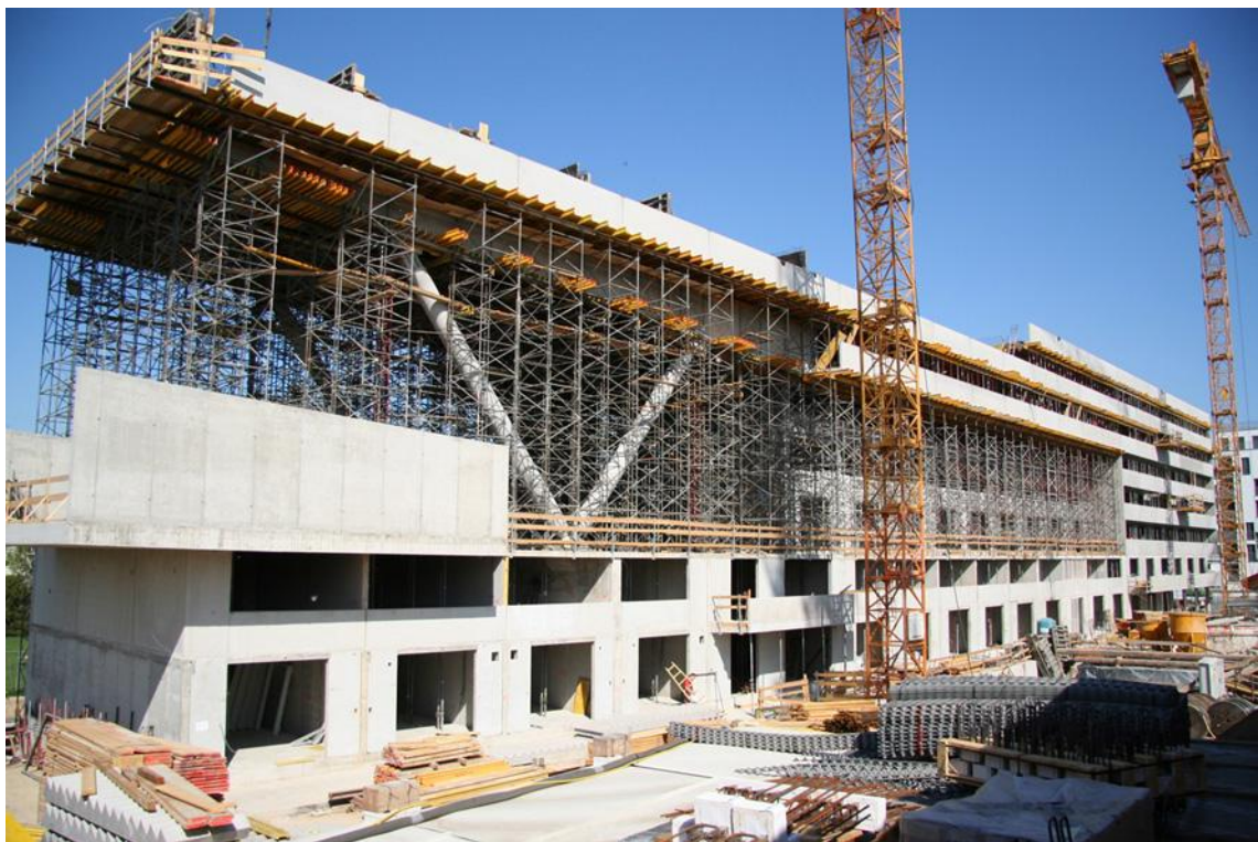
Fig. 71: Cantiere – Strutture in elevazione
