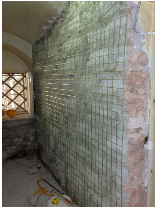
FIGURA 45 - RINFORZO MURATURA CON RETE GFRP
