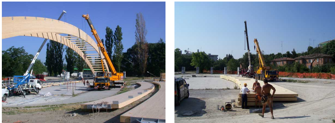
FIGURA 93 - MOVIMENTAZIONE E POSIZIONAMENTO TRAVI IN LEGNO
