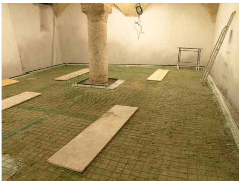
FIGURA 44 - RINFORZO SOLAIO CON RETE FRP
