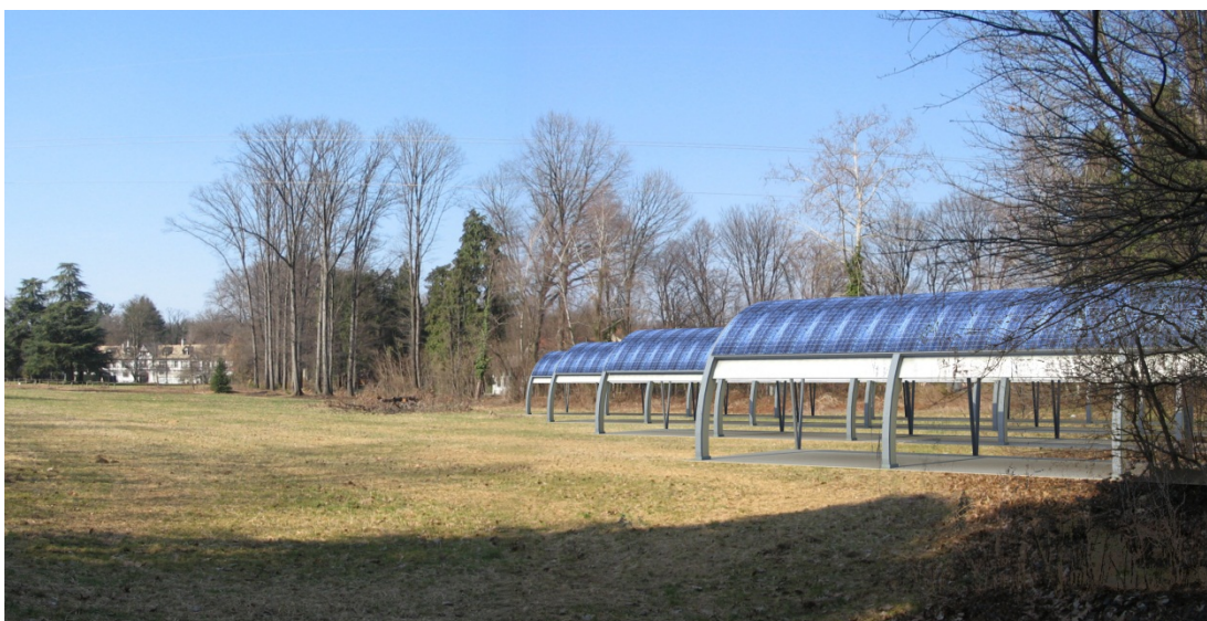
FIGURA 104 - IL PARCO FOTOVOLTAICO
