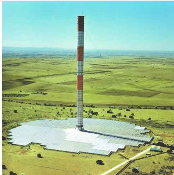
Figura 1.3. Impianto ad effetto camino di Manzanares
