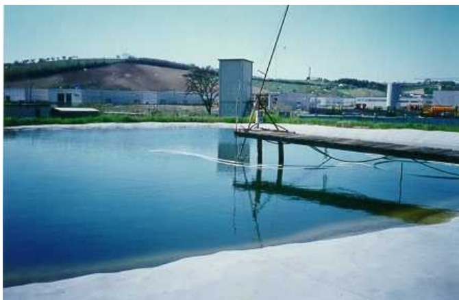
Figura 1.4. Impianto sperimentale Solar Pond ad Ancona
