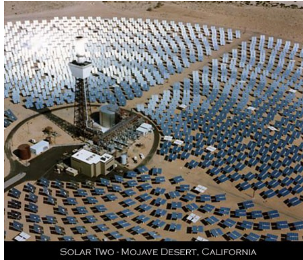
Figura 1.8. Impianto con torre solare
