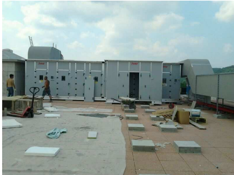
Figura 3.13: Collegamento UTA 45000 mc/h.
