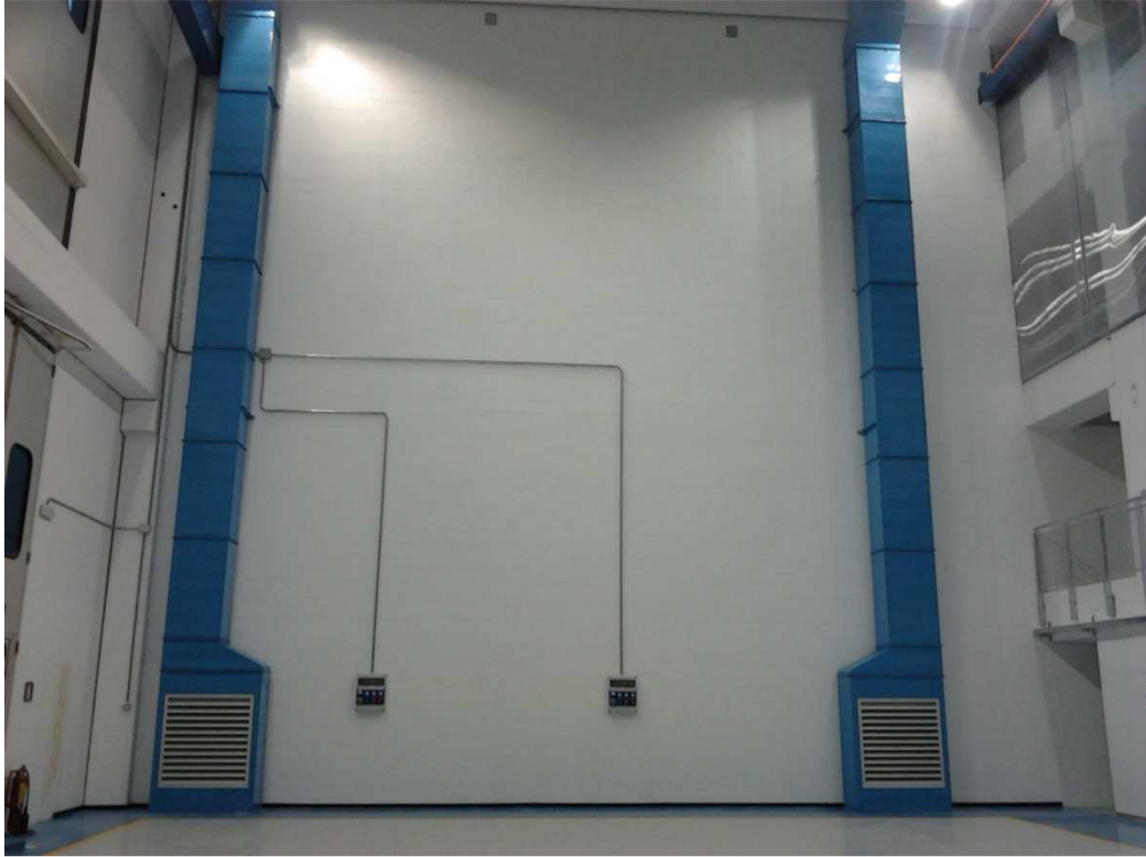
Figura 3.11: Installazione calate canali ripresa.
