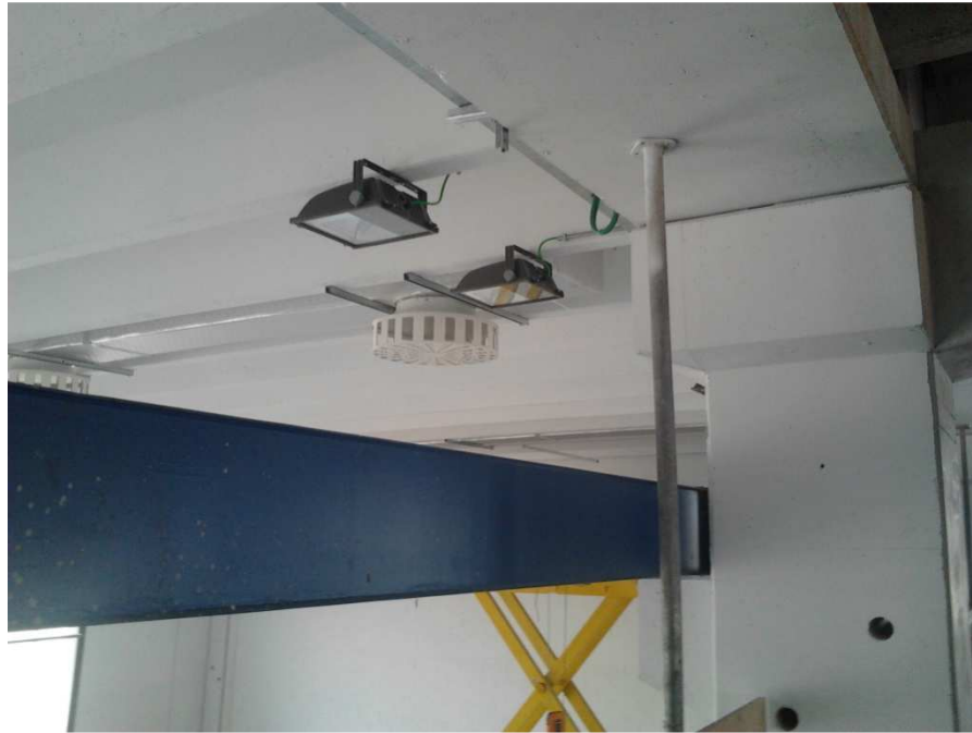
Figura 3.9: Installazione diffusori zona simulatori FFS.
