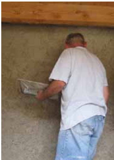
Fig. 3.120 Posa dell'arriccio
