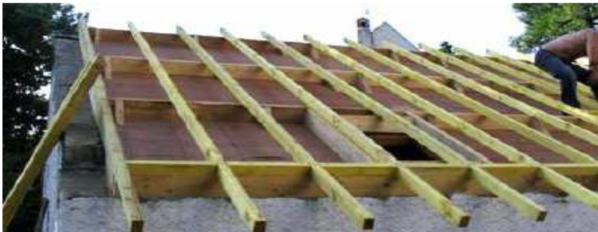
Fig. 3.84 Realizzazione della struttura a cassettoni da Zaccanti O., (2001) Presentazione Usiamo le Energie
