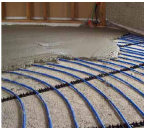
Fig. 3.40 Copertura dell'impianto a pavimento con massetto in calce e sabbia
