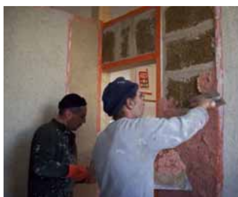
Fig. 3.137 Applicazione dell'intonaco di finitura colorato con diversi pigmenti naturali
