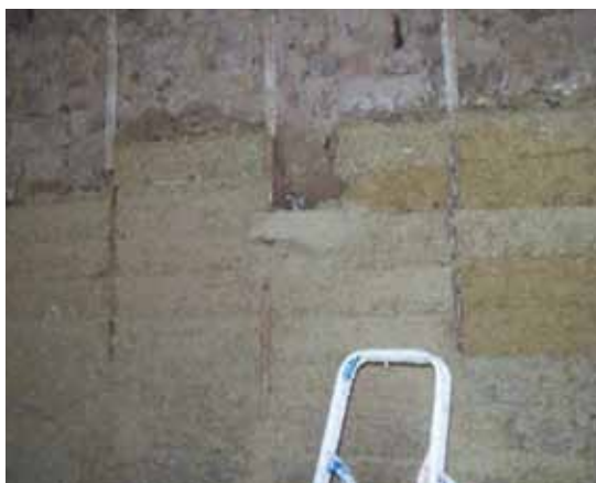
Fig. 3.127 Intonaco isolante una volta scasserato
