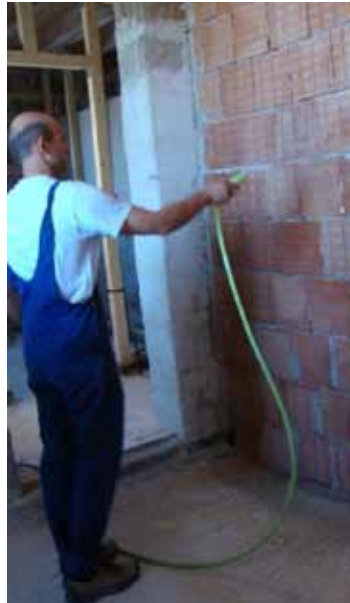
Fig. 3.118 Bagnatura della parete
