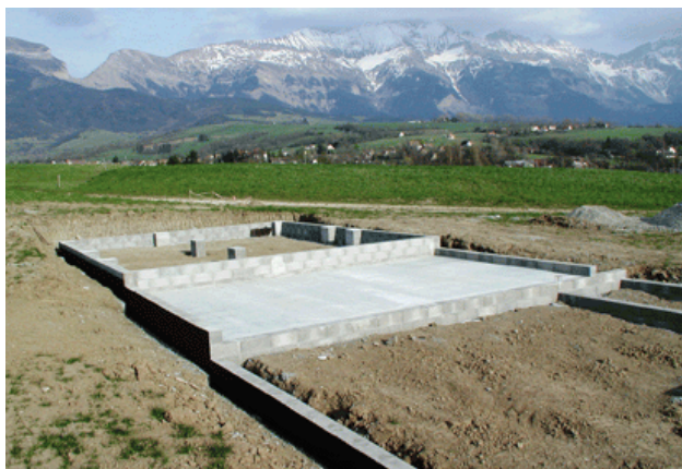
Fig. 3.197 Realizzazione del basamento
