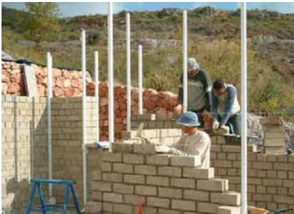
Fig. 3.208 Messa in opera dei blocchi
