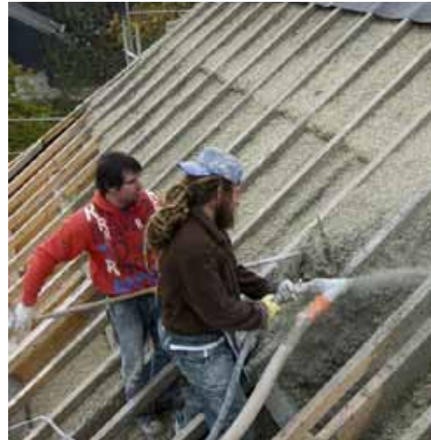
Fig. 3.165-3.166 Struttura della copertura per spruzzo del calcecanapulo , www.batiethic.fr
