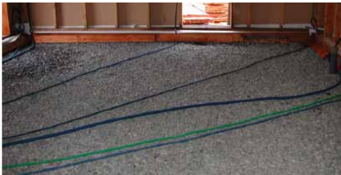
Fig. 3.35-3.36 Impianti sul solaio controterra in massciata in ghiaia (tipico vespaio areato francese)
