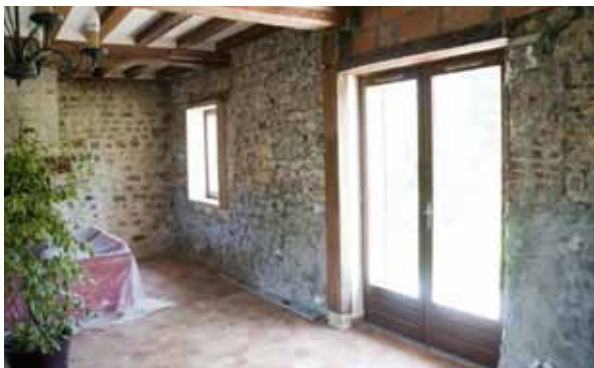
Fig. 3.151-3.152 Controparete interna (10 cm) a spruzzo con rasatura in calcecanapulo su muro in pietra da www.batiethic.fr
