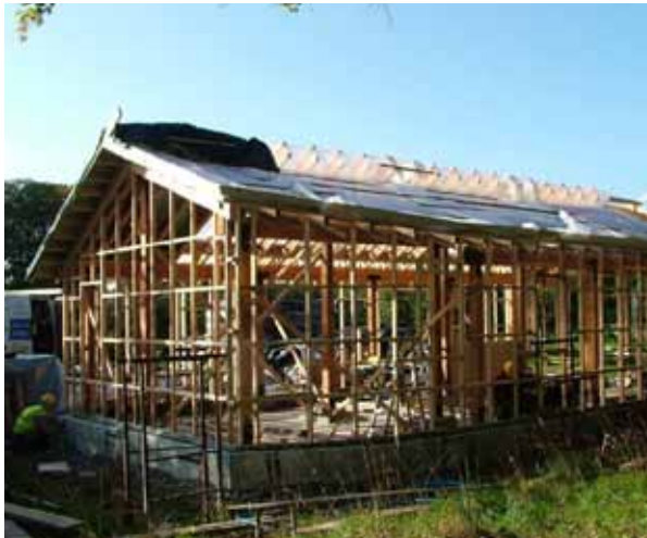
Fig. 3.3 Ossatura portante in legno, con orditura secondaria di montanti
