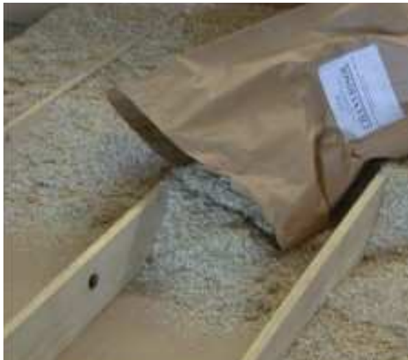
Fig. 1.27 Riempimento del solaio con canapulo ChanvriSol
