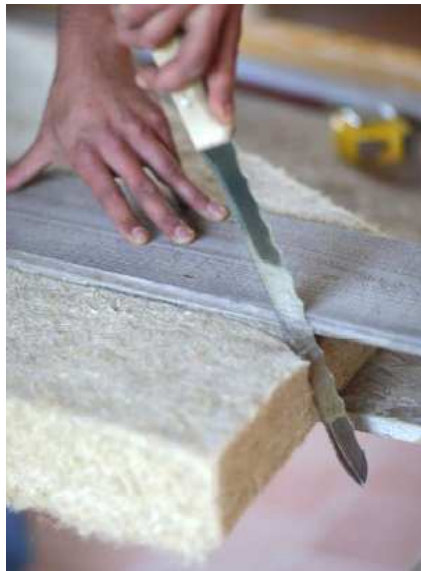
Fig. 1.17 Taglio matterassini Technichvre Hempwool
