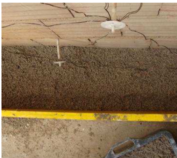
Fig. 3.109 Controparete interna, S.Sabbadini, (2012), Presentazione cantiere scuola Casatenovo
