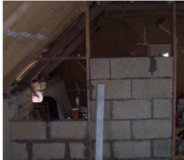
Fig. 3.16 Parete interna in blocchi, blocchi allineati alla struttura
