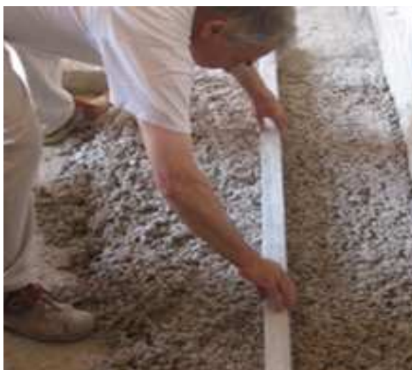
Fig. 3.90 Massetto calpestabile in calcecanapulo, ANAB, (2011), Presentazione Cantiere Scuola: isolanti naturali, S.Matteo della Decima
