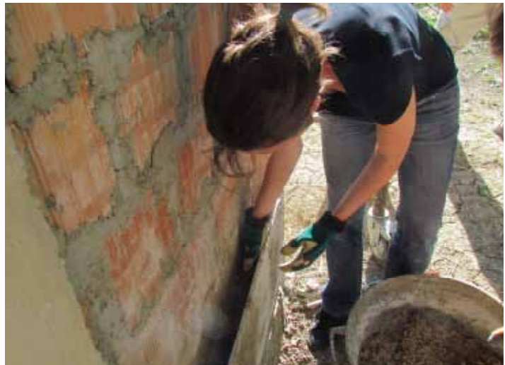
Fig. 3.113 Getto manuale della controparete, Seminario a Granara, 2012
