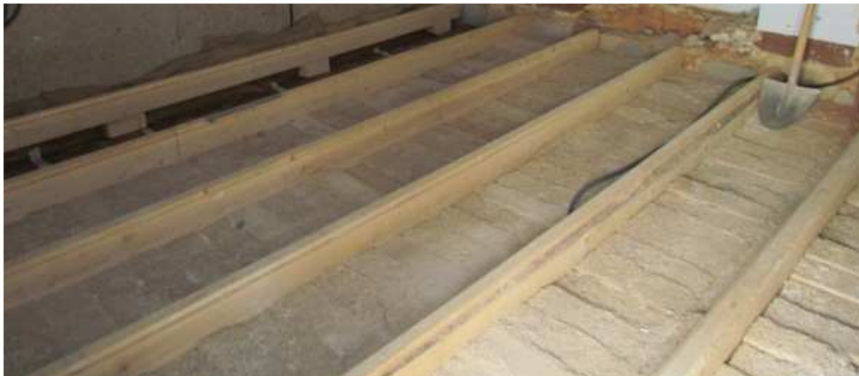
Fig. 3.206 Sperimentazioni di riempimenti di soali in blocchi, Cantiere di Cascina Corte Sacro Cuore, Casatenovo (LC), Arch. S. Sabbadini
