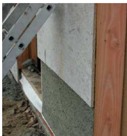
Fig. 3.107 Rimozione dei casseri
