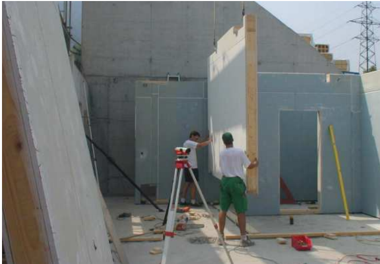
Fig. 4.5 Montaggio dei pannelli di un sistema a telaio in cantiere
