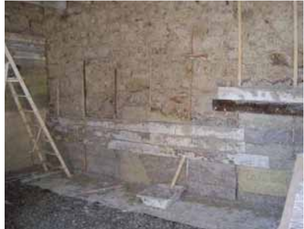
Fig. 3.124 Posizionamento di listelli e casseri
