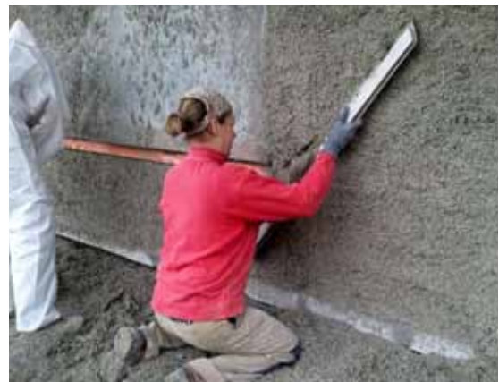
Fig. 3.151-3.152 Controparete interna (10 cm) a spruzzo con rasatura in calcecanapulo su muro in pietra da www.batiethic.fr
