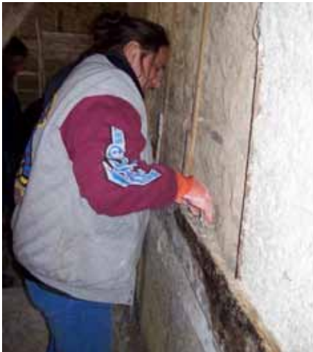
Fig. 3.125 Applicazione del getto nei casseri
