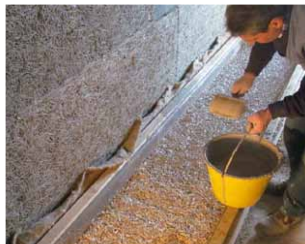
Fig. 3.79 Applicazione della boiaccia di calce
