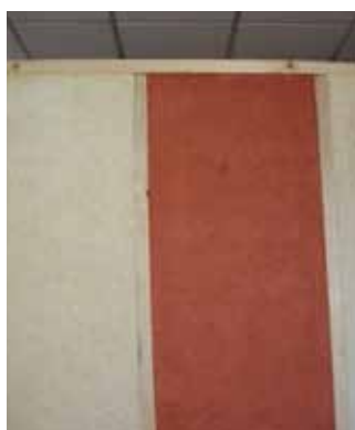
Fig. 3.137 Applicazione dell'intonaco di finitura colorato con diversi pigmenti naturali
