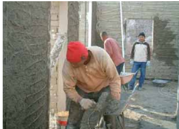
Fig. 3.209 Posa dei pannelli radianti a parete e fissaggio con apposita malta di calce
