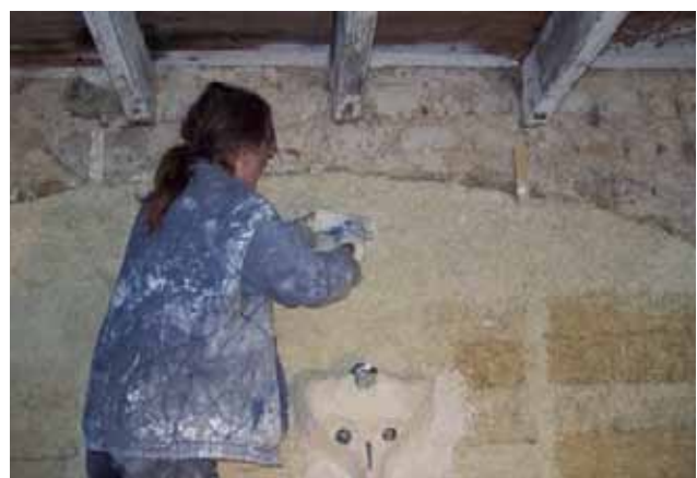
Fig. 3.128 Completamento a mano della fascia superiore della parete
