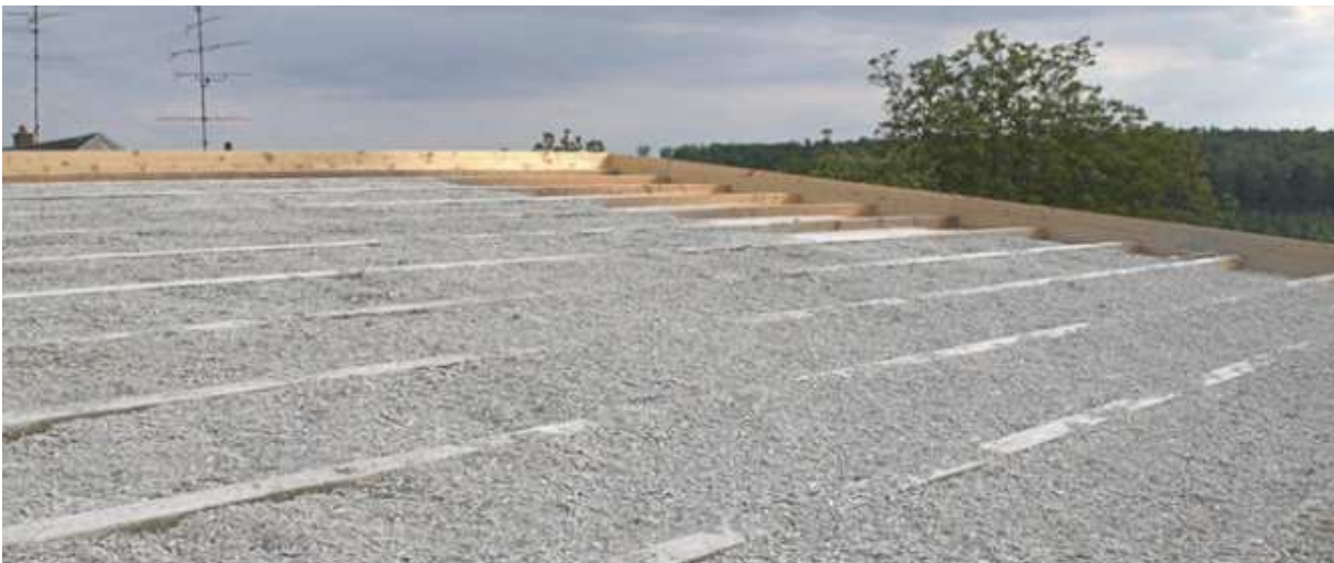
Fig. 3.167 Isolamento della copertura realizzata con calcecanapulo a spruzzo, www.eviapartner.com
