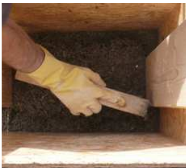
Fig. 3.102 Compattazione di muratura in calcecanapulo, Progetto INATER, foto, www.inater.net
