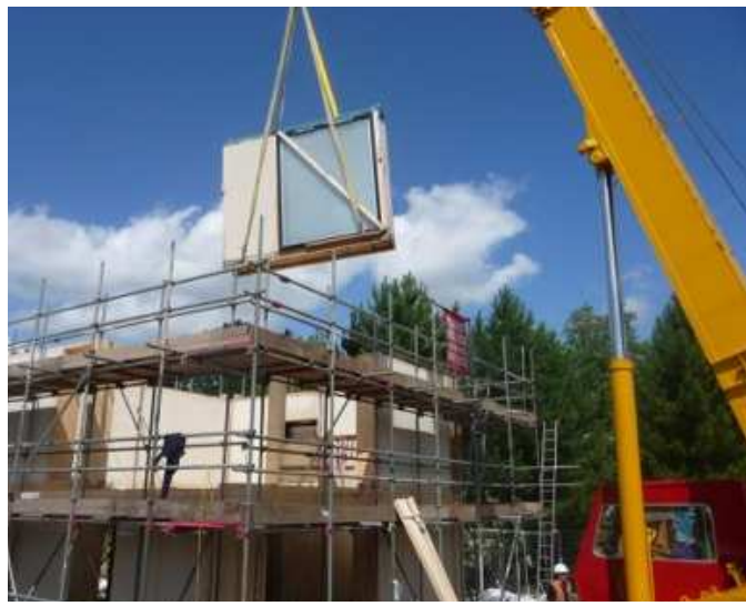
Fig. 3.219 Montaggio dei pannelli sul sito mediante
