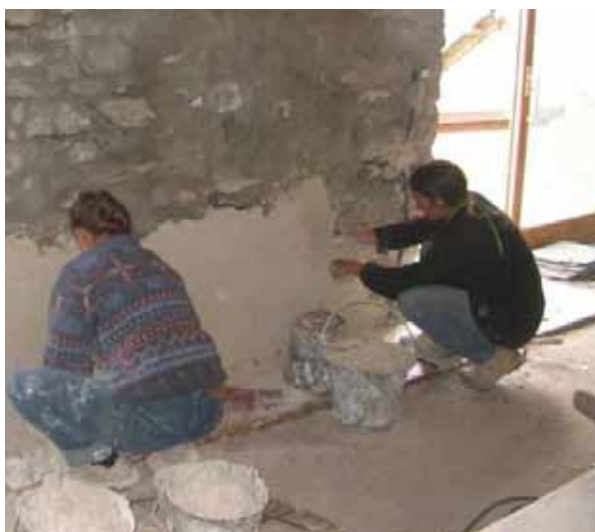
Fig. 3.116 Applicazione manuale di intonaco isolante, www.piedducol.canalblog.com
