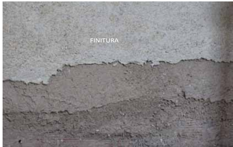
Fig. 3.121 I tre strati dell'intonaco di corpo in calcecanapulo
