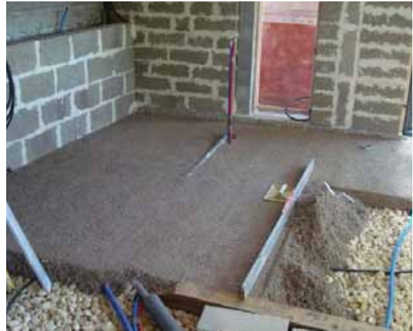
Fig. 3.171 Livellamento del massetto applicato a spruzzo www.db-chanvre
