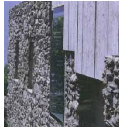
Fig. 5.12-5.13 Integrazione di una nuova struttura in quella preesistente in pietra a Umbau eines Wohnhauses, Chamoson
