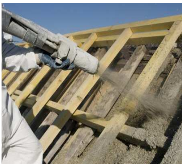
Fig. 3.164 Riempimento di superficie inclinata a spruzzo www.eviapartner.com
