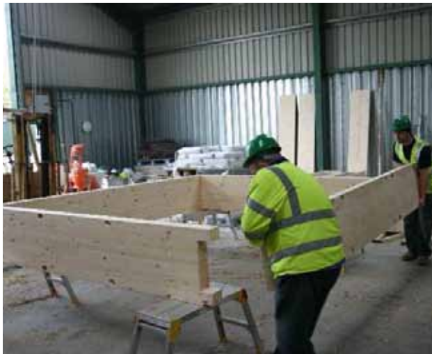
Fig. 3.216 Assemblaggio della struttura in legno
