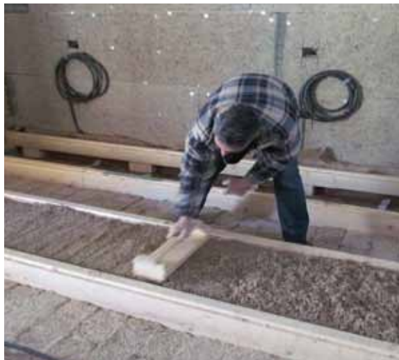
Fig. 3.72 Leggera compattazione
