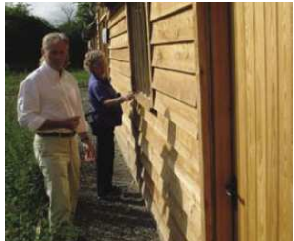
Fig. 3.14 Rivestimento in legno applicato a un muro di calcecanapulo, struttura esterna
