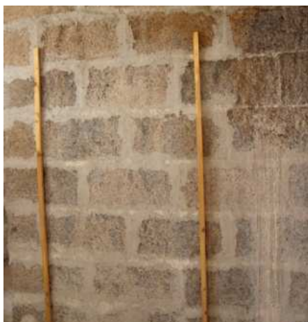
Fig. 3.130 Fissaggio dei listelli
