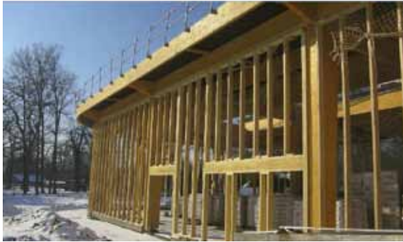
Fig. 3.156 Telaio in legno per nuova costruzione in calcecanapulo a spruzzo, www.batiethic.fr
