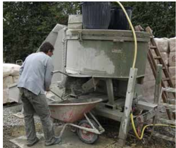
Fig. 3.59 Impasto per la realizzazione di un massetto calpestabile, miscelatore ad asse planetario, Batiethic
