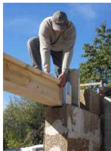
Fig. 3.182 Posizionamento dell'architrave sopra l'apertura, www.solaia.fr
