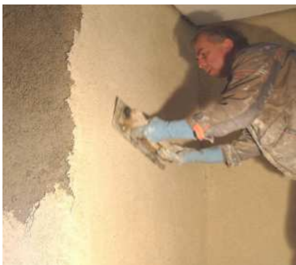
Fig. 3.139 Intonaco di finitura, Zaccanti O., (2011) Presentazione Isolanti Naturali, ANAB
