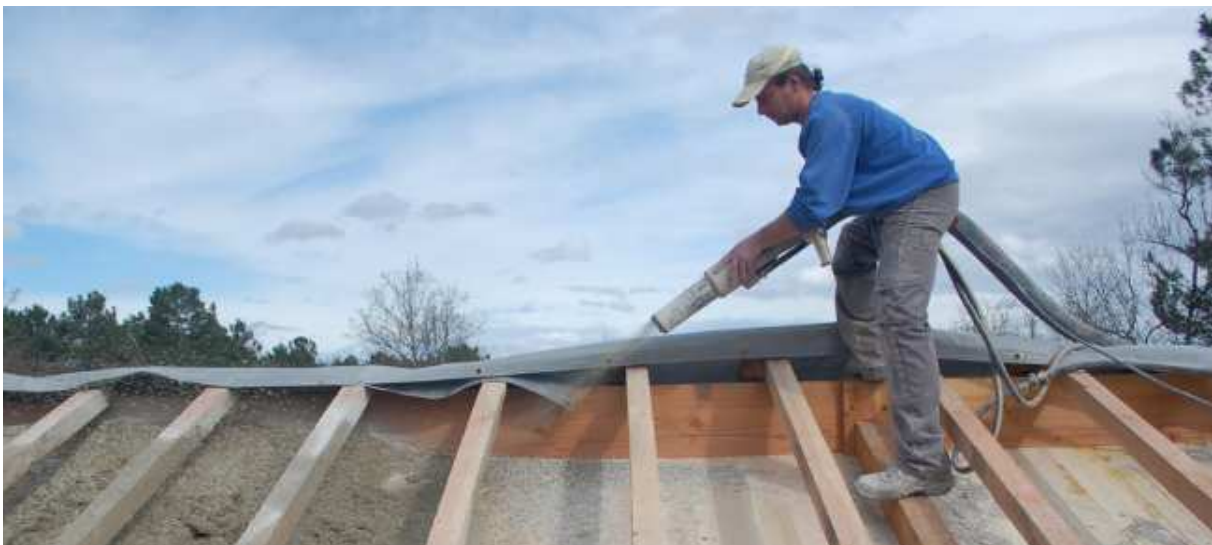
Fig. 3.168 Riempimento di copertura con calcecanapulo a spruzzo da www.eviapartner.com
