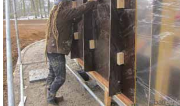
Fig. 3.157 Montaggio del sistema di cassetteria per spruzzo, www.batiethic.fr
