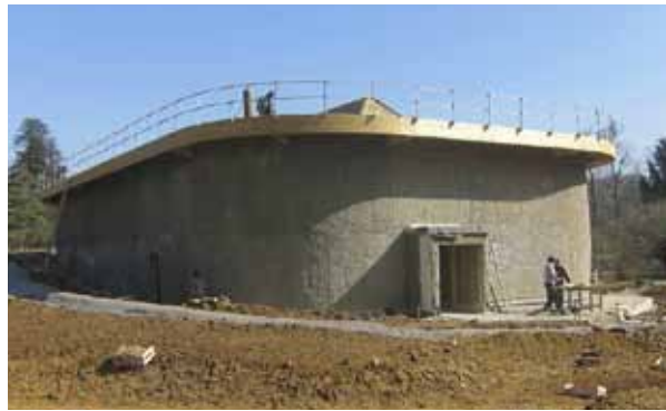
Fig. 3.159 Posa a spruzzo completata, 600 mq totali di calcecanapulo, www.batiethic.fr
