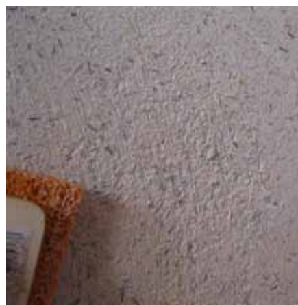
Fig. 3.141 Lavorazione lamata o con frattazzo a spugna
