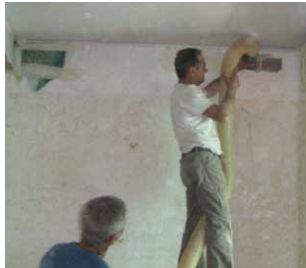
Fig. 3.49-3.50 Macchina insufflatrice, prove insufflaggio di canapulo, Arch. S.Sabbadini
