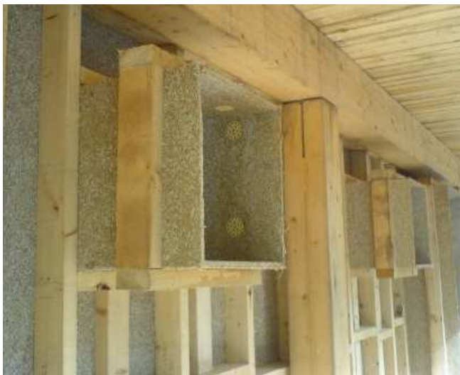
Fig. 4.7 Casseri a perdere realizzati in pannelli Eraclit
