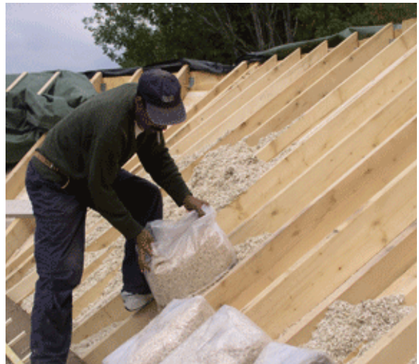
Fig.1.28 Riempimento del tetto con canapulo Canosmose
