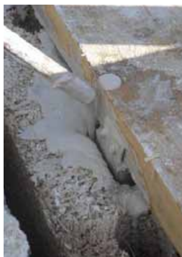
Fig. 3.181 Sigillatura con latte di calce, www.solaia.fr
