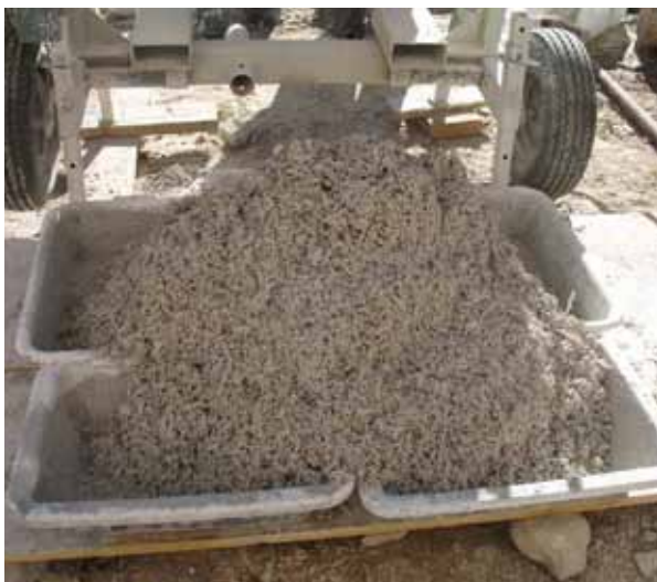
Fig. 1.29 Impasto di calcecanapulo pronto per la messa in opera
