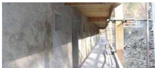
Fig. 4.8 Parete in calcecanapulo contro pannelli Eraclit
