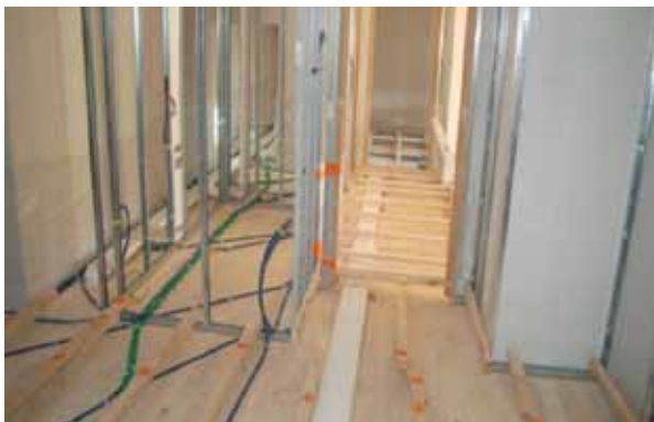
Fig. 3.37-3.38 Impianti sull'assito in legno di un solaio interpiano
