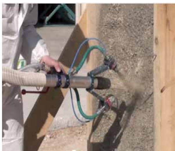
Fig. 3.54 Prova di spruzzo contro un supporto con la macchina Euromair
