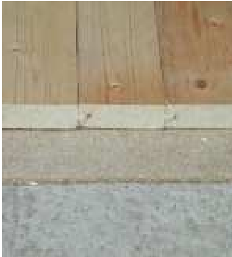
Fig. 1.15 Sottofondo prepavimento a secco
