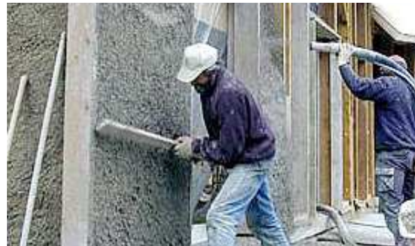
Fig. 3.161 Livellamento con una staggia Da www.db-chanvre.com
