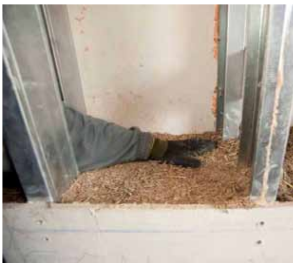
Fig. 3.85 Riempimento fra pannelli, Equilibrium, (2012) Presentazione Cantiere Scuola ANAB, tecniche in calce e canapa
