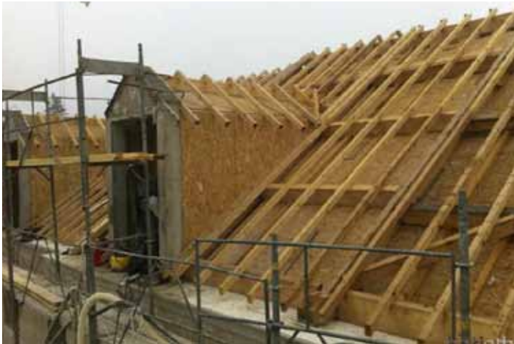
Fig. 3.165-3.166 Struttura della copertura per spruzzo del calcecanapulo , www.batiethic.fr
