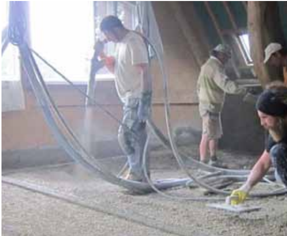
Fig. 3.170 Spruzzo del massetto www.batiethic.fr
