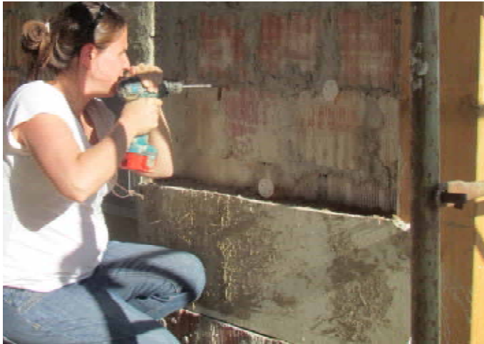
Fig. 3.110 Sistema di ancoraggio con tasselli, Seminario a Granara, 2012
