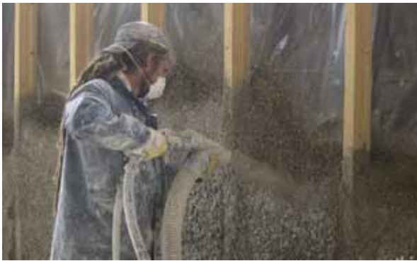
Fig. 3.158 Applicazione del calcecanapulo a spruzzo su cassero (30 cm), www.batiethic.fr
