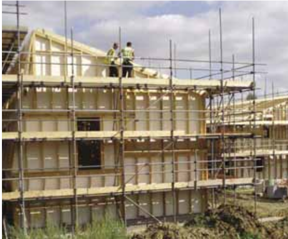
Fig. 3.9 Sistema ad intelaiatura pronto per lo spruzzo
