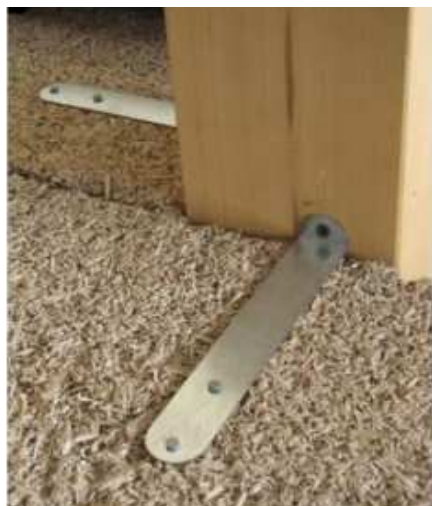
Fig. 3.199 Aggancio alla struttura portante
