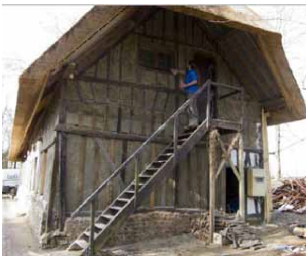
Fig. 3.7 Tamponamenti di una vecchia struttura a traliccio
