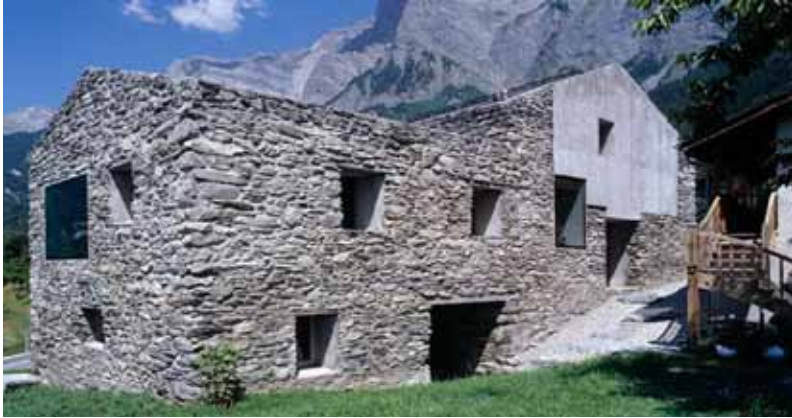
Fig. 5.12-5.13 Integrazione di una nuova struttura in quella preesistente in pietra a Umbau eines Wohnhauses, Chamoson
