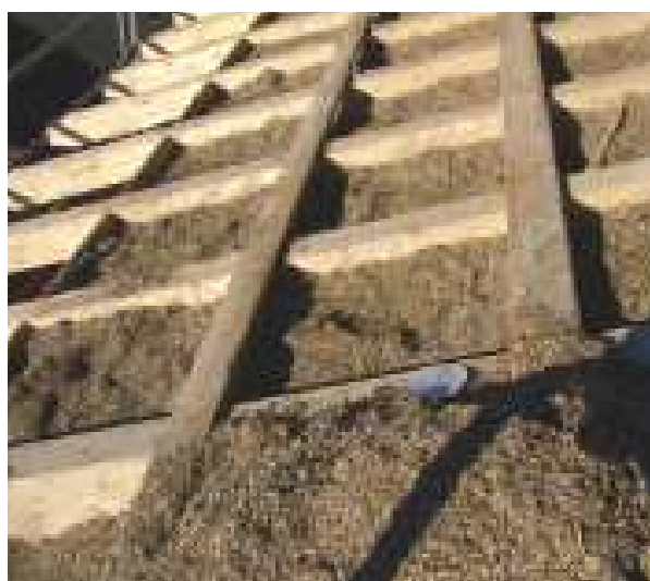
Fig. 3.80 Riempimento a cassettoni, Zaccanti O., (2011), Presentazione Isolanti Naturali, ANAB
