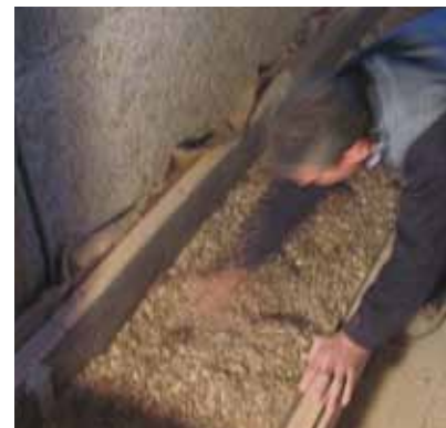
Fig. 3.77 Livellamento in strati da 5 cm
