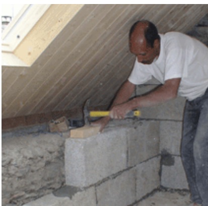
Fig. 3.194 Controparete interna in blocchi
