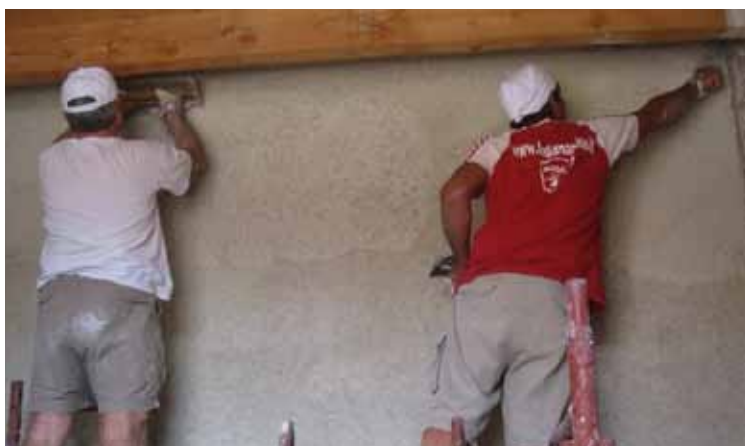
Fig. 3.140 Posa a due mani con il frattazzo americano
