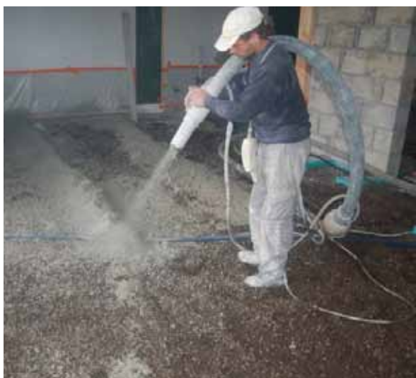
Fig.169 Massetto a spruzzo da www.db-chanvre.com
