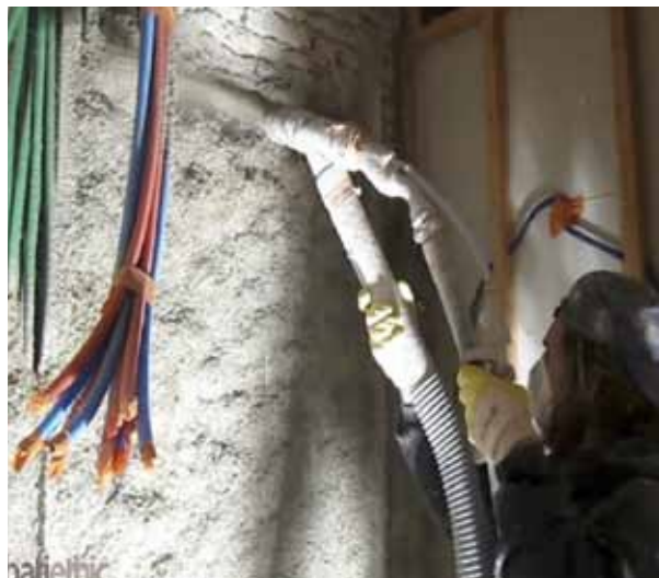
Fig. 3.52 Spruzzo con la macchina di Batiethic
