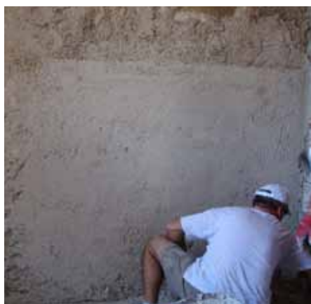
Fig. 3.132 Posa del copro d'intonaco
