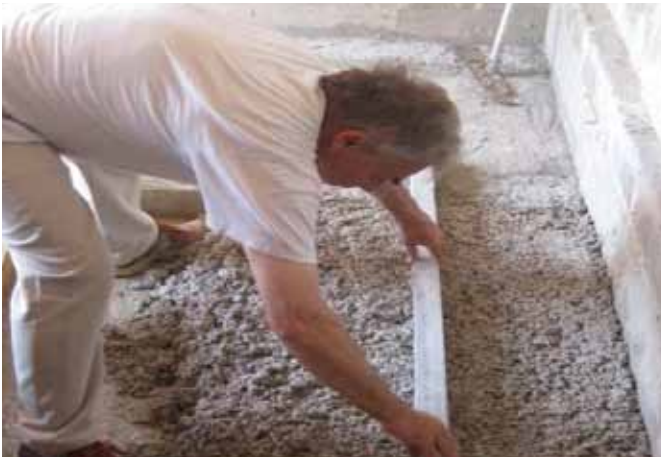
Fig. 3.93 Livellamento, ANAB, (2011), Presentazione Cantiere Scuola: isolanti naturali, S.Matteo della Decima
