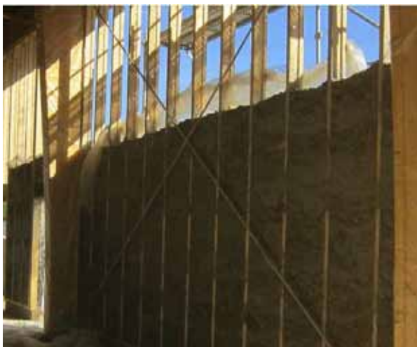
Fig. 3.13 Calcecanapulo su sistema ad intelaiatura, controventatura con tiranti in acciaio
