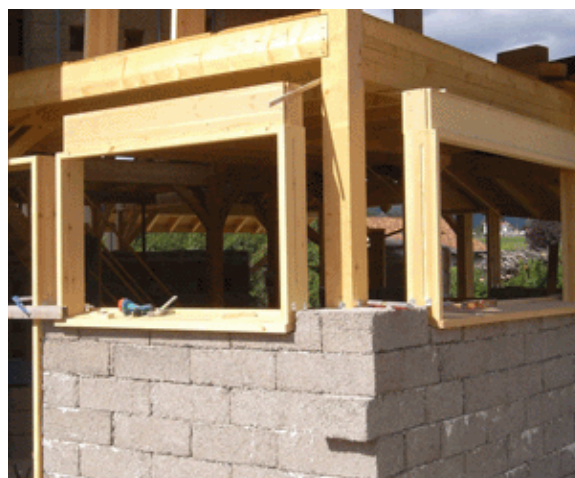
Fig. 3.202 Posizionamento del serramento
