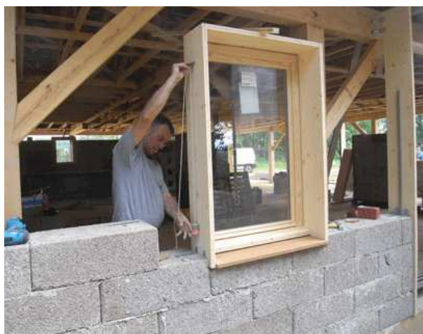
Fig. 3.201 Inserimento del serramento
