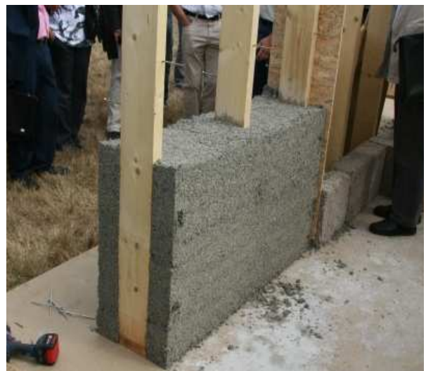
Fig. 1.30 Muro realizzato in calcecanapulo
