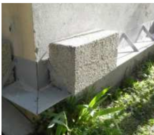
Fig. 3.190 Rialzo in lamiera zincata
