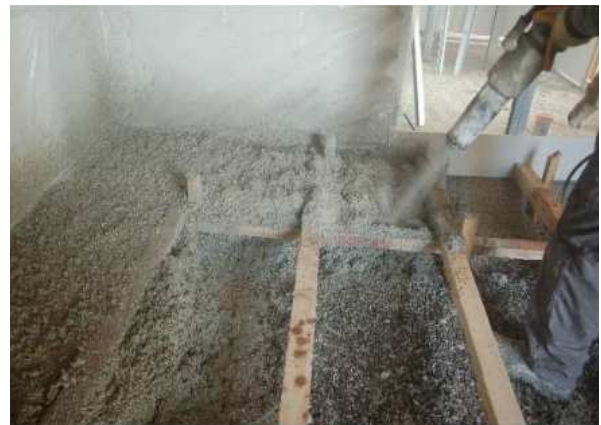
Fig. 3.173 Spruzzo del massetto in calcecanapulo tra listelli www.db-chanvre.com
