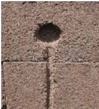
Fig. 3.32-3.33-3.34 Scanalature nei blocchi pieni in calcecanapulo Chanvribloc
