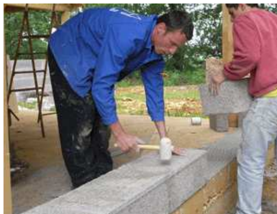
Fig. 3.198 Posa della prima fila di blocchi
