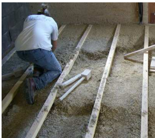
Fig. 3.69 Riempimento manuale del solaio con calcecanapulo
