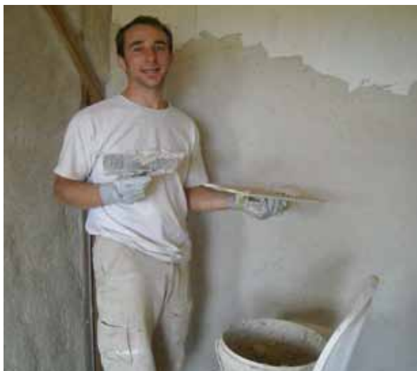
Fig. 4.10 Intonaco di finitura in calcecanapulo su un pannello in gessofibrato
