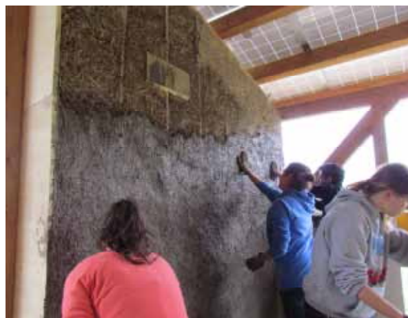
Fig. 5.7 Realizzazione di intonaci in terra cruda, seminario Maggio 2012
