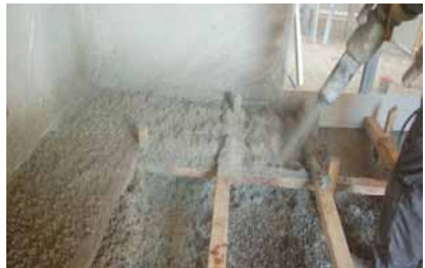
Fig. 3.35-3.36 Impianti sul solaio controterra in massciata in ghiaia (tipico vespaio areato francese)
