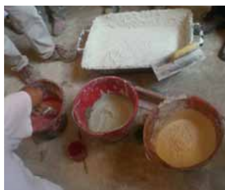
Fig. 3.143 Colorazione in pasta
