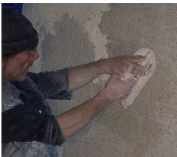
Fig. 3.134 Applicazione di intonaco di finitura, www.inater.it
