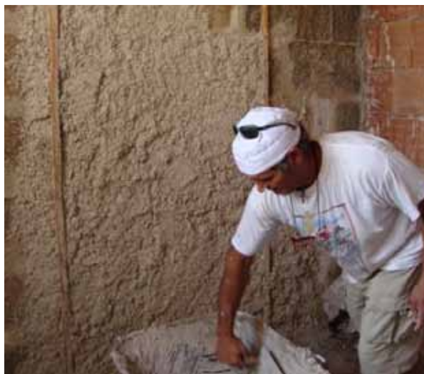
Fig. 3.129 Applicazione manuale dell'intonaco di corpo, ANAB, (2011), Presentazione Cantiere Scuola: isolanti naturali, S.Matteo della Decima
