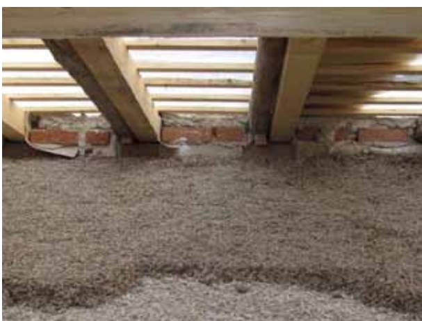
Fig. 3.100 Massetto isolante del sottotetto
