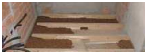
Fig. 4.4 Riempimento del vano tecnico del solaio con isolate sfuso.
