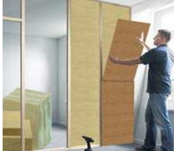
Fig. 1.22 Isolamento parete con pannello Canaton
