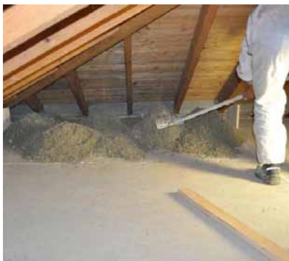
Fig. 3.97 Massetto isolante in calcecanapulo, Dispensa corso Equilibrium (2011), Costruire e ristrutturare con calce e canapa
