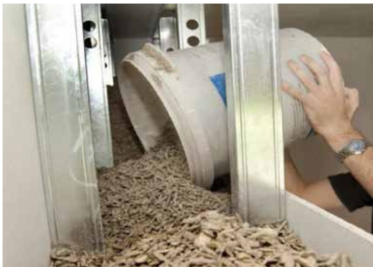
Fig. 4.13 Riempimento con calcecanapulo di una chiusura verticale realizzata in pannelli Megapan
