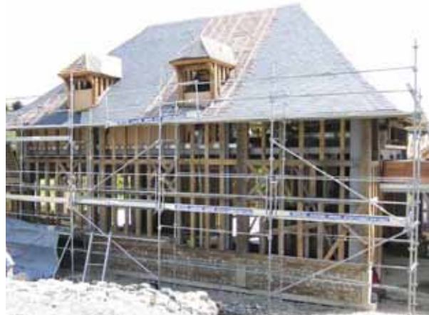
Fig. 3.2 Applicazione della struttura in legno
