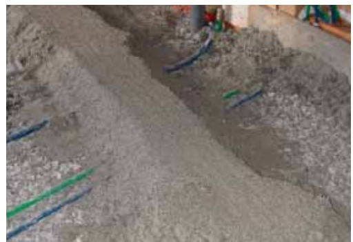
Fig. 3.35-3.36 Impianti sul solaio controterra in massciata in ghiaia (tipico vespaio areato francese)
