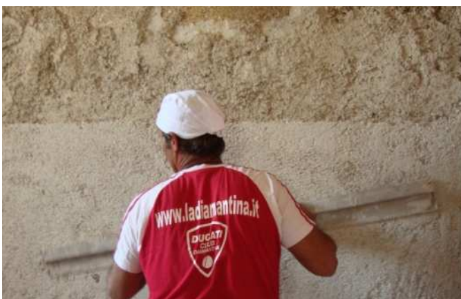
Fig. 3.133 Livellamento con la staggia
