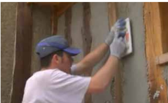
Fig. 3.162 Livellamento e raschiamento con un frattazzo a spugna, www.batiethic.fr
