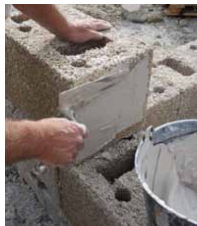
Fig. 3.179 Posa della prima fila di blocchi, www.solaia.fr
