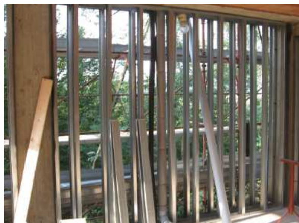
Fig. 3.87 Costruzione del telaio metallico
