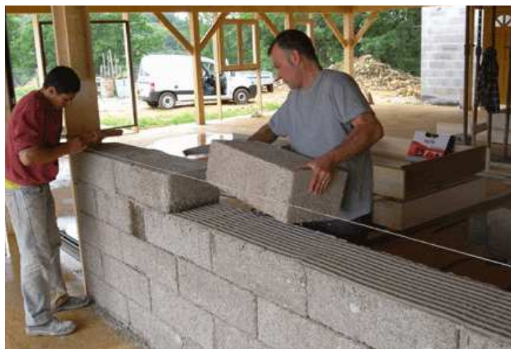
Fig. 3.200 Verifica di allineamento
