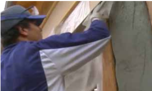
Fig. 3.160 Rimozione del cellofan dietro al cassero, www.batiethic.fr
