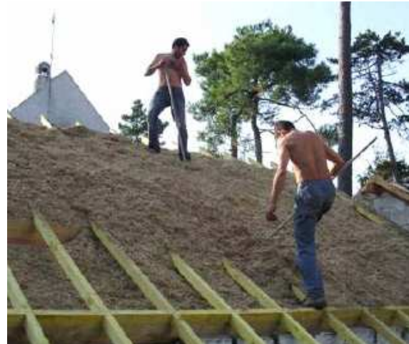
Fig. 3.83 Applicazione del calcecanapulo alla struttura a cassettoni da Zaccanti O., (2001), Usiamo le Energie
