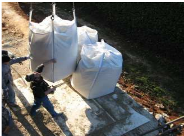
Fig. 3.86 Trasporto al punto di applicazione tramite big bag da 2,5 m 3
