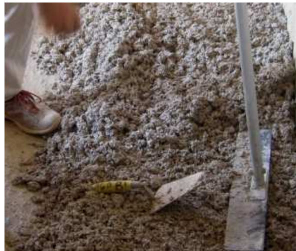
Fig. 3.92 Stesura del massetto, ANAB, (2011), Presentazione Cantiere Scuola: isolanti naturali, S.Matteo della Decima
