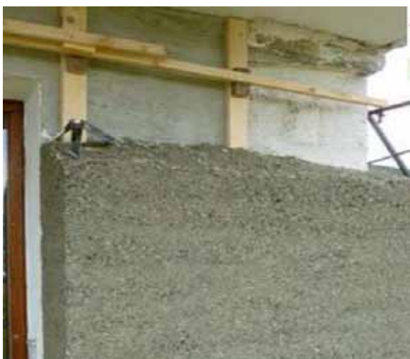
Fig. 3.114 Controparete con sistema di ancoraggio in legno, Dispensa corso Equilibrium, (2011), Costruire e ristrutturare con calce e canapa
