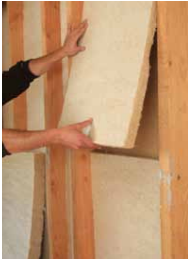
Fig. 4.15 Isolamento termico con pannelli flessibili in fibra di canapa
