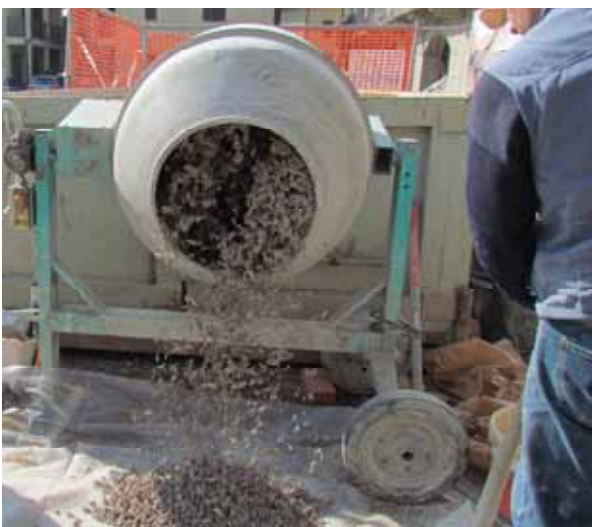
Fig. 3.60-3.61 Miscelazione con betoniera classica
