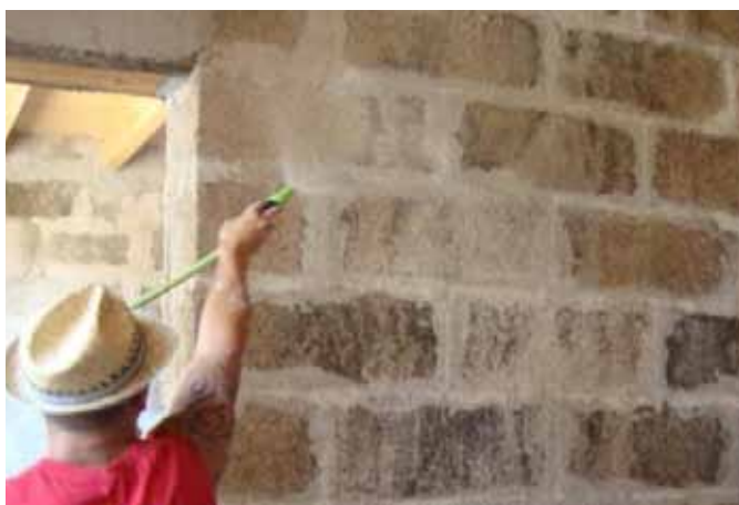
Fig. 3.131 Bagnatura a completo imbevimento della parete
