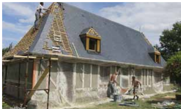
Fig. 3.163 Ristrutturazione struttura a traliccio con calcecanapulo a spruzzo, www.batiethic.fr
