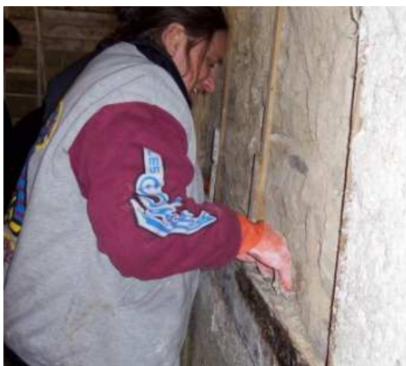
Fig. 3.122 Getto manuale di intonaco isolante, Progetto INATER, www.inater.net
