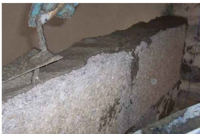
Fig. 3.191 Applicazione dello strato di malta per il fissaggio dei mattoni
