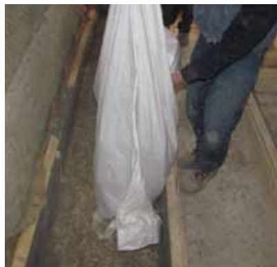
Fig. 3.76 Distribuzione del canapulo sfuso nelle campate
