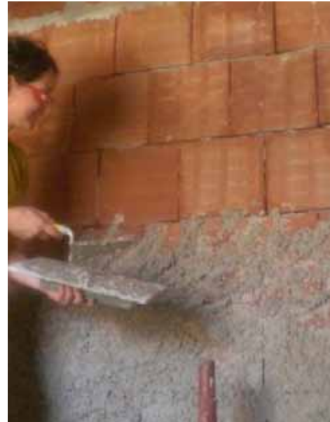
Fig. 3.119 Applicazione del rinforzo
