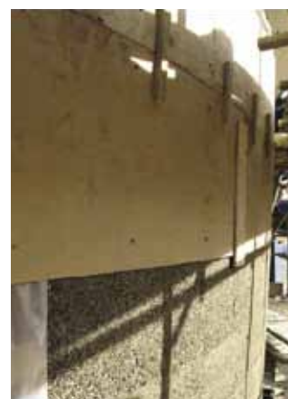
Fig. 3.108 muratura in calcecanapulo
