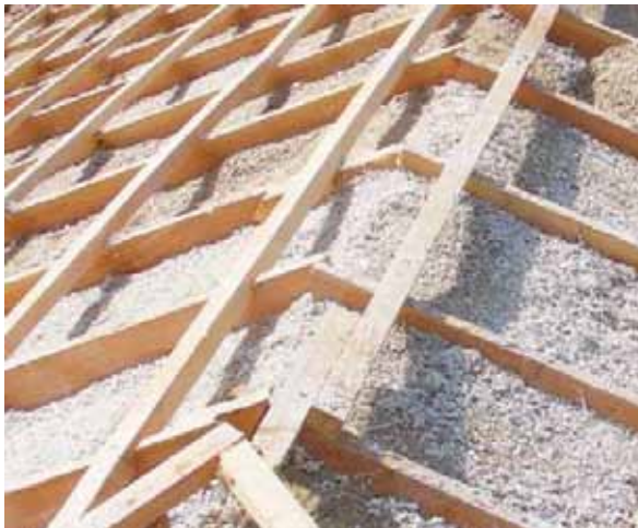
Fig. 3.81 Riempimento in calcecanapulo con doppia orditura di listelli in legno, www.equilibrium-bioedilizia.it
