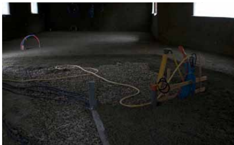
Fig. 3.174 Massetto realizzato a spruzzo, www.batiethic.fr
