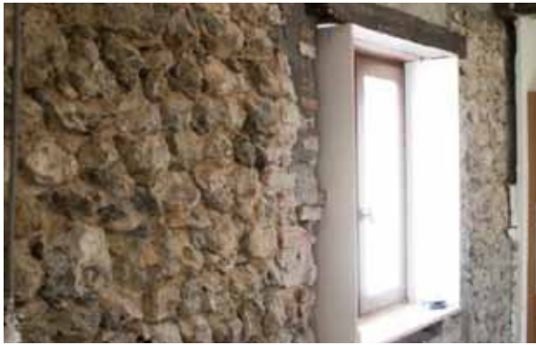
Fig. 3.147-3.148 Controparete interna in calcecanapulo (10 cm) realizzata a spruzzosu muro in pietra, www.batiethic.fr
