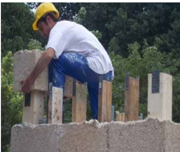
Fig. 3.19 Struttura interna ai blocchi forati in calcecanapulo
