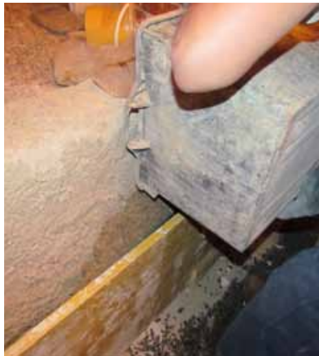
Fig. 3.112 Getto manuale della controparete, Ponzoni L., Sorek Y., (2012), Casatenovo
