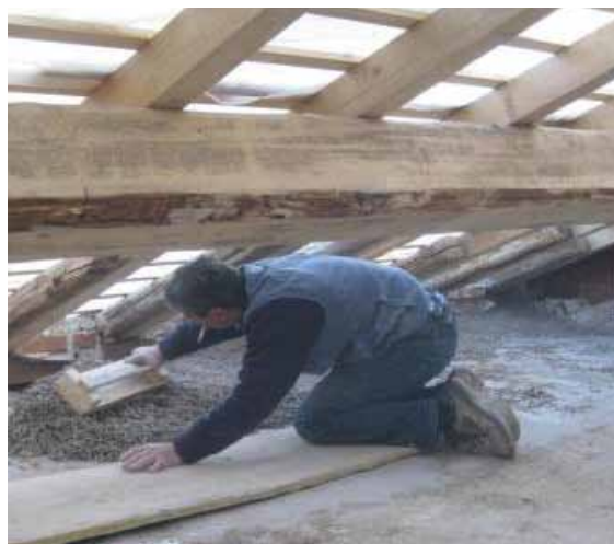
Fig. 3.99 Applicazione dek massetto isolante sul solaio
