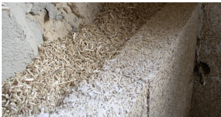
Fig. 3.195 Riempimento dell'intercapedine tra muro e blocchi con canapulo sfuso
