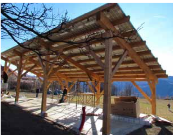
Fig. 5.9 Tettoia fotovoltaica
