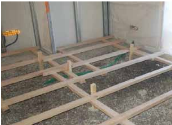
Fig. 3.172 Applicazione dei listelli in legno www.db-chanvre.com
