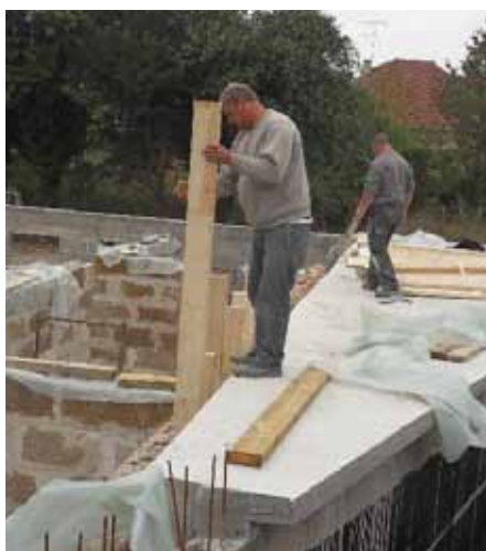
Fig. 3.180 Posa dei montanti prefabbricati, www.solaia.fr
