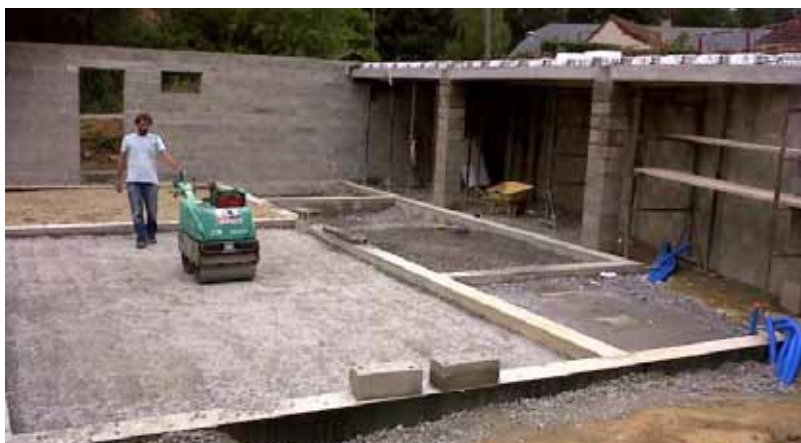
Fig. 3.178 Realizzazione del basamento, www.solaia.fr
