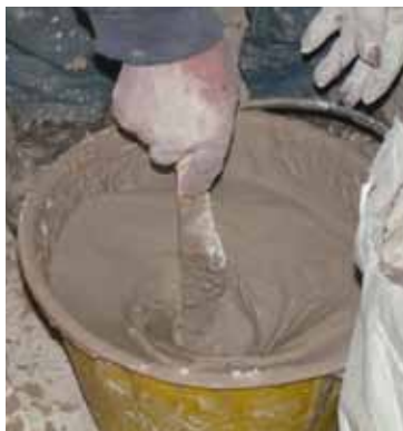
Fig. 3.75 Preparazione della boiaccia di calce
