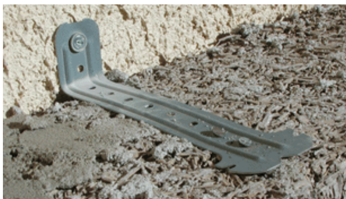
Fig. 3.193 Staffa metallica di fissaggio dei blocchi alla parete
