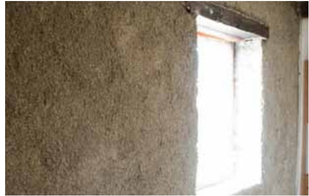
Fig. 3.147-3.148 Controparete interna in calcecanapulo (10 cm) realizzata a spruzzosu muro in pietra, www.batiethic.fr
