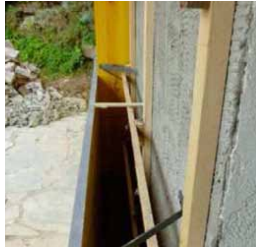
Fig. 3.111 Sistema di ancoraggio in legno, Dispensa corso Equilibrium, (2011), Costruire e ristrutturare con calce e canapa
