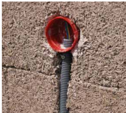
Fig. 3.32-3.33-3.34 Scanalature nei blocchi pieni in calcecanapulo Chanvribloc
