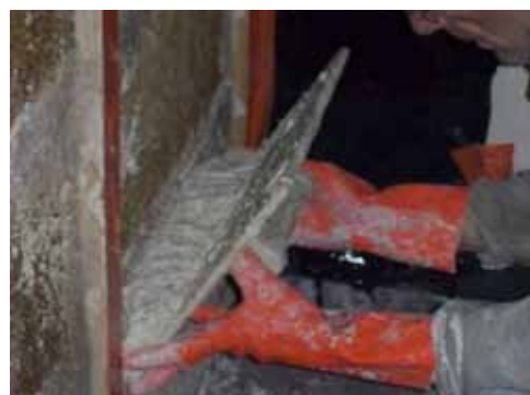
Fig. 3.136 Applicazione dell'intonaco di finitura
