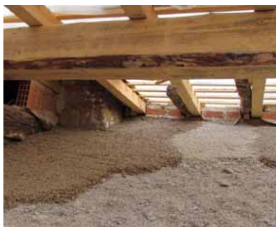
Fig. 3.101 Massetto isolante del sottotetto
