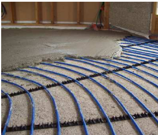
Fig. 3.95 Posa del massetto di calce e sabbia da Technichanvre, Cahier_techniques_DALLAGE, www.technichanvre.com
