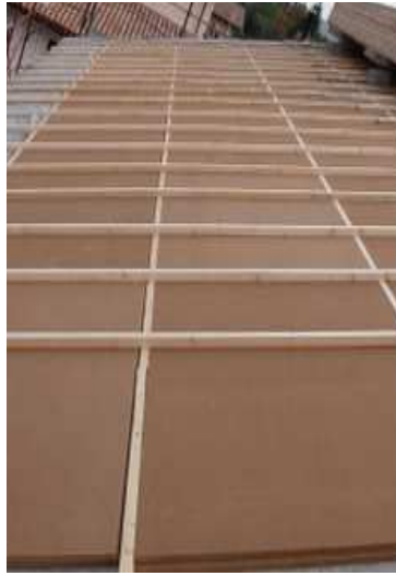
Fig. 4.16 Pannello in fibra di legno ad elevata densità >250 \text{ kg/m}^3
