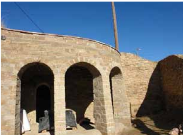
Fig. 3.210-211 Risultati a posa ultimata
