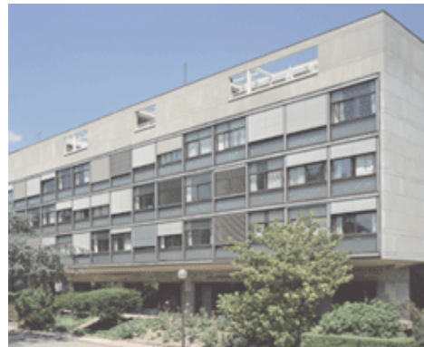
figura 125 - ingresso all'edificio. figura 126 - prospetto longitudinale e del particolare trattamento di facciata.
