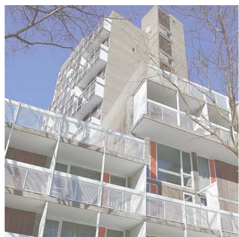
figura 143 - prospetto sud della torre. figura 144 - particolare delle balconate lungo la facciata.
